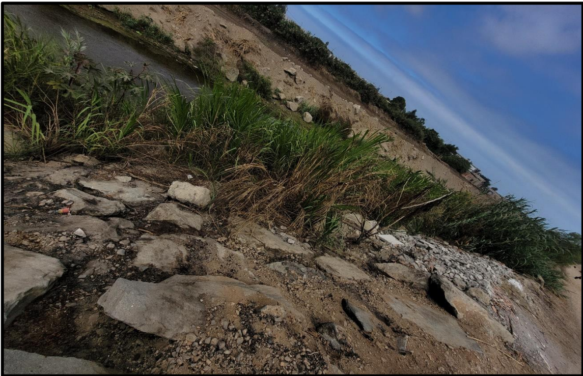
Figura 25: Tercer tramo evaluado entre las progresiva 1+200 a 1+300.
