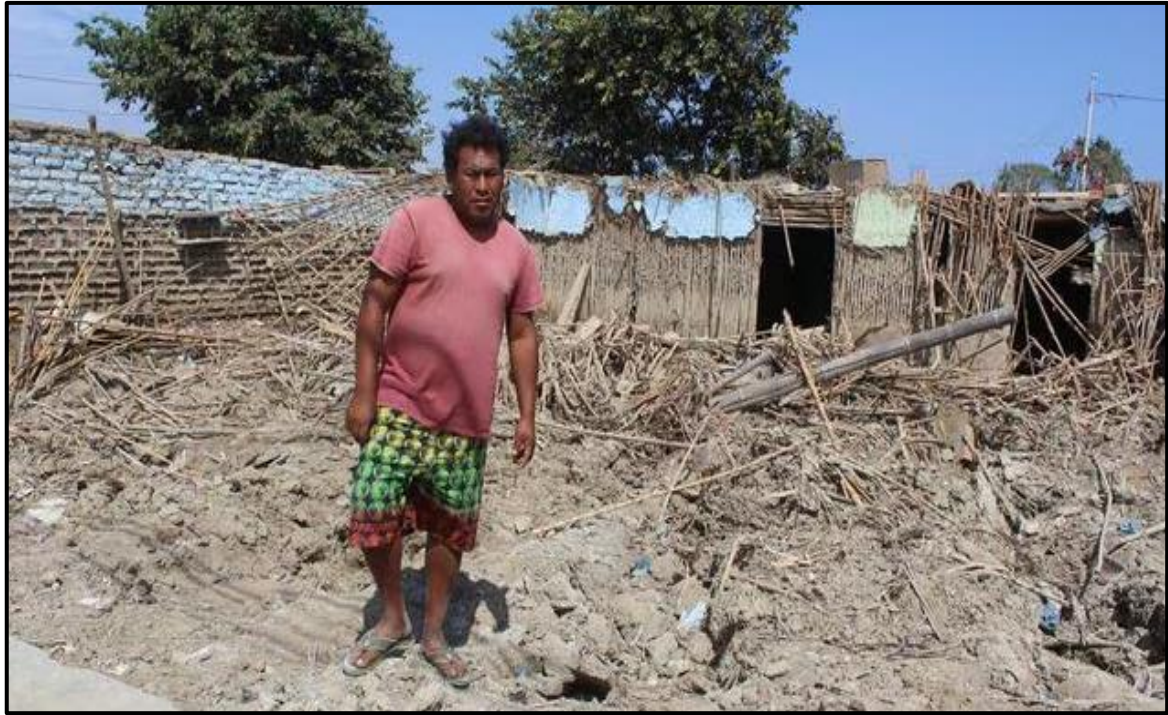
Figura 18: Vivienda colapsada por el desbordamiento del río Huarmey.
