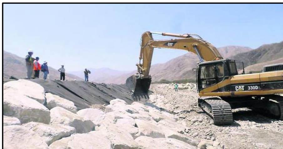
Figura 11: formas de colocación de enrocados
