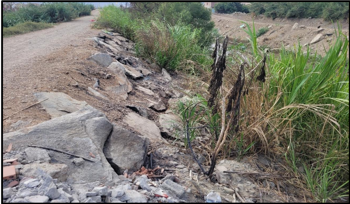
Figura 26: Enrocado entre las progresiva 1+200 a 1+231 de la margen derecha.
