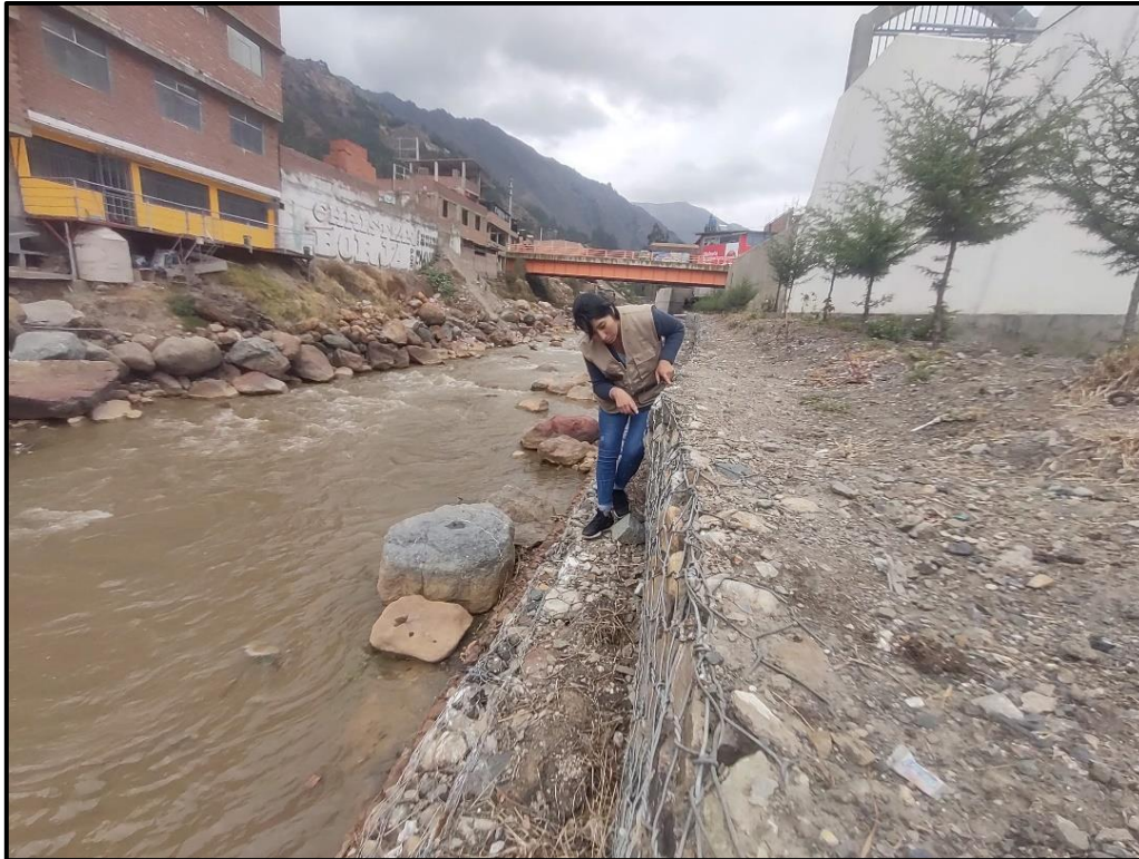
Fotografía 4: Evaluación del Margen izquierda del Rio Mosna.
