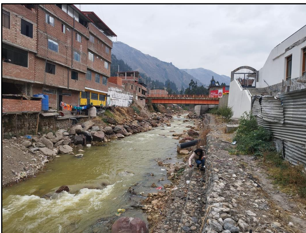
Fotografía 2: Evaluación del Margen izquierda del Rio Mosna en el Puente Laos.
