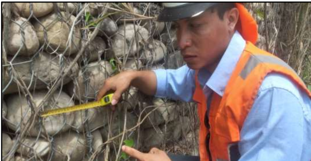
Figura 24: Material de relleno dentro de las cajas del muro de gaviones oscila entre 7" y 8" de diámetro.
