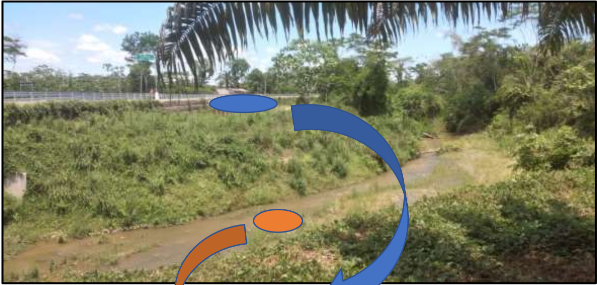
Figura 23: Progresiva 0+1000 a 0+1100 de muro de gaviones (vista panorámica)
