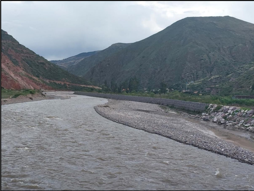
Figura 11 - Foto panorámica de la defensa ribereña Fuente: Elaboración Propia 2024
