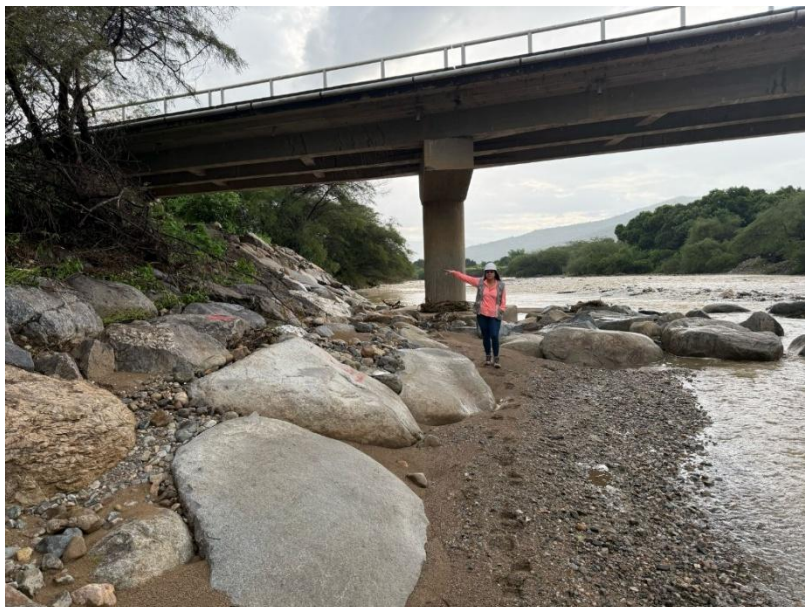
Figura 12: Se aprecia estructura de enrocado en defensa ribereña de Río Puzmalca, las rocas miden entre 0.80m y 1.30m, así como también hay presencia de vegetación en la zona.
