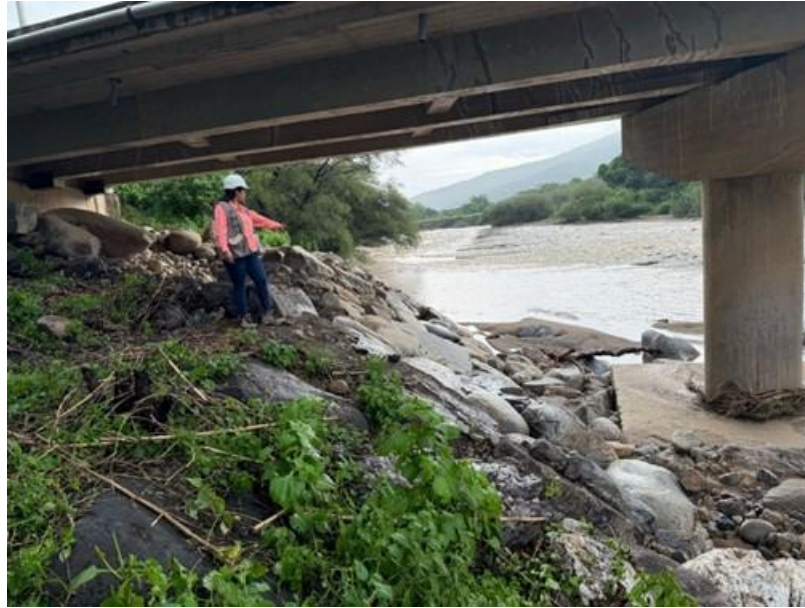
Figura 11: Se aprecia estructura de enrocado en defensa ribereña de Río Puzmalca, las rocas miden entre 0.80m y 1.30m, así como también hay presencia de vegetación en la zona.
