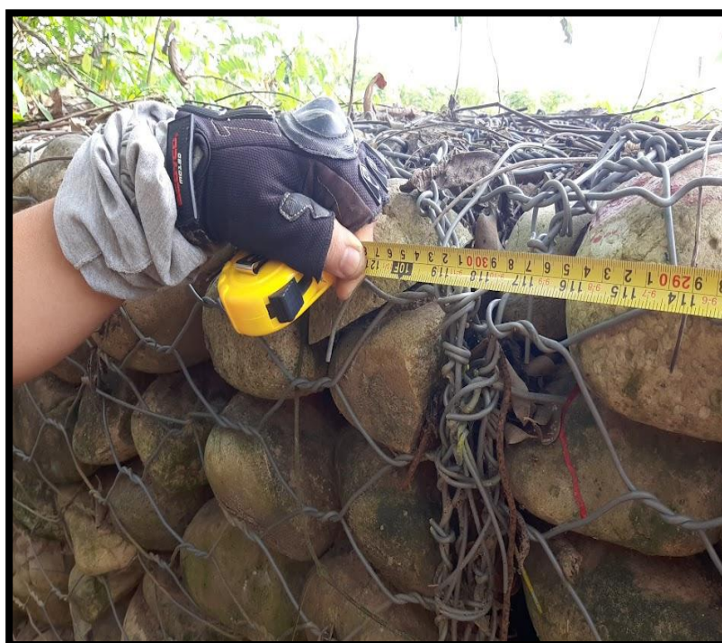
Figura 46: Vista de la medición con el flexómetro de la longitud de cada gavion
