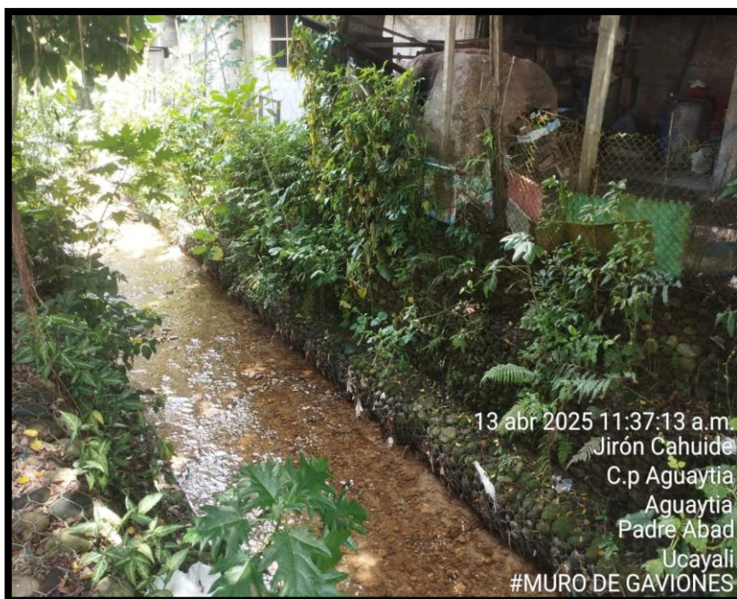
Figura 45: vista del muro de gaviones y edificaciones construidas en la parte superior
