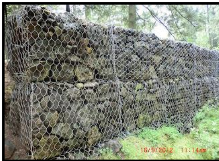
Figura 3: Muro de gaviones
