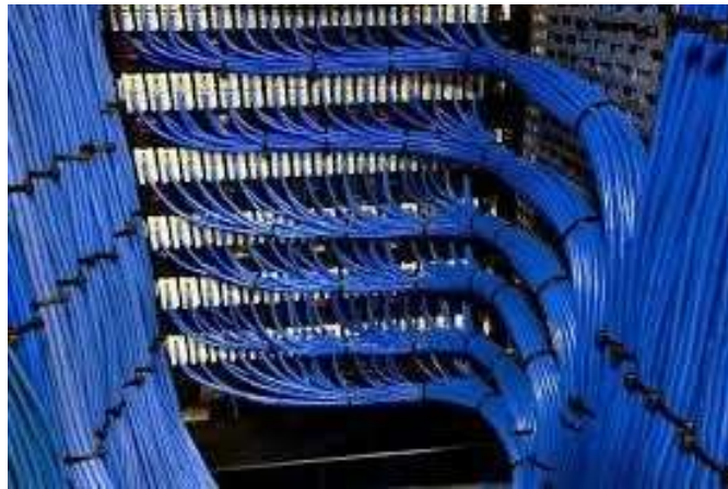
Gráfico Nro. 8: Cableado Estructurado
