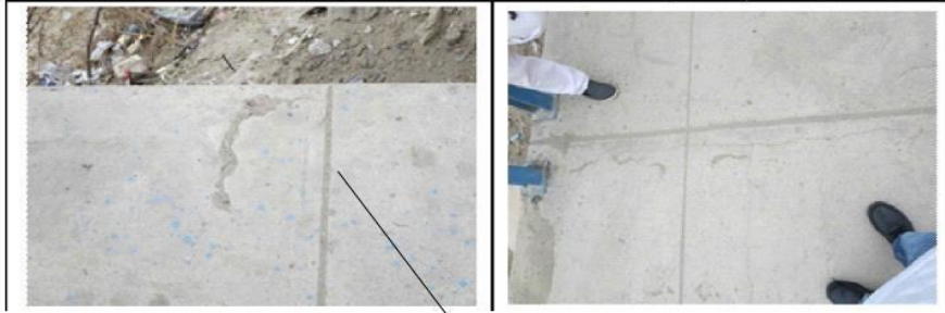
SE OBSERVA EL DESGASTE DE CONCRETO EN LA VEREDA
