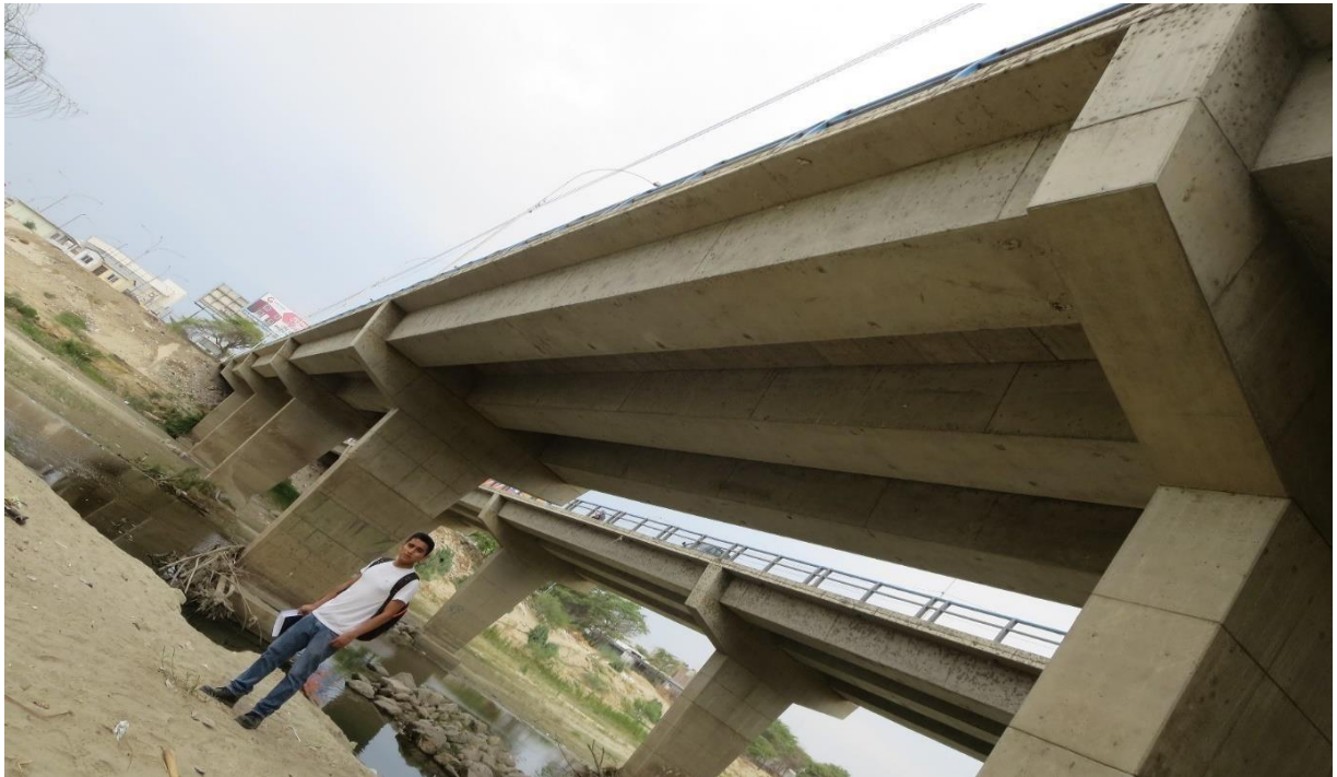
Anexo 02: PRIMERA VISITA EL PUENTE A. AVELINO CÁCERES FUENTE: ELABORACIÓN PROPIA.
