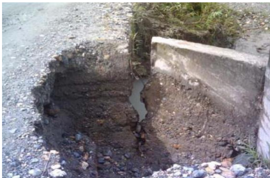
GRAFICO 33: VOLCAMIENTO DE UNA ALETA. PUENTE PACAMÍ, CHOCÓ. FUENTE: (INVIAS, 2006).
