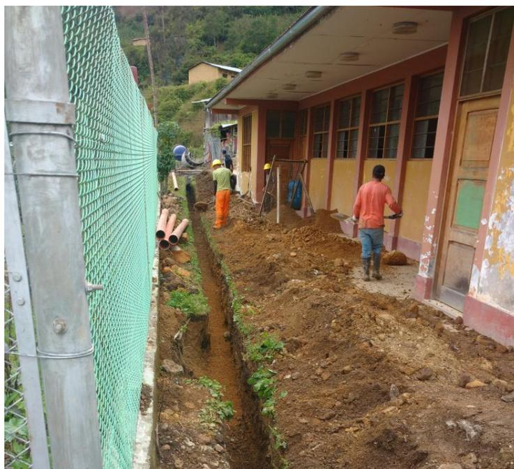
**Foto 11: En la foto se muestra el encamado en red colectora en la localidad de Toccate**
