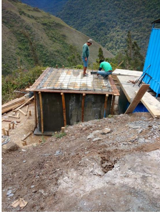
**Foto 07: Vemos el proceso de armado de acero para el techo de reservorio, en la localidad de Toccate.**
