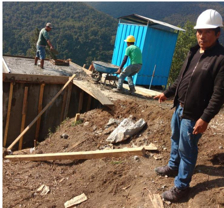
**Foto 08: En la foto podemos ver el vaciado de techo de reservorio en la localidad de Toccate**
