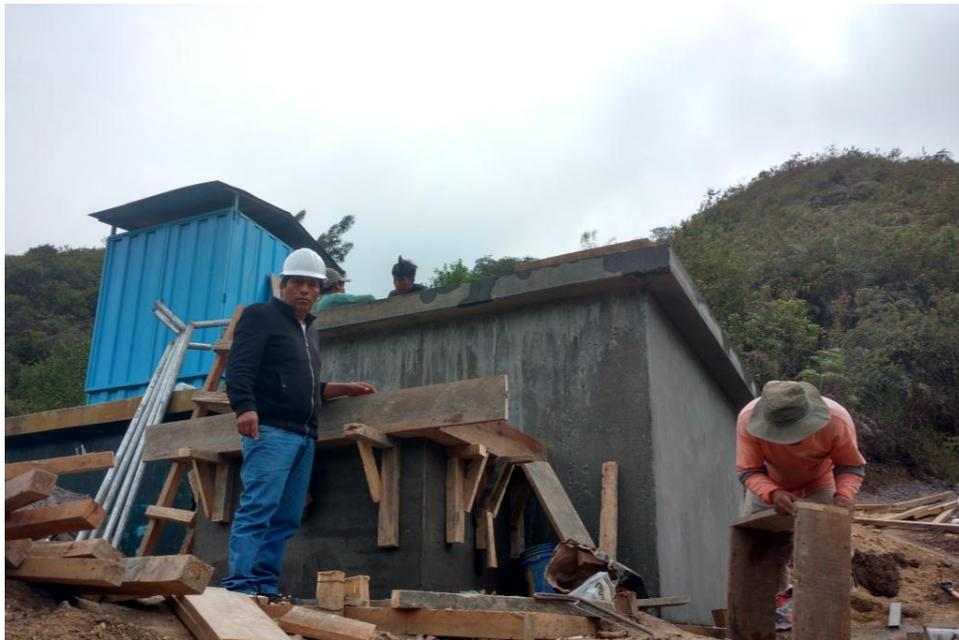
**Fotos 10:** La foto muestra el encofrado de techo de caja de válvulas de reservorio, en la localidad de Toccate.
