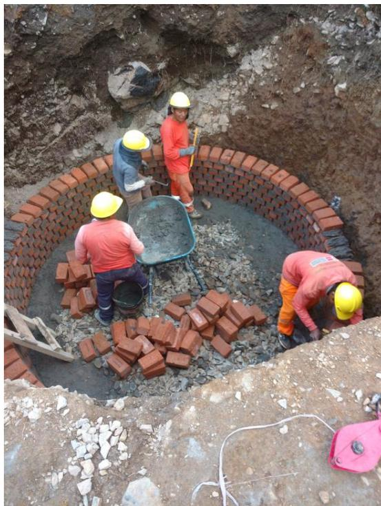
**Foto 14:** En la foto podemos ver el asentado de ladrillo en pozo percolador, en la localidad de Ccollpa
