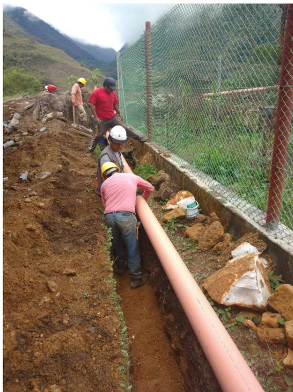
**Foto 12: En la foto podemos ver la colocación de tubería en red colectora, en la localidad de Toccate**
