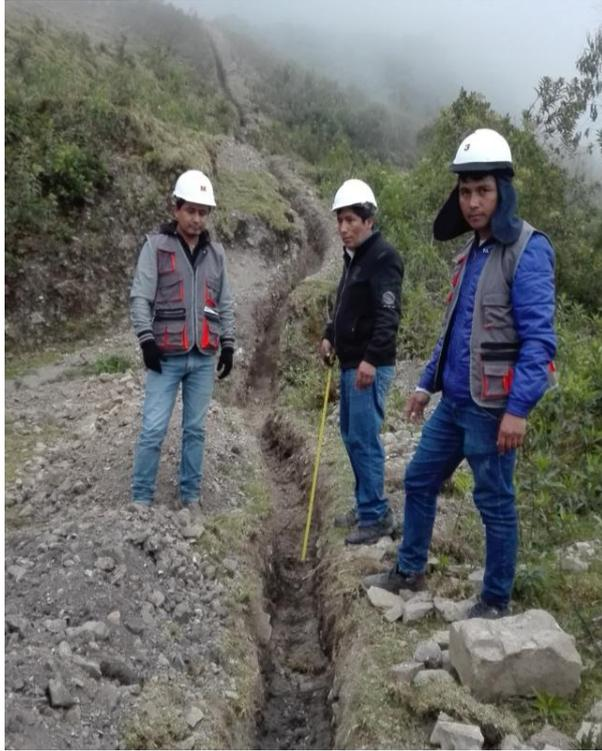
**Foto 05: Verificando excavación con flexometro.**
