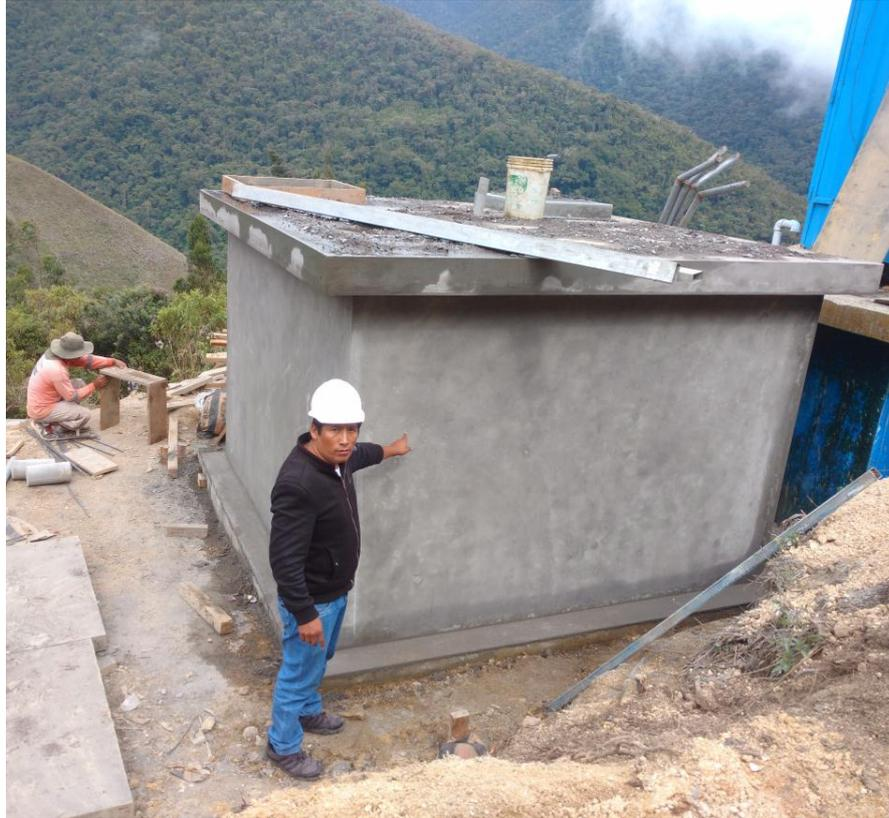
**Foto 09:** En la foto se muestra el tarrajeado de reservorio en la localidad de Toccate
