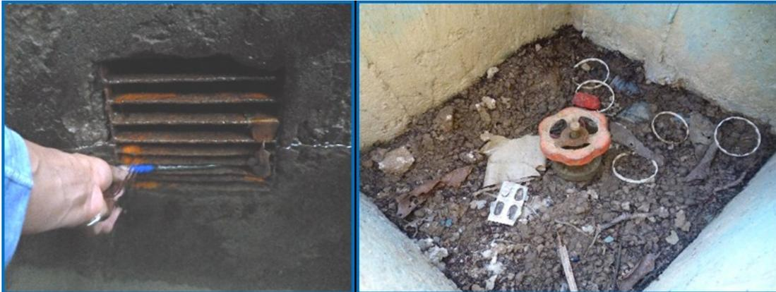
Figura 4.4: Infraestructura y accesorios en mal estado de la captación de Agua existente.
