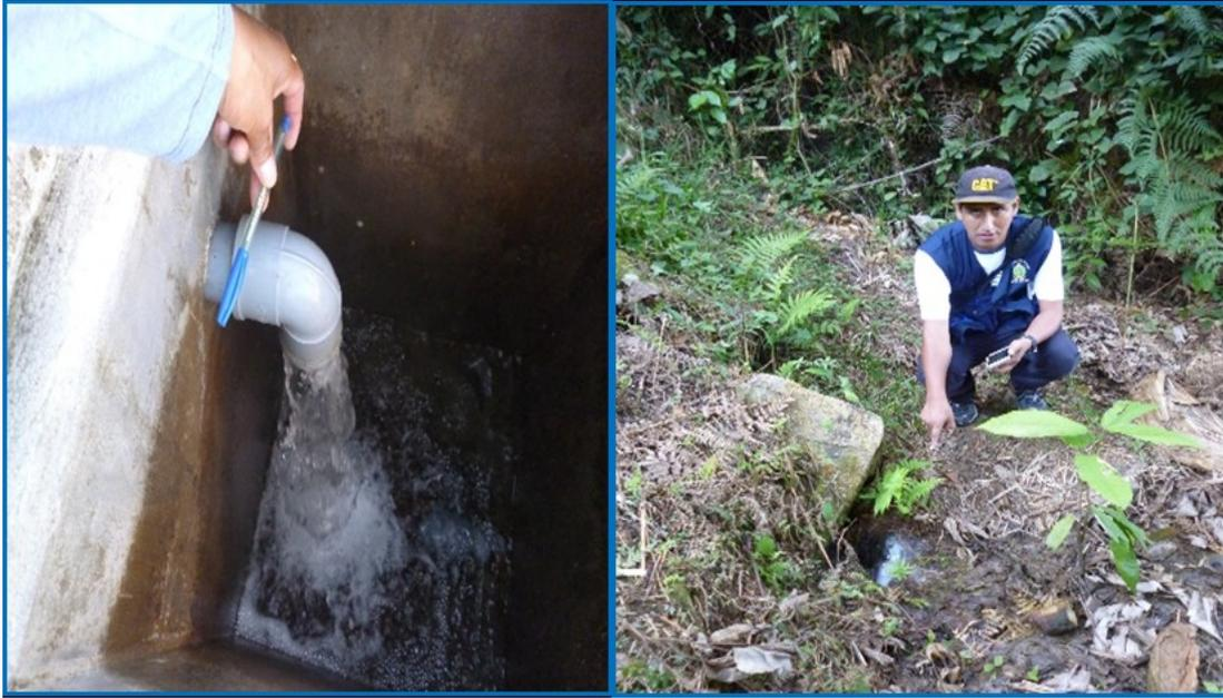
Figura 4.6: Caja rompe presión en la línea de Conducción existente en el anexo de Ccollpa.
