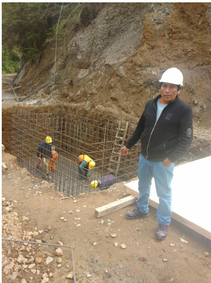
**Foto 15: En la foto podemos ver acero para tanque septico, en la localidad de Ccollpa**
