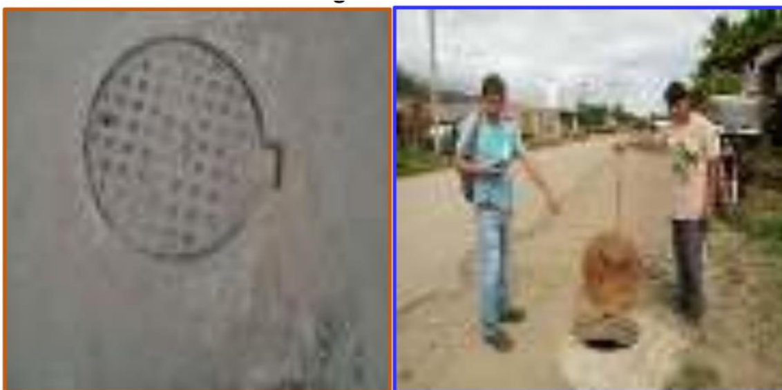
Figura. 27: Buzones actuales existentes como parte del sistema de alcantarillado en la comunidad de Otari San Martín.
