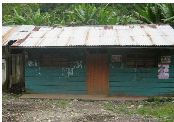
Figura. 12: Techo de calamina de las viviendas
