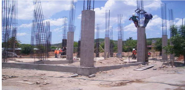
Figura 11: Columnas de concreto armado Fuente: ARQHYS- ARQUITECTURA
