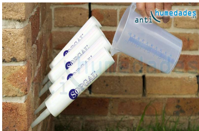
Figura 7: Inyección de barrera capilar líquida. Fuente: Tienda Virtual Anti-Humedades
