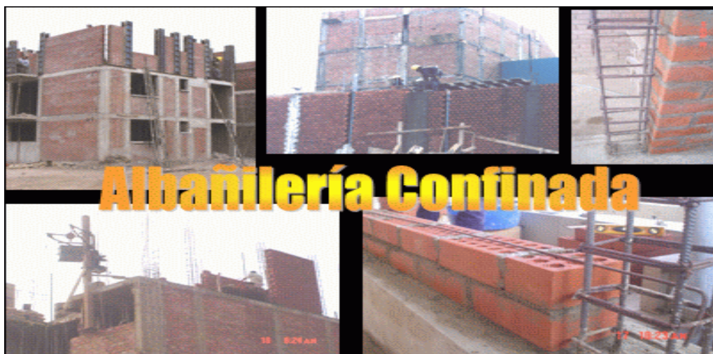
Figura 16: Albañilería confinada
