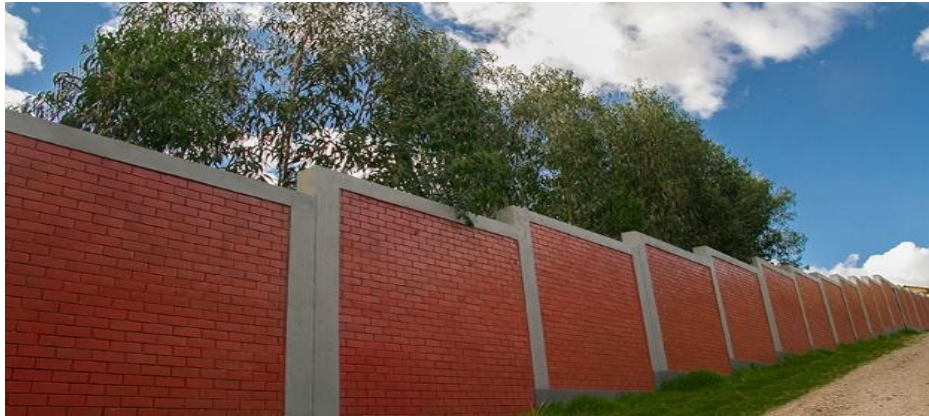
Figura 20: Cerco Perimétrico Fuente: COINSO – Constructora e Inversiones Soto S.A.C
