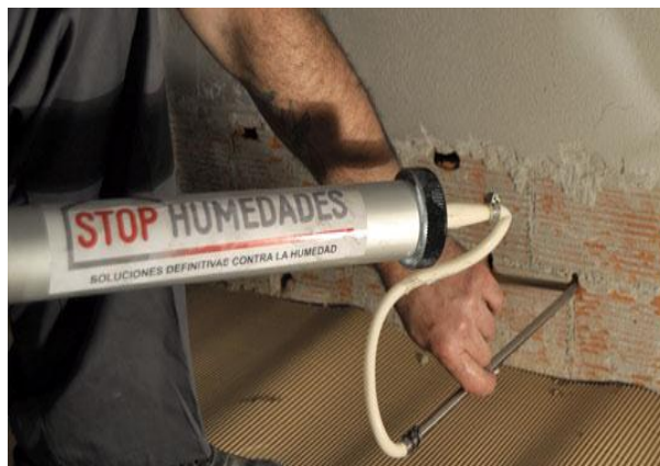
Figura 8: Inyectado químico anti humedad Fuente: Tienda Virtual STOP – Humedades
