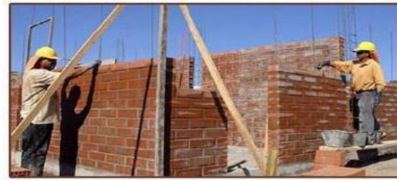
Figura 15: Muros de albañilería
