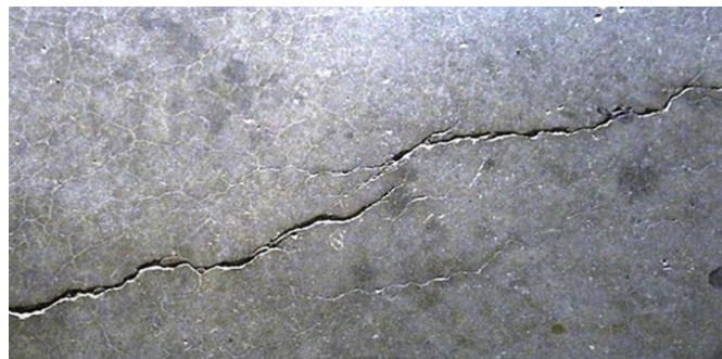
Figura 25: Fisuras
