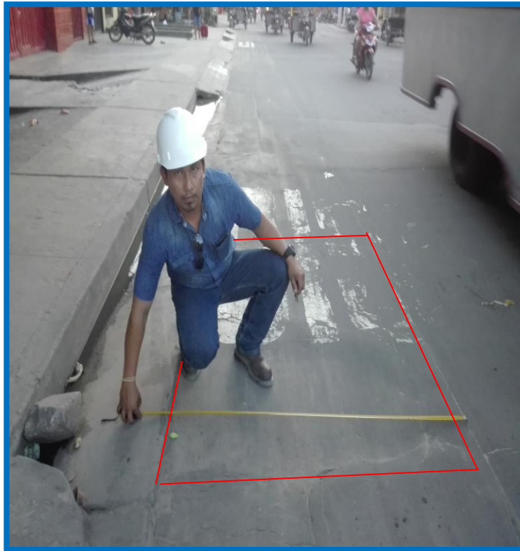
Foto N° 7: Vista de la patología 4 (hundimiento) en la UM9 de la Calle Túpac Amaru.
