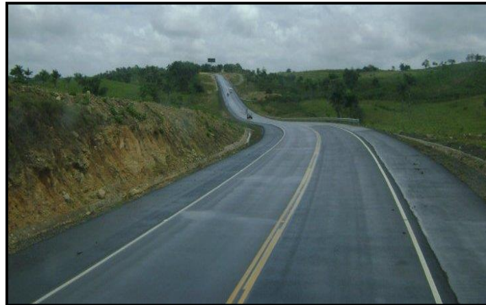
Figura N° 02. Vista de pavimento flexible
