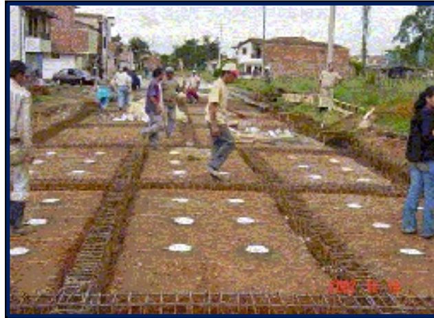
Figura N° 10: Vista típica del proceso constructivo de losas continuamente reforzada
