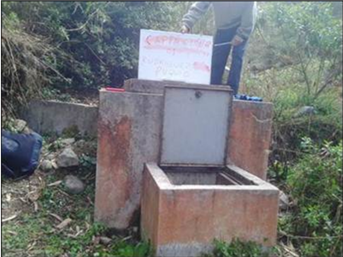
Figura 4.9: Captación manante Rodriguez Huayccopuquio.
