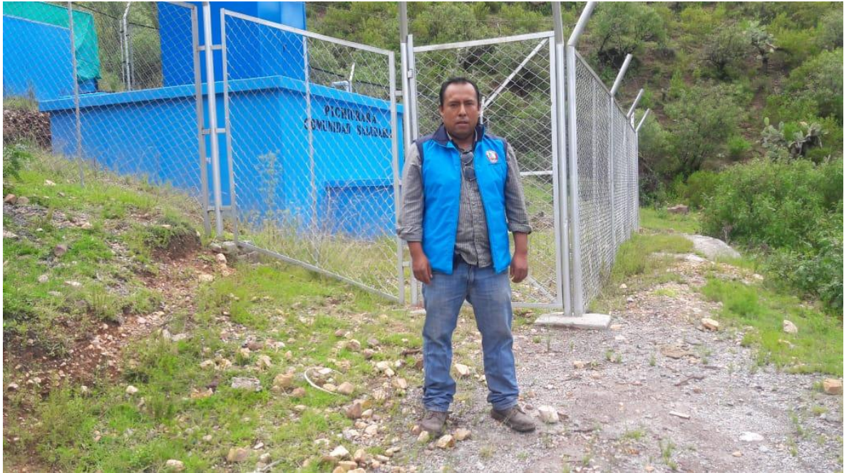
Foto 09: En esta toma fotográfica se muestra reservorio instalado en la localidad de Pichiurara.
