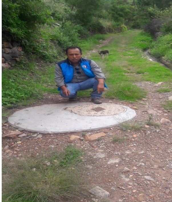
Foto 07: En esta toma fotográfica se muestra los buzones del sistema de alcantarillado instalado en la localidad de Pichiurara.
