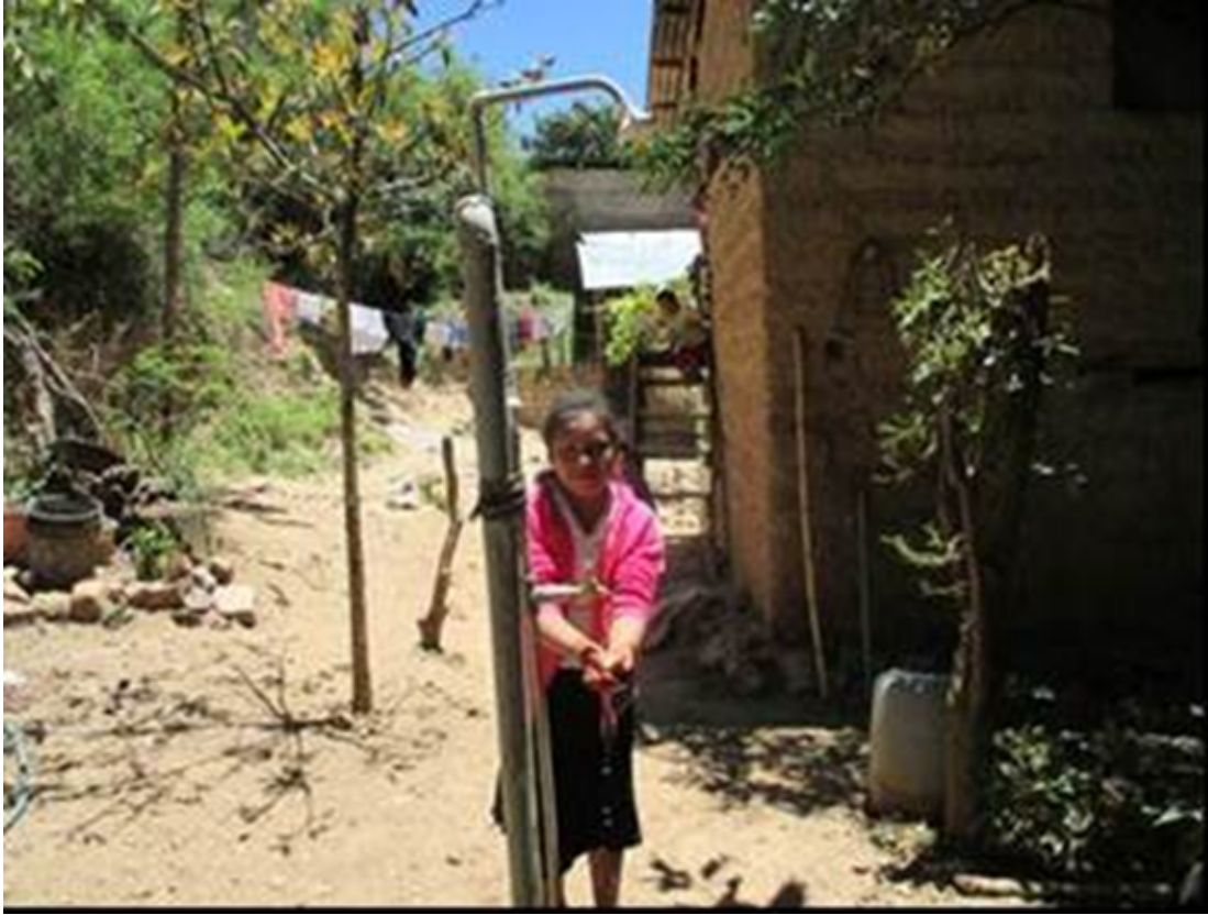
Figura 4.13: Conexiones domiciliarias rudimentarias.
