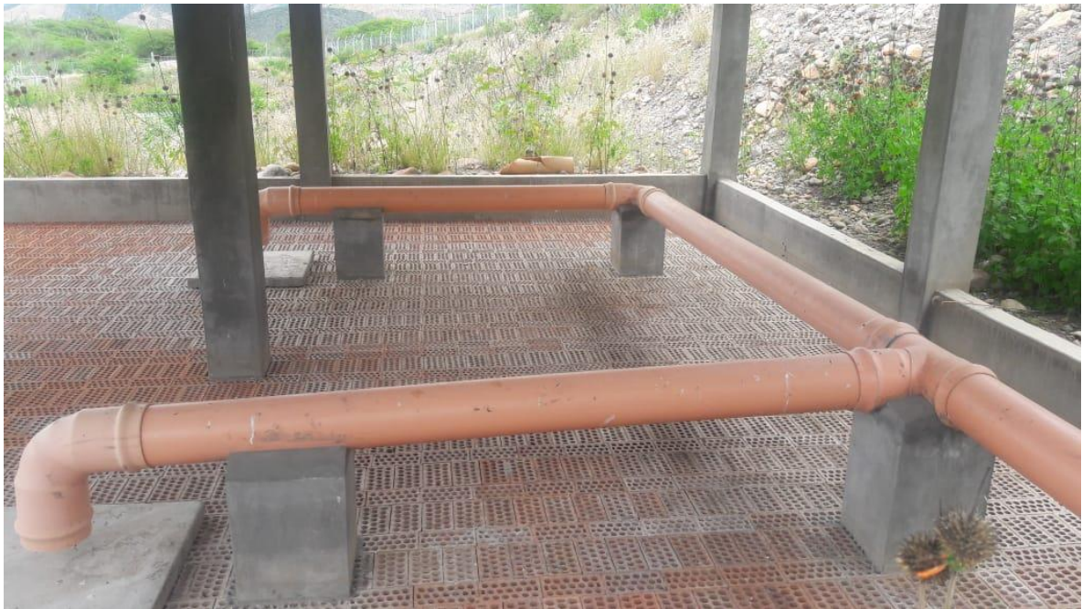
Foto 05: En esta toma se muestra la instalación de tuberías del sistema.
