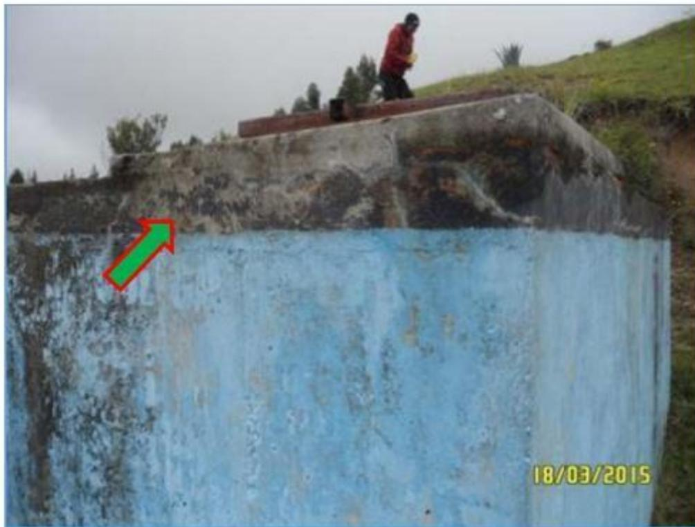
“Se observa las estructuras del reservorio con fisuras y grietas en la estructura corriendo el riesgo de colapsar debido a su antigüedad de construcción de 20 años ya que es el único reservorio de almacenamiento que provee de agua a la población”.
