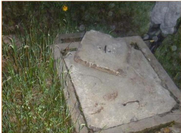
**CAPTACIÓN CCAYUCUCHO:** Es una captación de manantial de ladera construido, en el año 1999 por el Proyecto Especial Sierra Centro Sur del Ministerio de Agricultura, actualmente las estructuras de concreto están deteriorados, como las estructuras de la protección del afloramiento, de la cámara. húmeda y cámara seca
