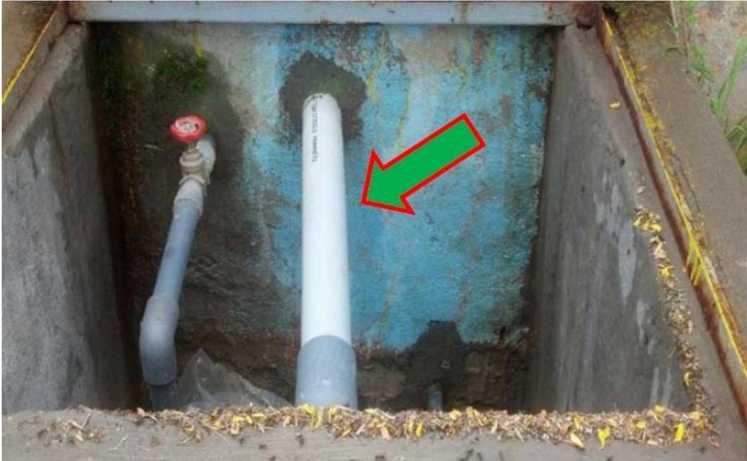
**Figura 03:** Cámara seca de la captación Cconchopata con los accesorios deteriorados.
