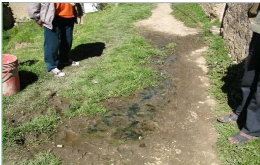
“Las redes de distribución de la localidad de Atahui fue instalado en el año 1995 por PAR, en un total de 800 ml. de tubería PVC. SAP. Ø 1pul”.
