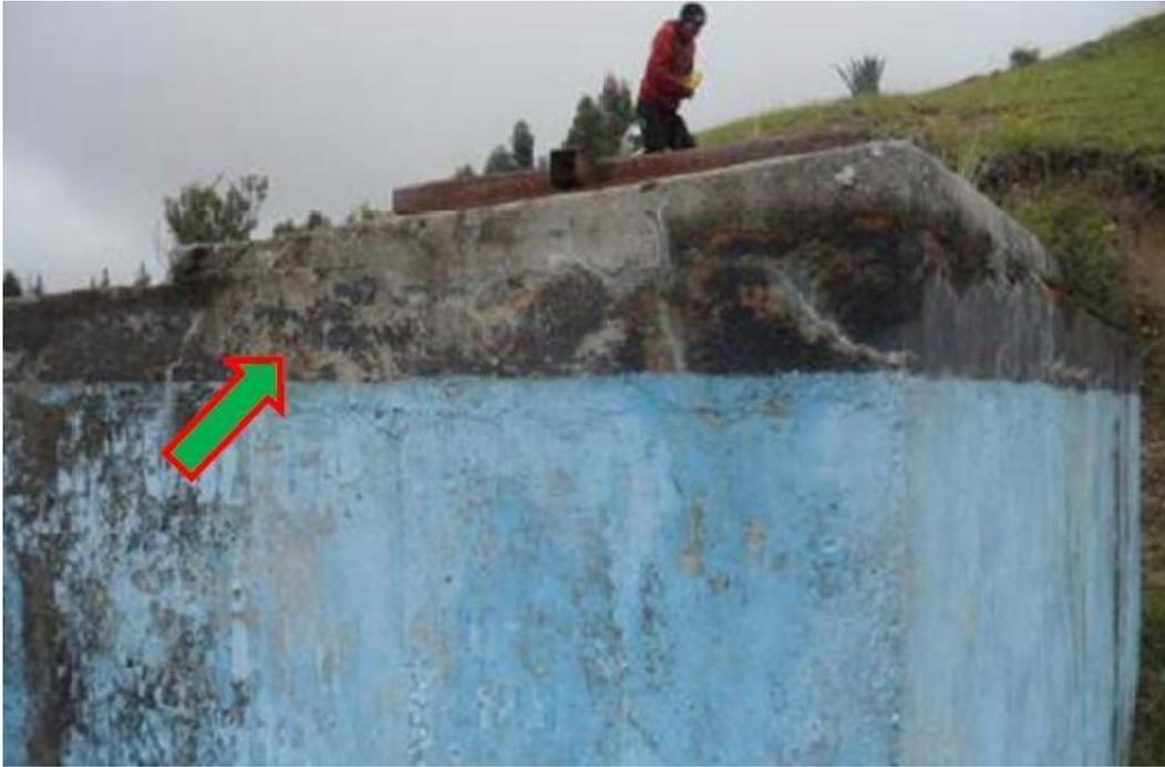
**Figura 05.** Estructura del reservorio en condiciones deterioradas.
