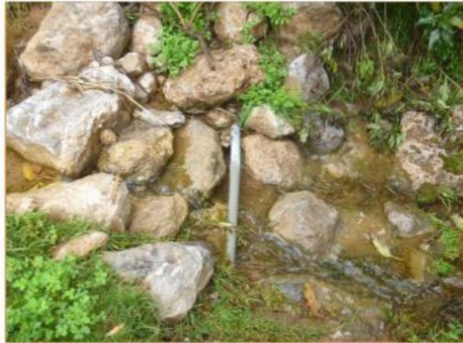
SE OBSERVA, que las tuberías en varios tramos están expuestas y el deterioro de la tubería SE CONCLUYE y se recomienda el reemplazo de toda la línea de conducción
