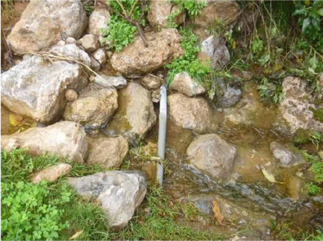
**Figura 11:** Tubería de Línea de Conducción expuesta.
