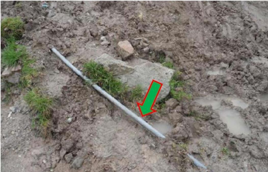
**Figura 04:** Tuberías expuestas y con fugas.
