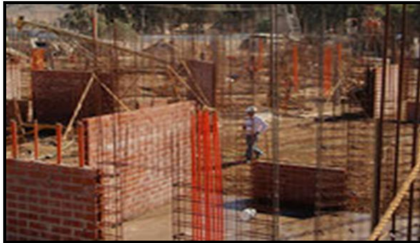
Figura 02. Albañilería confinada
