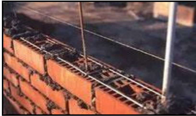
Figura 01. Albañilería armada
