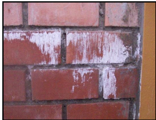
Foto N° 03: Se observa la patología efllorescencia en la unidad muestral 01, 02, 03 y en sus diferentes elementos de albañilería confinada.
