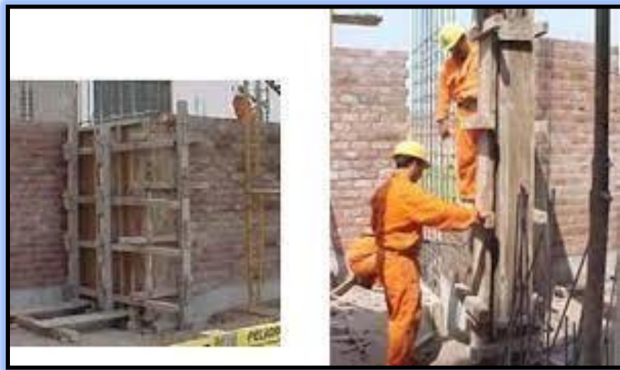
Figura. 06 Columnas de concreto armado
