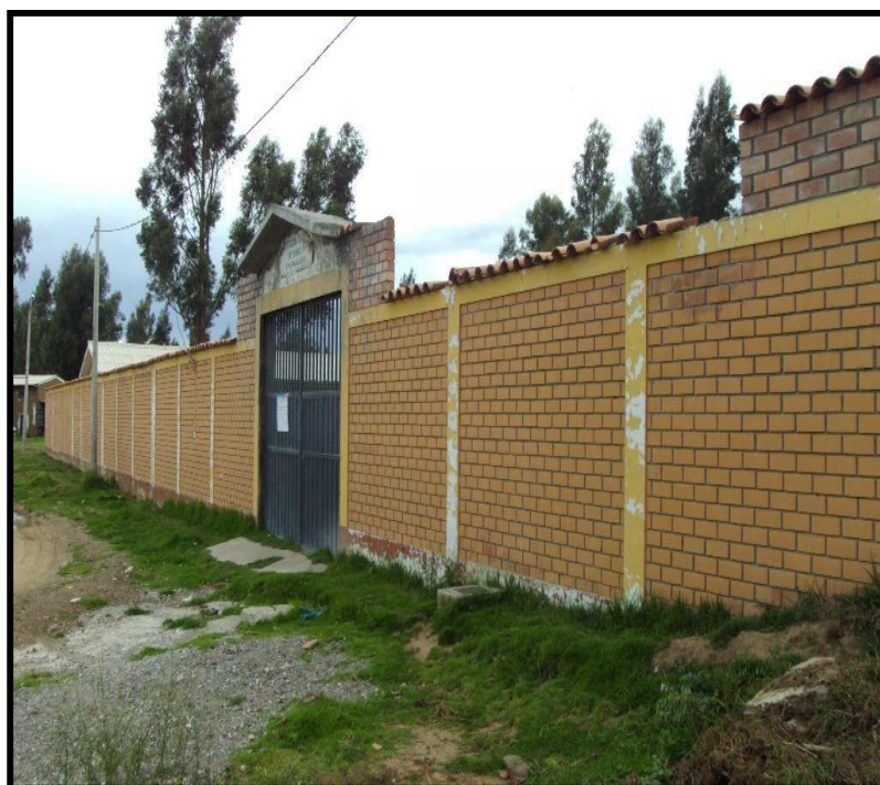
Figura 07. Cerco perimétrico de la I.E. N° 86033.
