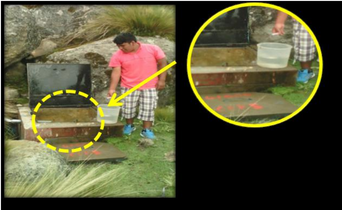
Figura 4.15: Vista de Captación.
