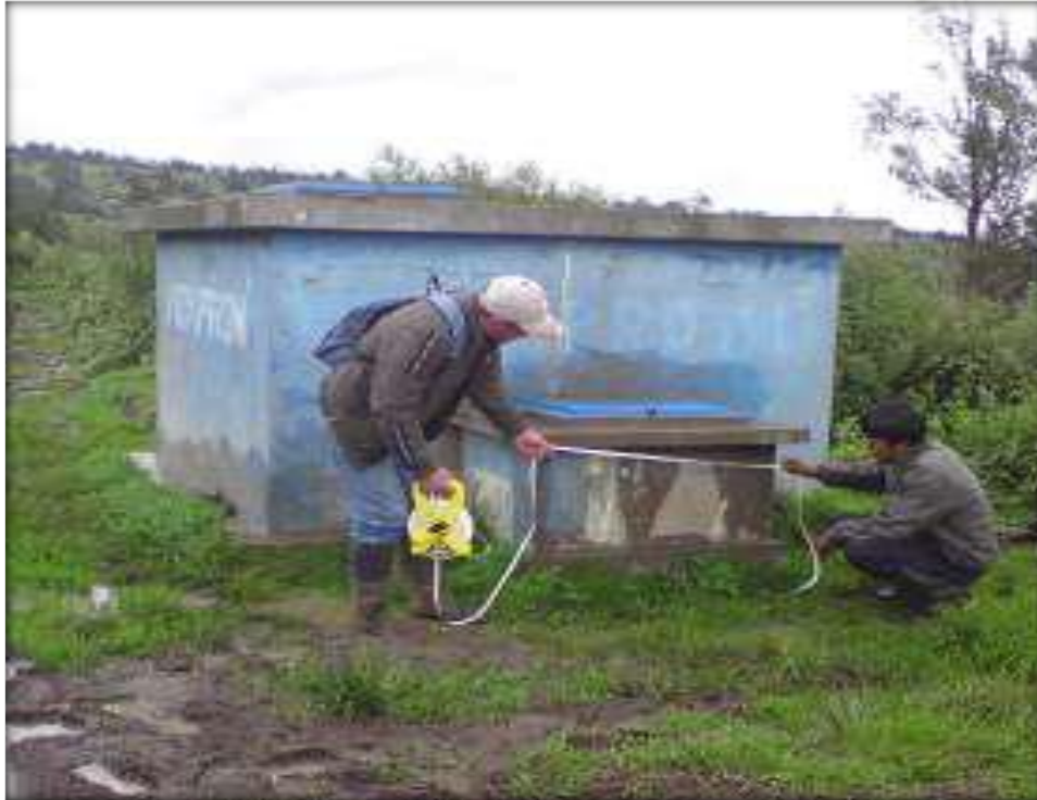
Foto 05: Reservorio de 10 m 3 que abastece al anexo Unión Nuevo Progreso.
