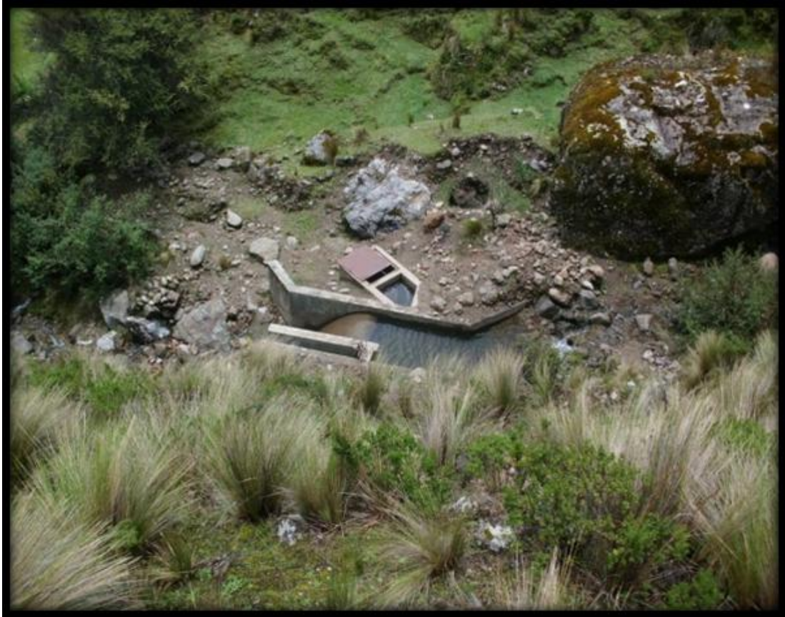
Figura 4.3: Captación existente de concreto armado
