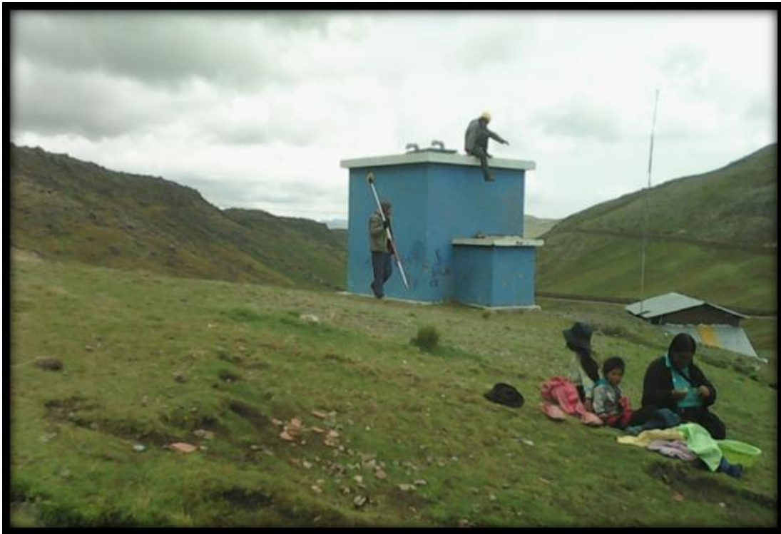
Figura 4.10: Reservorio de 17.2 m 3
