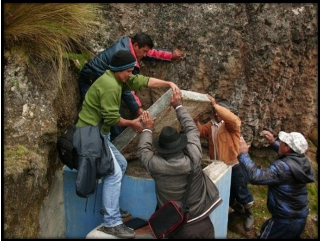
Figura 4.9: Captación en Estado Regular
