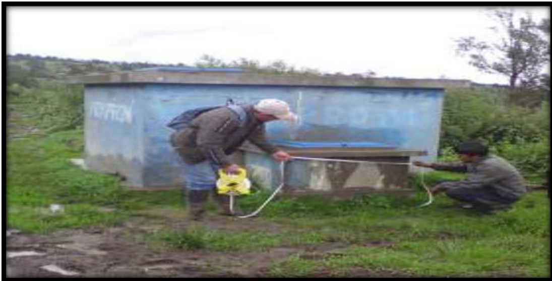
Figura 4.16: Reservorio de 10 m 3 . Que abastece al anexo Unión Nuevo Progreso
