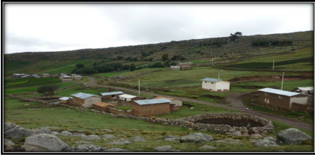
Figura 4.20: Vista de la red de aducción y distribución en estado regular
