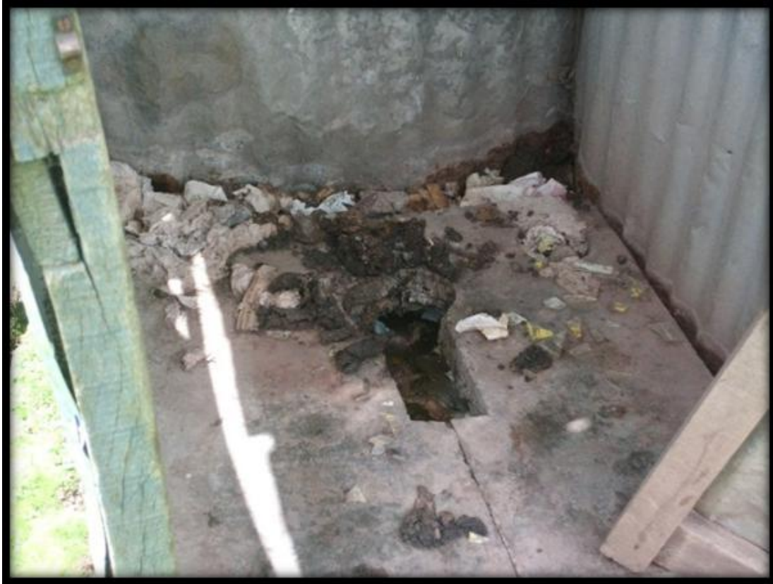
Figura 4.14: Situación actual de las letrinas
