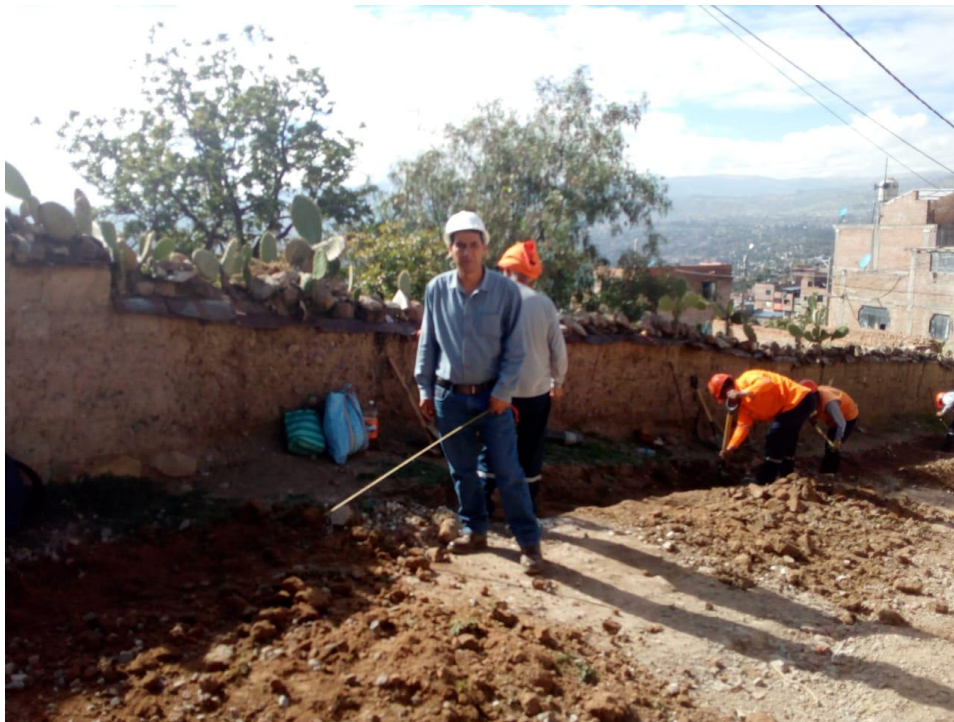
Foto 06: En esta fotografía se observa la excavación que se realizó para la para la red de distribución domiciliaria en la comunidad de Palca.
