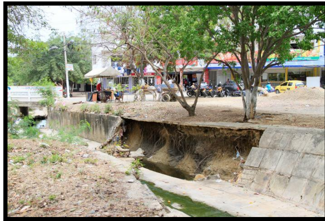
Figura 7: Erosión
