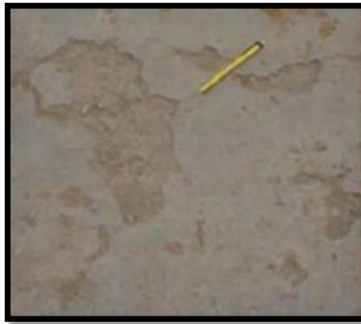
Figura 13: Descascaramiento
