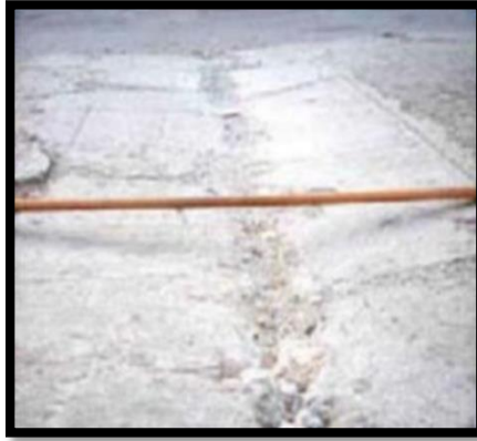
Figura 11: Hundimiento
