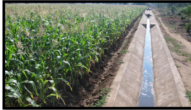
Figura 1: Canal de concreto
