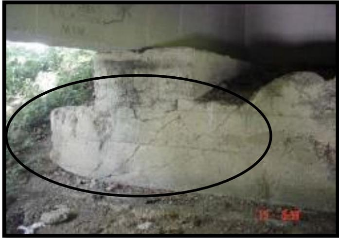
*Figura 4.* Fractura por aplastamiento en viga de cimentación.
