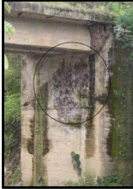
*Figura 8.* Presencia de eflorescencia en el estribo de un puente
