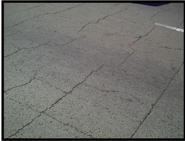
Figura 7. Fisuras por retracción
