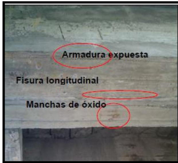
Figura 10. Corrosión
