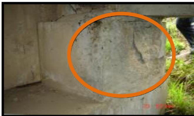
Figura 3. Fractura por aplastamiento
