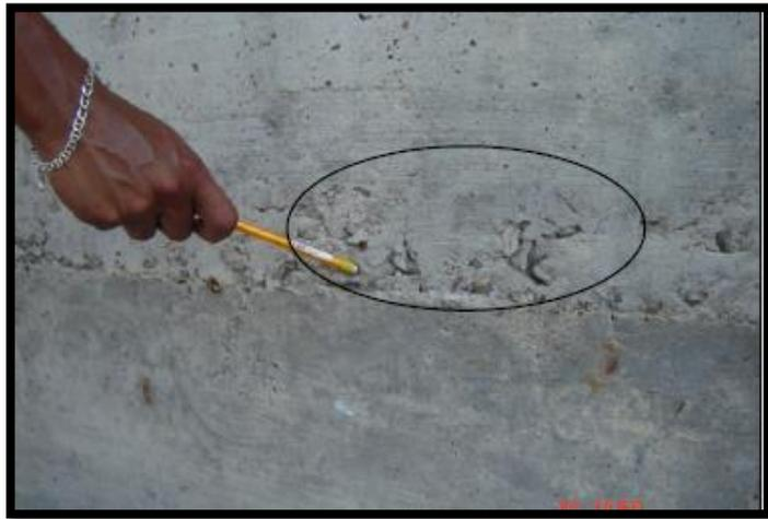
*Figura 6.* Segregación en un muro
