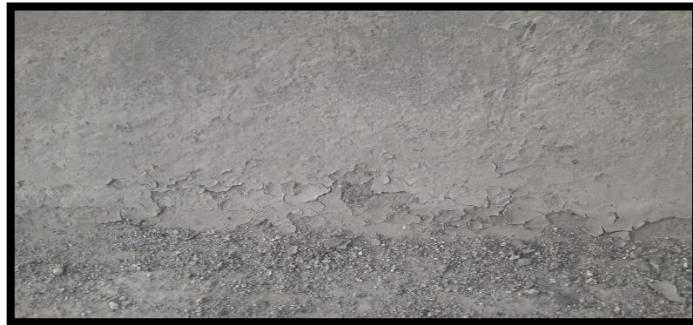
Gráfico 10 (descascaramiento en el canal de regadío)
