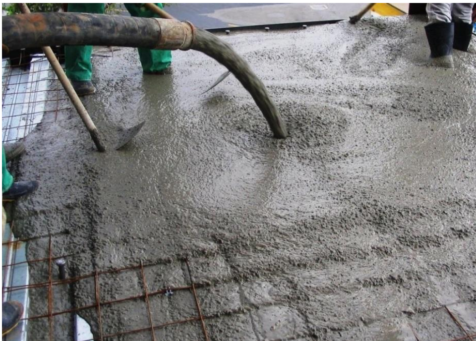
Figura 5. Concreto en encofrado. Fuente: (Vargas) 15
