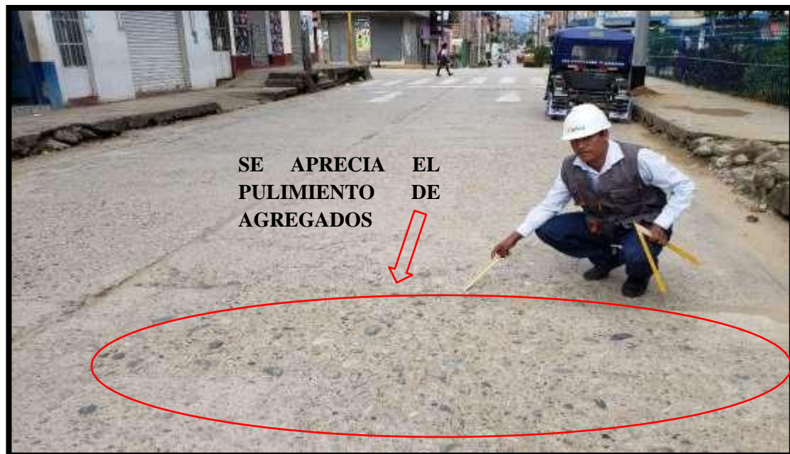
Figura 86. Fotografía de la vista de la existencia de pulimientos de agregados (31).
