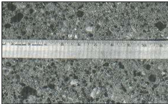
Figura 24. Pulimiento de Agregado.
