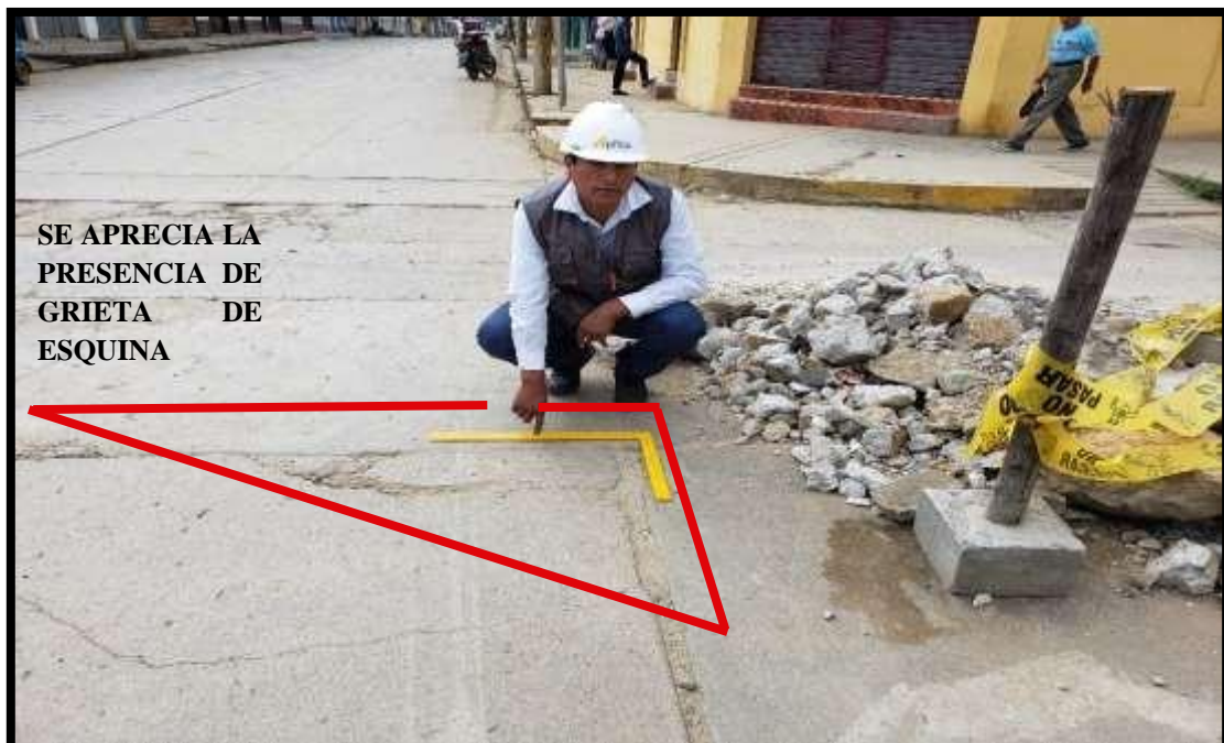
Figura 110. Fotografía de la vista de la existencia del daño de grieta de esquina (22L).
