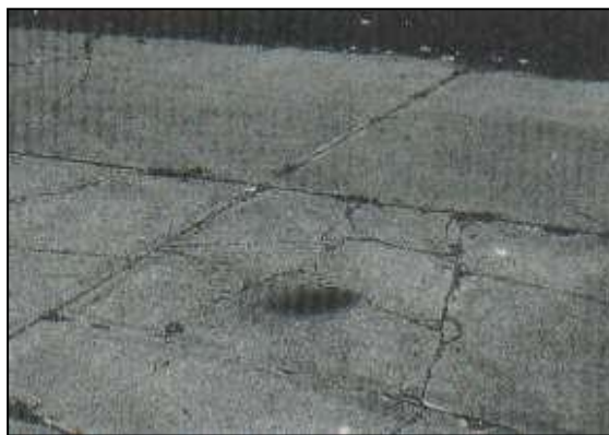
Figura 20. Losa Dividida.
