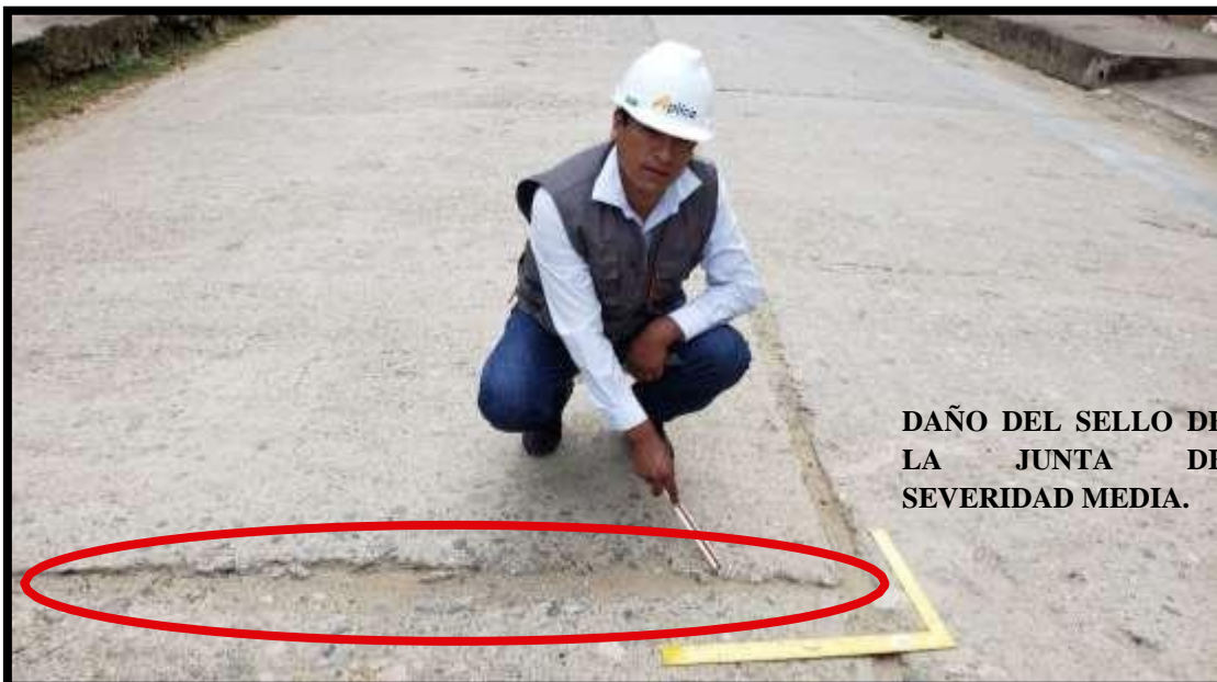
Figura 90. Fotografía de la vista cercana de la existencia del daño del sello de junta de severidad media (26M).
