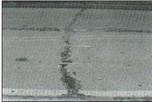
Figura 21. Grieta Lineales.
