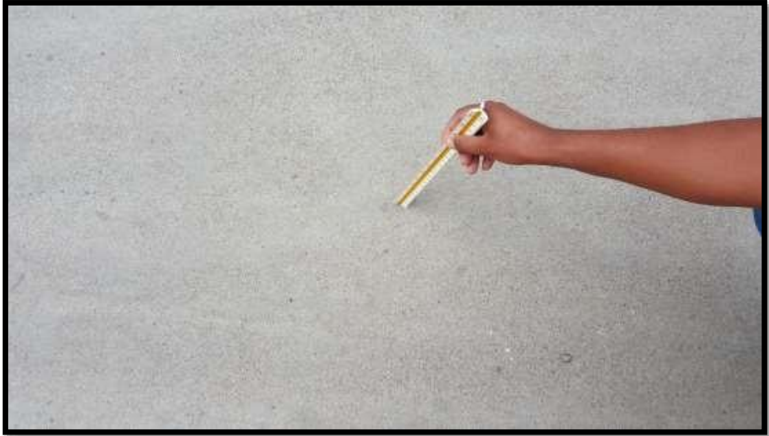
Figura 97. Fotografía de la vista cercana de la existencia de pulimiento de agregados severidad Media (31).
