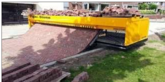
Figura 6. Técnicas de colocación de un pavimento articulado.
