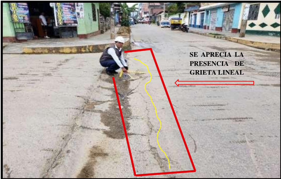
Figura 109. Fotografía de la vista de la existencia del daño de grieta lineal (Transversal) (28L).
