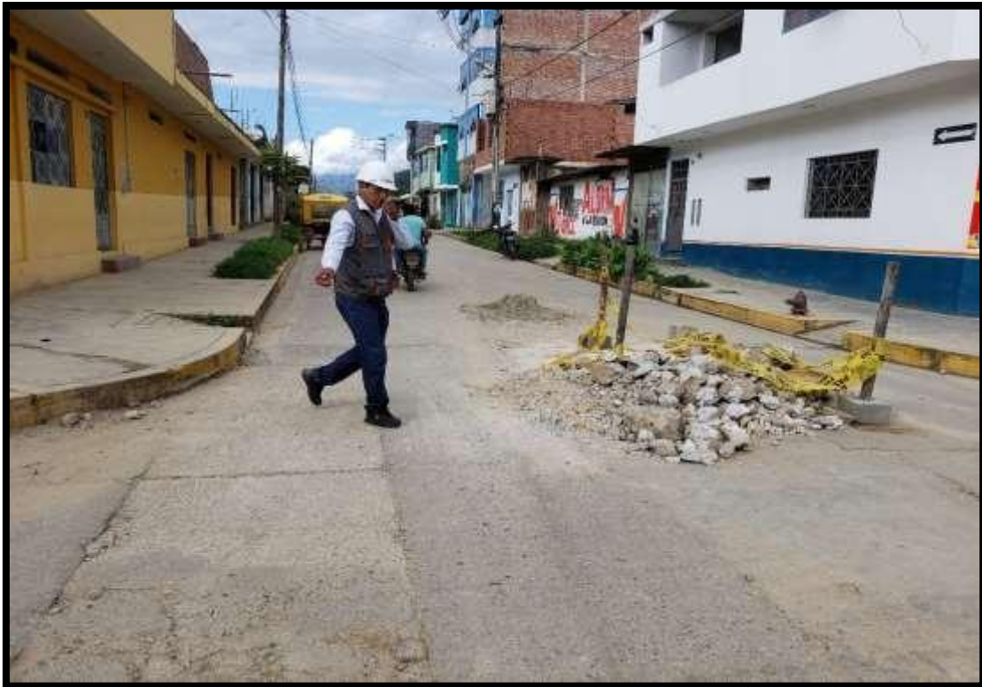
Figura 107. Fotografía de la vista panorámica de la 7ma cuadra del jirón Junín
