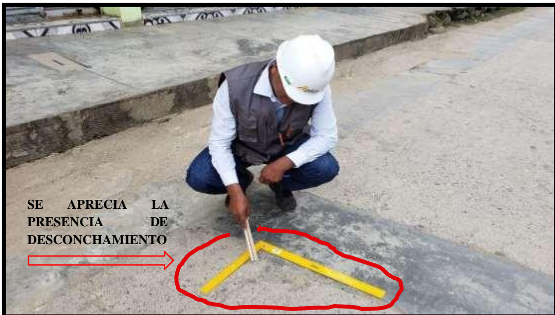
Figura 92. Fotografía de la vista cercana de la existencia del daño de desconchamiento de severidad media (36M).
