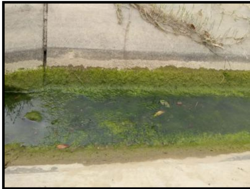
Gráfico 11: Vegetación en canal de concreto.
