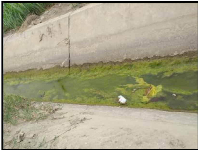
Gráfico 51: Sedimentación de sólidos en el canal
