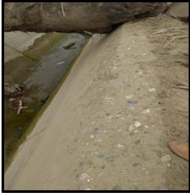
Gráfico 52: Erosión del concreto en la corona del canal
