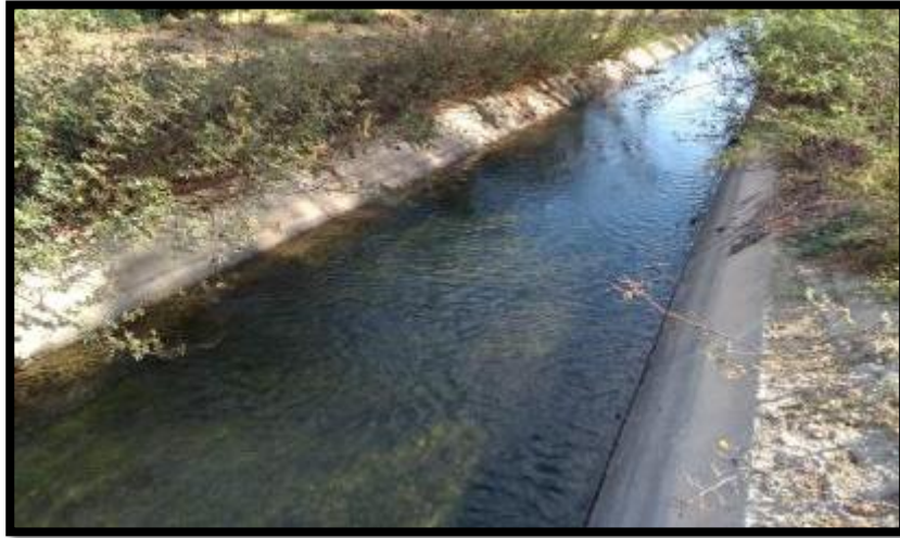
Gráfico 3: Canal de concreto.
