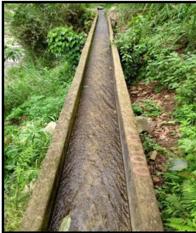
Gráfico 5: Canal rectangular de concreto.
