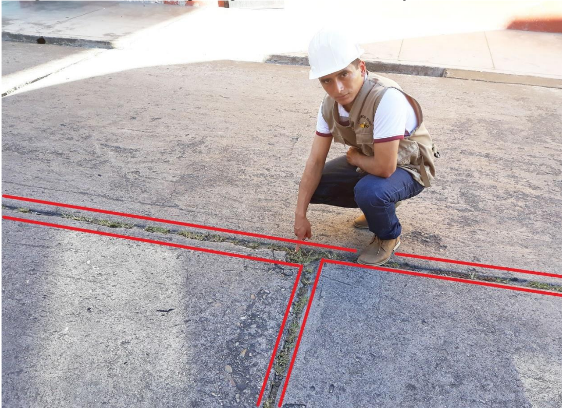
Fotografía 8. Se observa la patología de daño del sello de la junta en la UM – 02.
