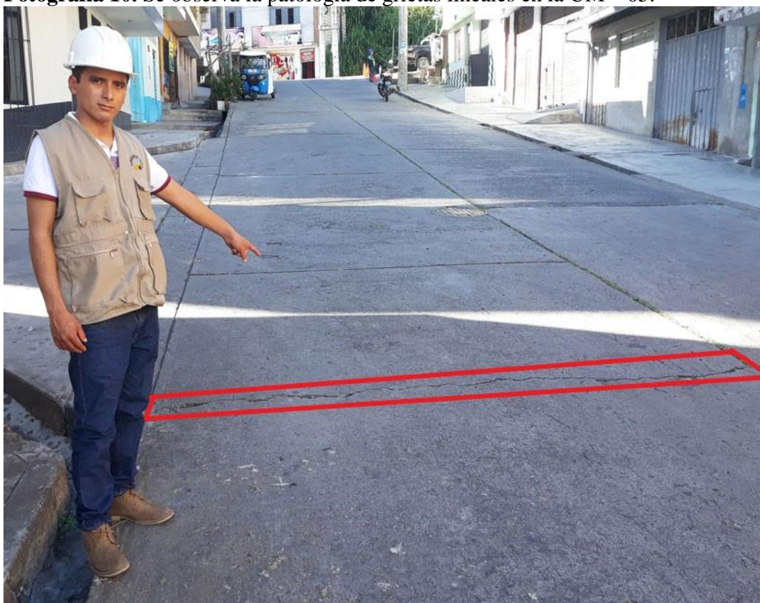
Fotografía 10. Se observa la patología de grietas lineales en la UM – 05.
