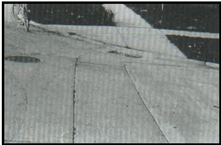
Figura 32. “Parche grande y acometida de servicios públicos de baja severidad” (20) .
