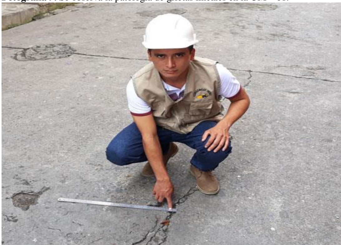
Fotografía 10. Se observa la patología de grietas lineales en la UM – 05.
