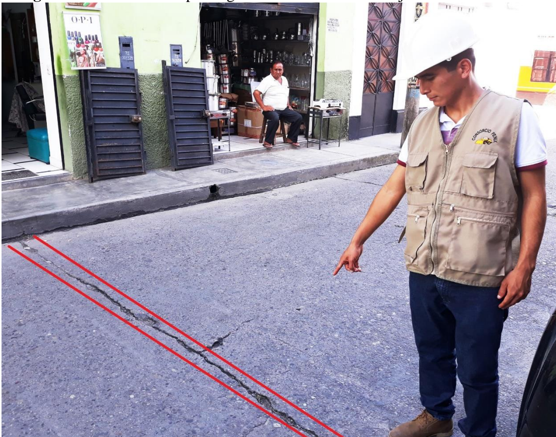
Fotografía 8. Se observa la patología de daño del sello de la junta en la UM – 02.
