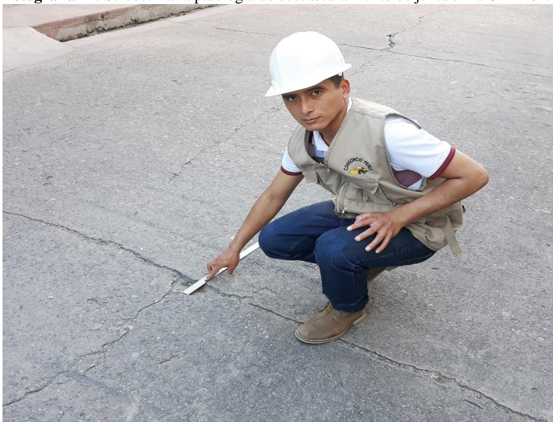
Fotografía 12. Se observa la patología de descascaramiento de junta en la UM – 04.
