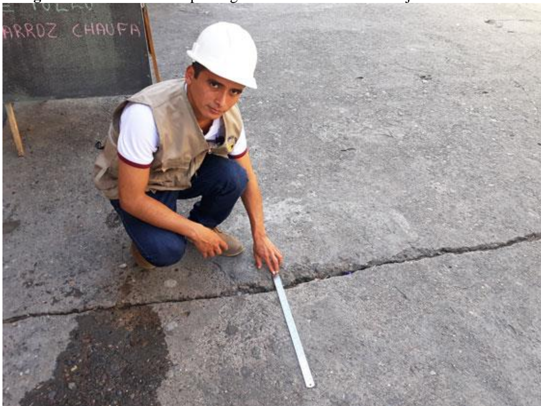
Fotografía 12. Se observa la patología de descascaramiento de junta en la UM – 04.
