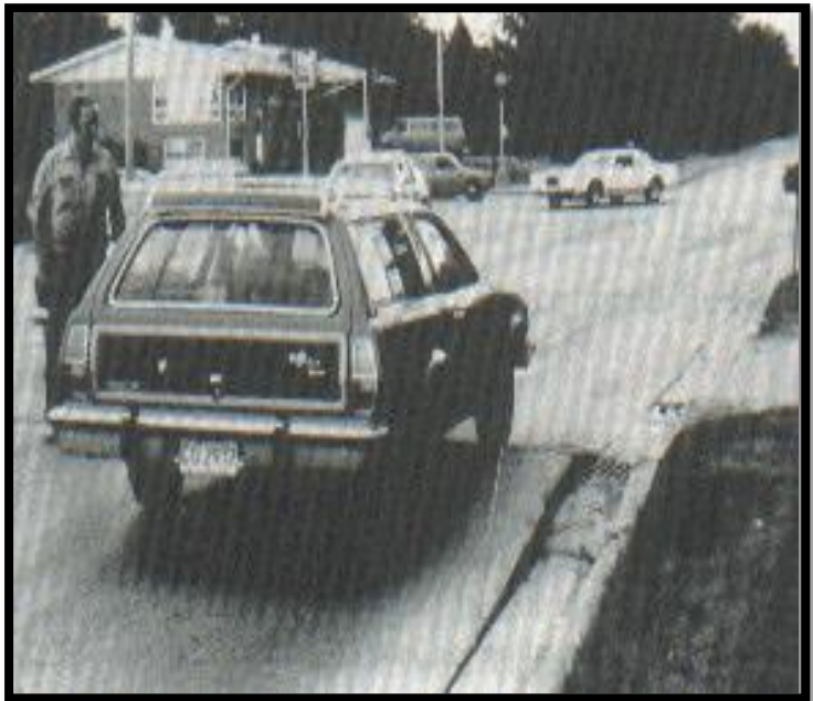
Figura 10. "Blowup - Buckling de alta severidad" (20) .
