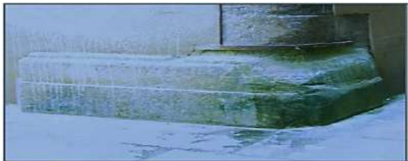
Imagen 17: Ataques biológicos en el concreto.
