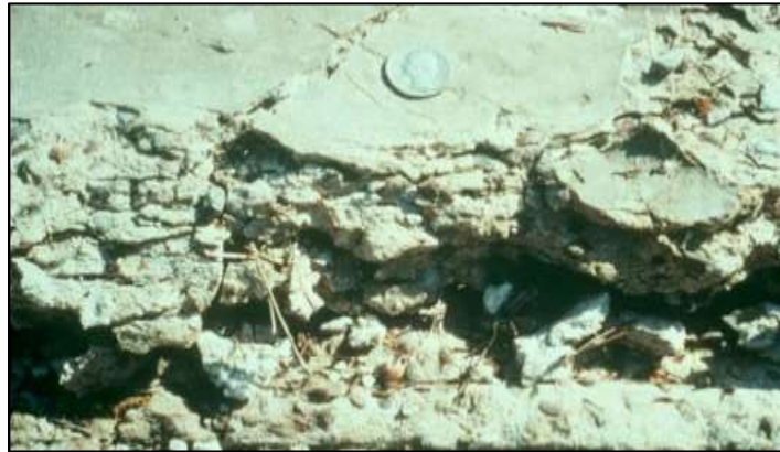
Imagen 20: Desintegración
