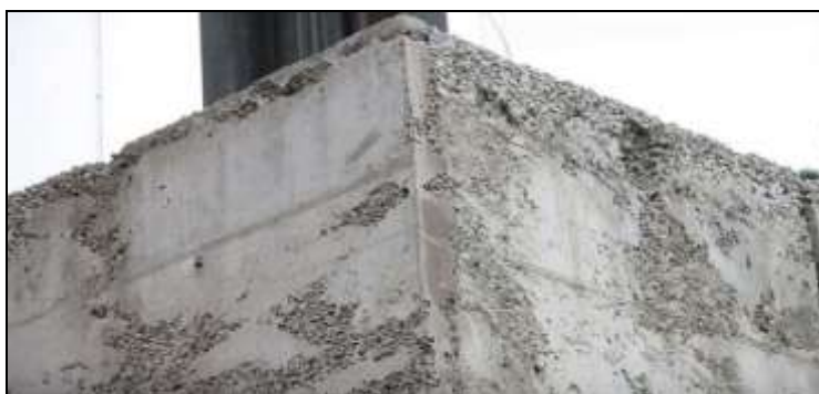
Imagen 9: Ataques por abrasión.
