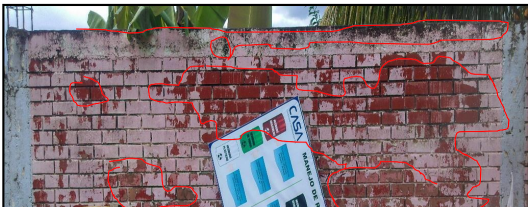
figura 57. Evidencia de la muestra 01, paño 06 se observa las patologías humedad de descascaramiento y eflorescencia.
