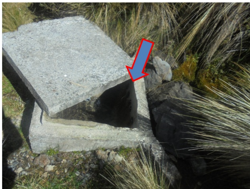
Figura 4.3: Estado de la Captación
