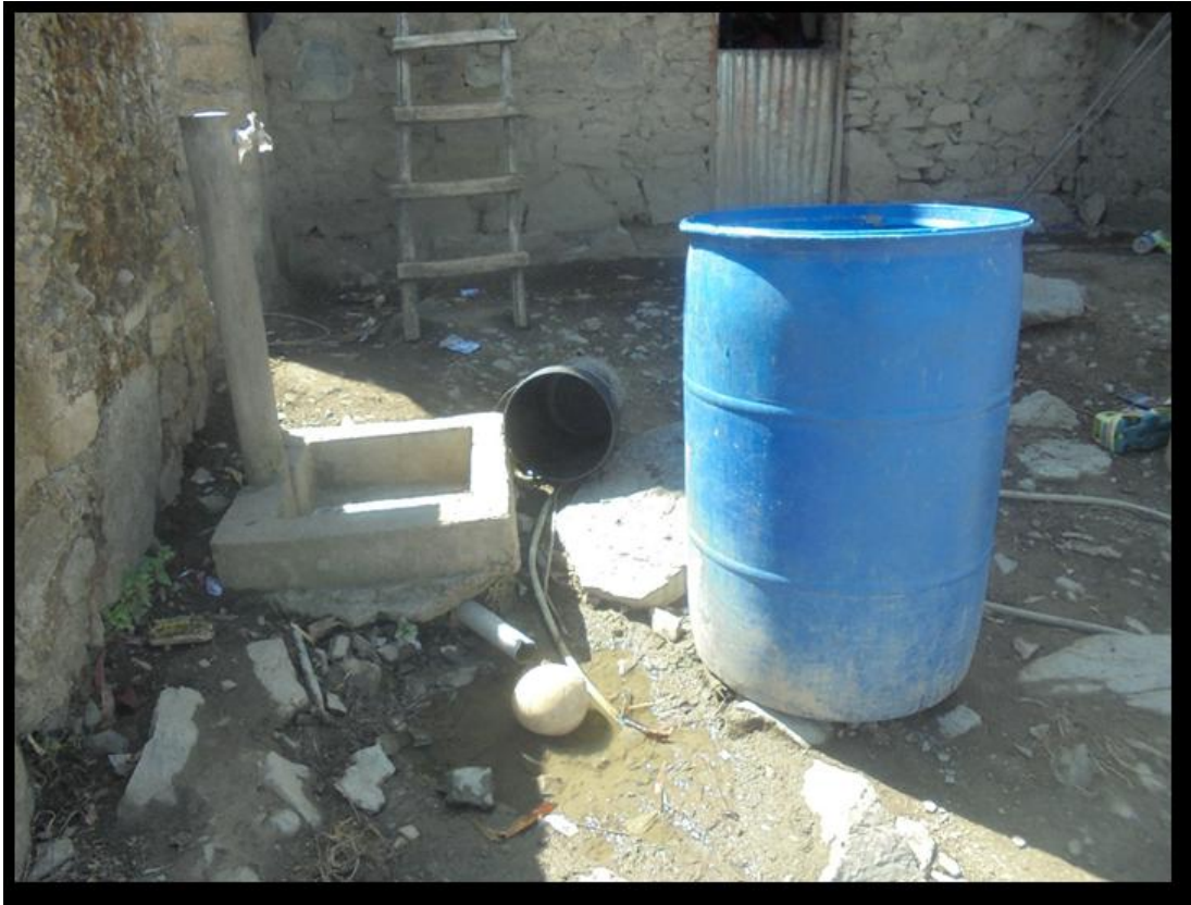
Figura 4.23: Vista de Conexiones Domiciliarias
