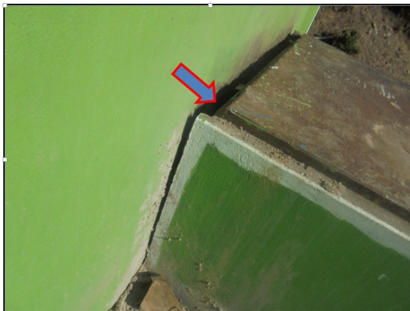
Figura 4.7: Vista de Caseta de Válvulas Separado del Reservorio
