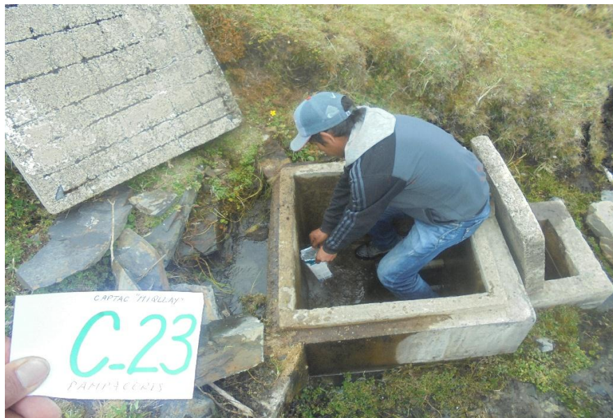
Foto 06: En esta toma fotográfica se muestra la caja de captación en la localidad de Ayahuanco.
