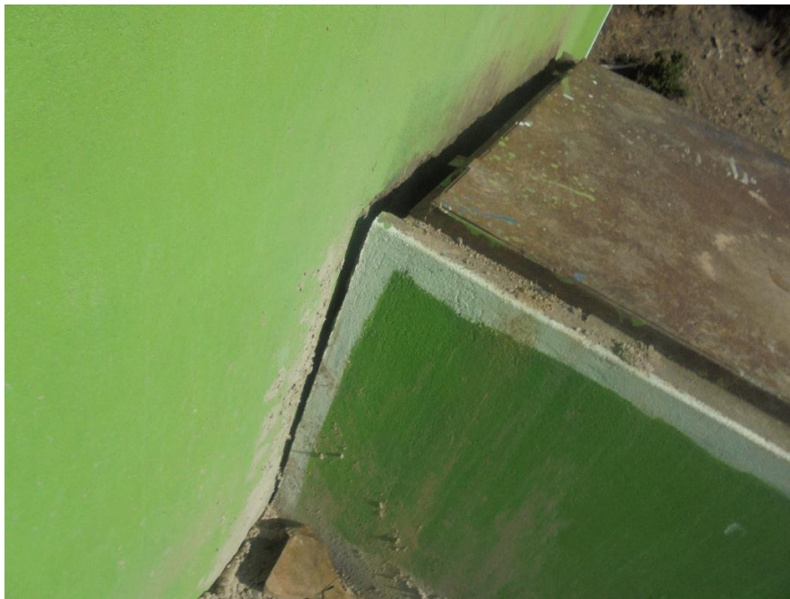
Foto 04: En esta toma fotográfica se observa la caja de las válvulas de carga.
