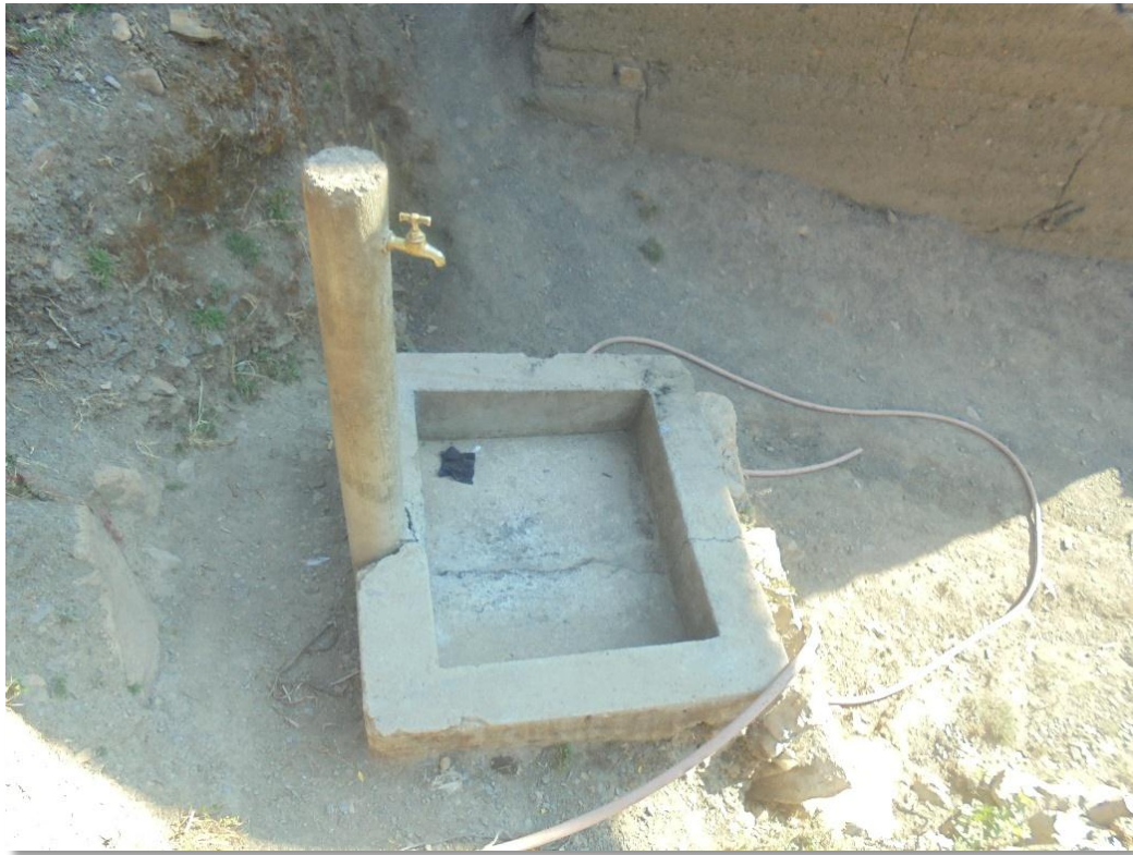
Foto 05: aquí podemos observar las instalaciones domiciliarias en la localidad de Ayahuanco.
