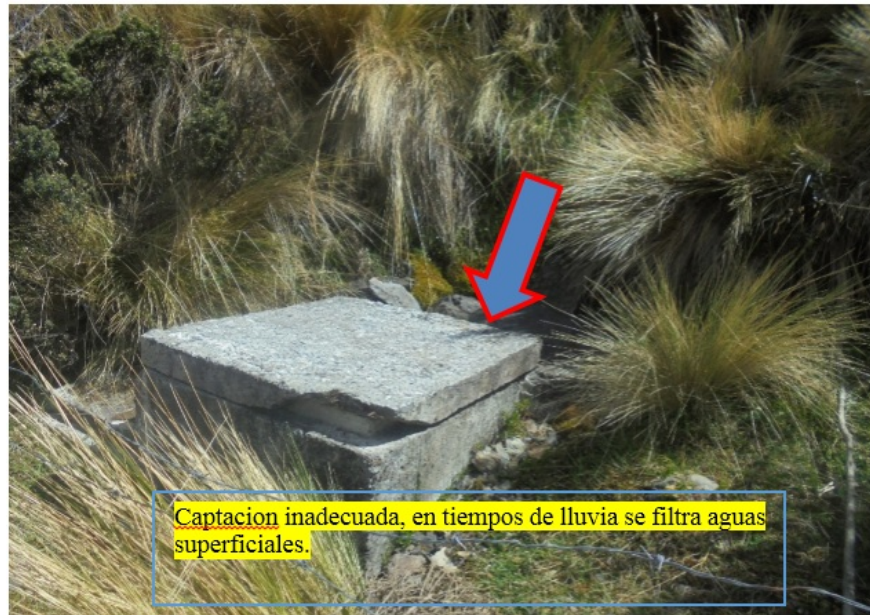
Figura 4.2: Estado de la Captación
