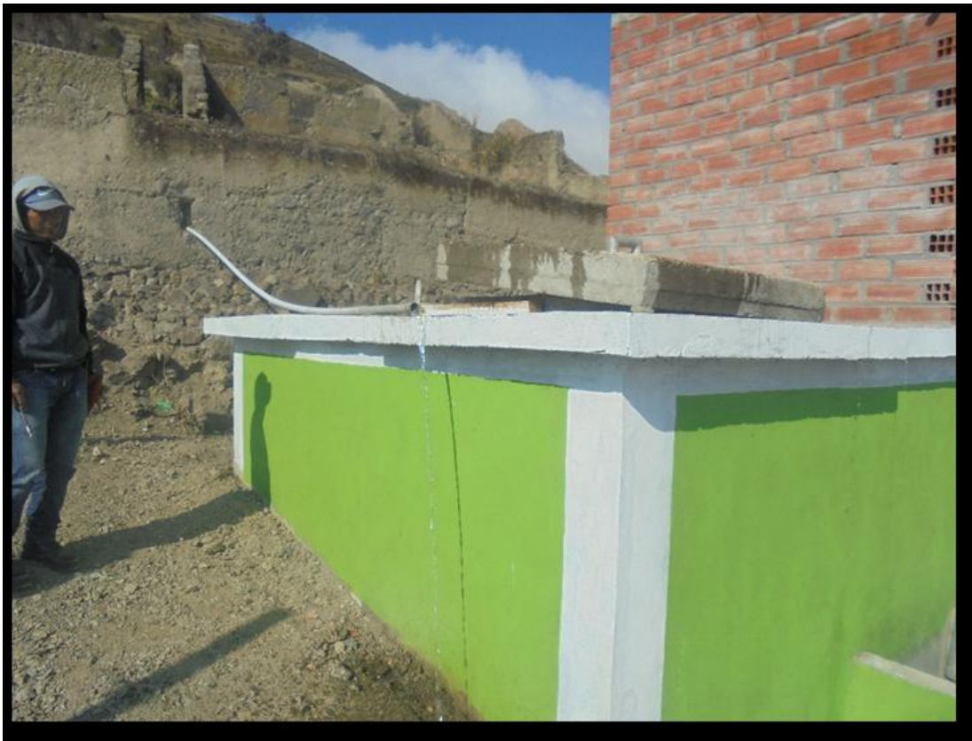
Figura 4.22: Vista de Reservorio Ubicado Casi a Nivelde las Viviendas
