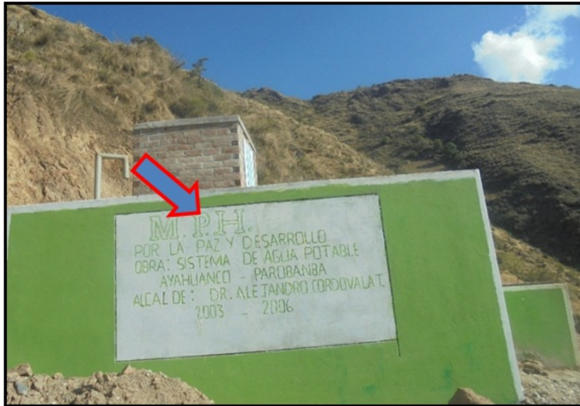
Figura 4.6: Vista de Reservorio Existente.
