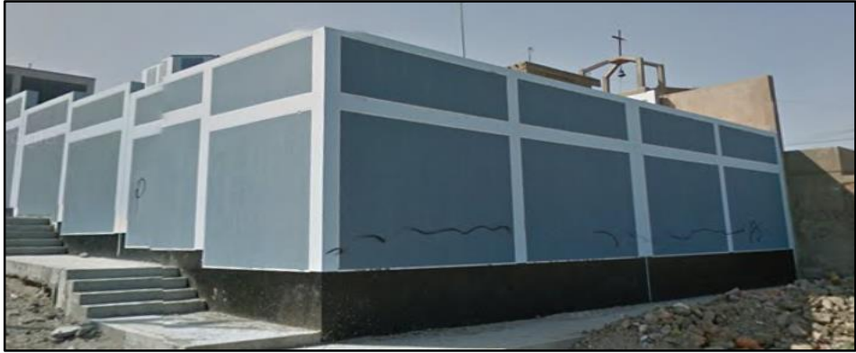
Figura 07. Muro de albañilería confinada.
