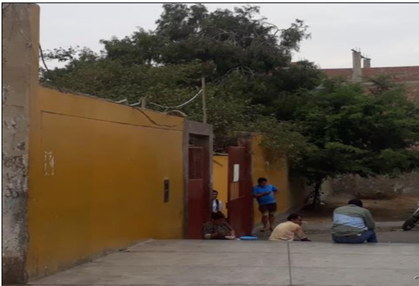
Fotografía 02. Vista del cerco perimétrico exterior eje 1-1 del camal municipal del distrito de Chimbote, provincia del Santa, región Áncash.
