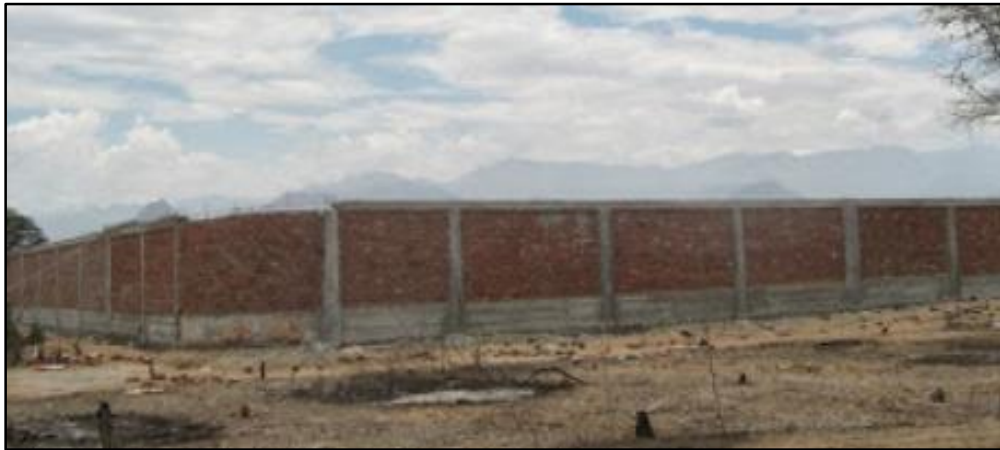
Figura 02. Cerco perimétrico de albañilería confinada.
