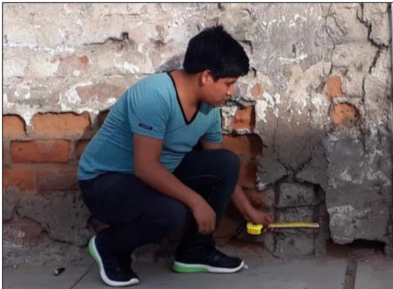
Fotografía 013. Columna afectada por corrosión en la unidad muestral 18 con un porcentaje de área afectada de 11.54% y un nivel de severidad alto.
