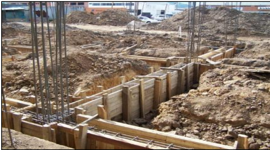
Figura 04. Proceso constructivo de los elementos de concreto armado.
