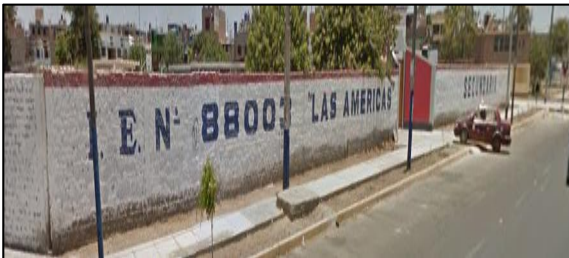
Fotografía 01: Vista Panorámica exterior del cerco perimétrico de la I.E. N° 88003
