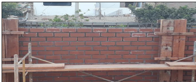
Imagen 05: Viga de cimentación, Fuente: OB Ingenieros SRL(2016).
