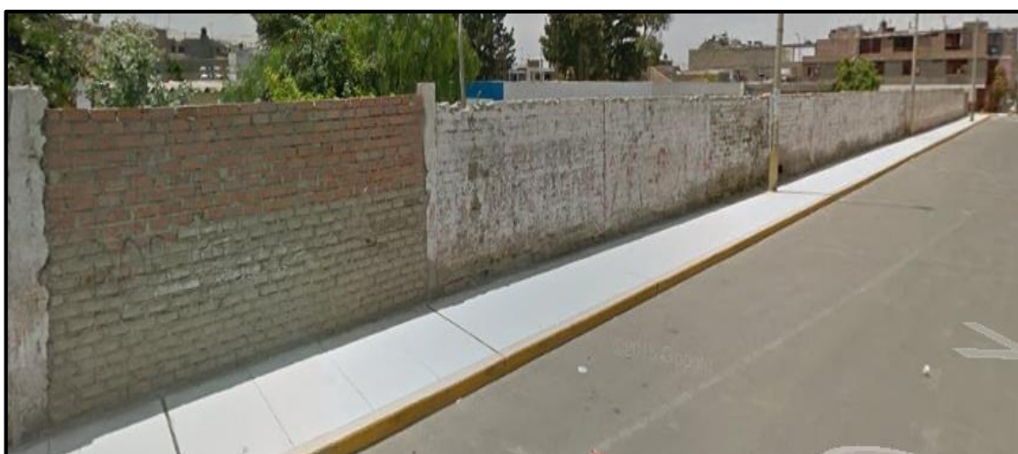
Fotografía 02: Vista Lateral del cerco perimétrico de la I.E. N° 88003.
