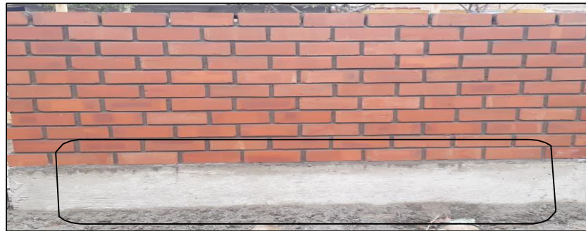
Imagen 06: Sobrecimiento en albañilería confinada de una edificación, Fuente: OB Ingenieros SRL (2016).
