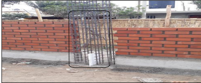
Imagen 04: Muro de albañilería, Fuente: OB Ingenieros SRL(2016).
