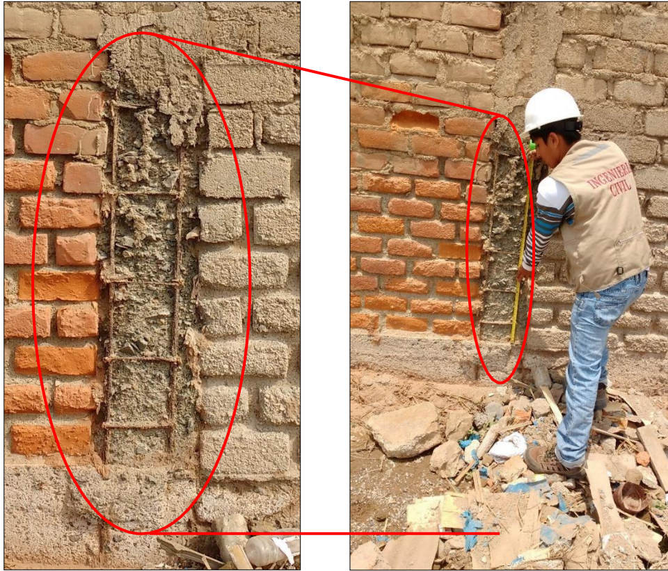
Fotografía 8: Corrosión
