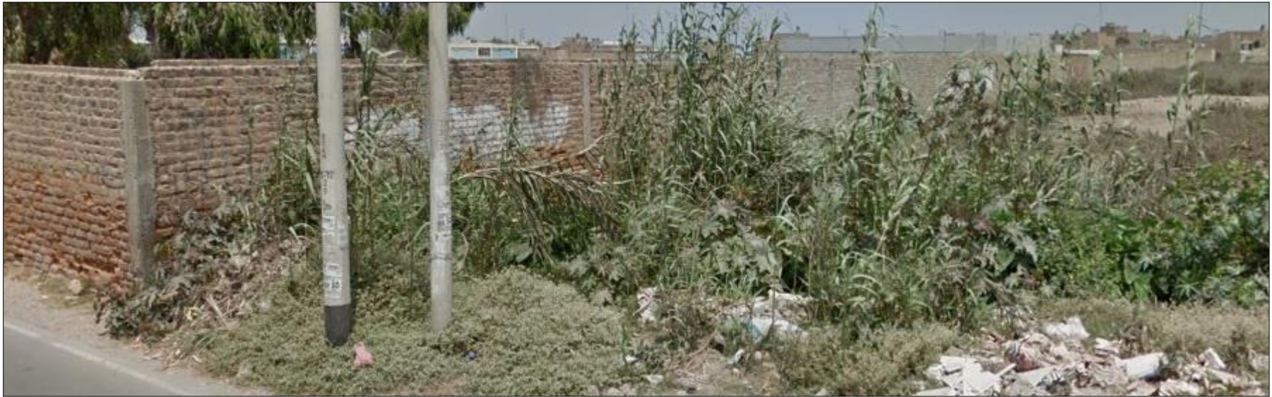
Fotografía 3: Vista panorámica exterior de la parte trasera del Cerco de la Institución Educativa Mercedes Indacochea Lozano.
