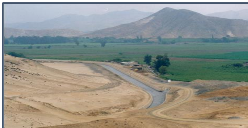
Figura 10. Canales de Derivación Fuente: Informe Diseño Hidráulico de canales de la UNS
