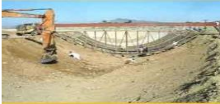
Figura 16. Canal de sección Parabólica Fuente: Ponencia Diseño Hidráulico de Canales – Universidad Nacional de San Martín
