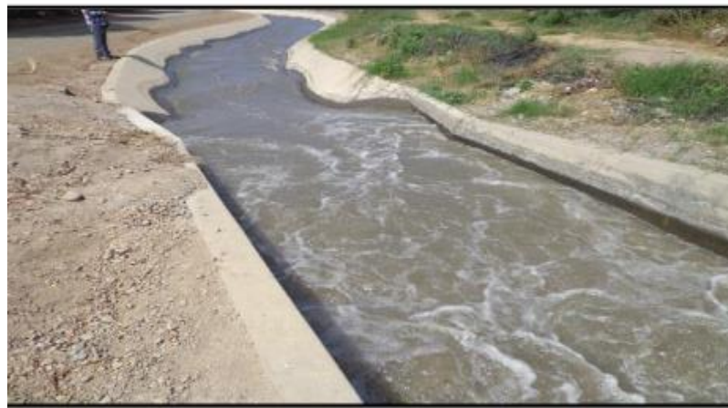
Figura 04. Canal Integrador Chaquin Fuente: Tesis - Evaluación de Fenómenos Hidráulicos en el Canal Chaquin Universidad Privada Antenor Orrego
