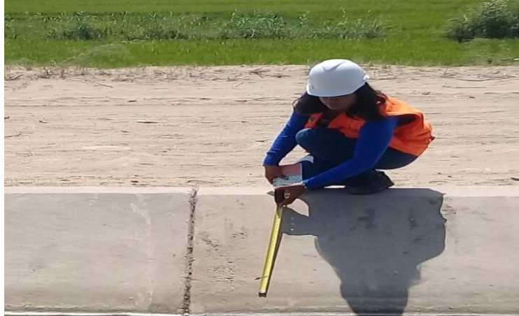
Figura 31. Eflorescencia. Canal San Seminario Fuente: Elaboración propia (2018)
