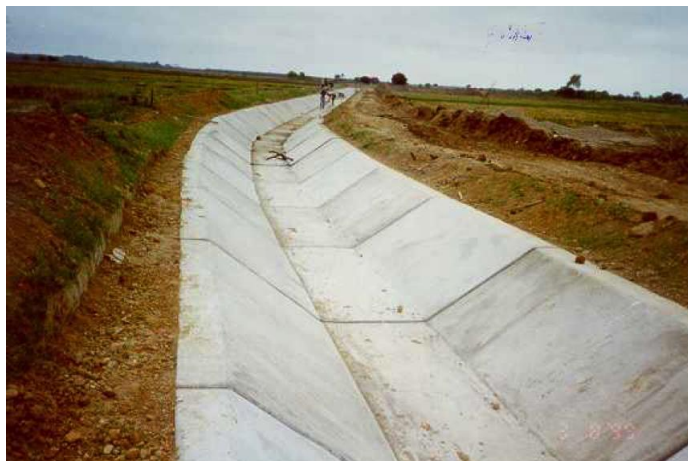
Figura 15. Canal triangular Fuente: Blog - Materiales de vanguardia para canales de riego- Instituto de Ciencia Tecnología e Innovación
