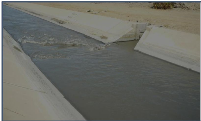
Figura 21. Canal Revestido Fuente: Informe Diseño Hidráulico de canales de la UNS
