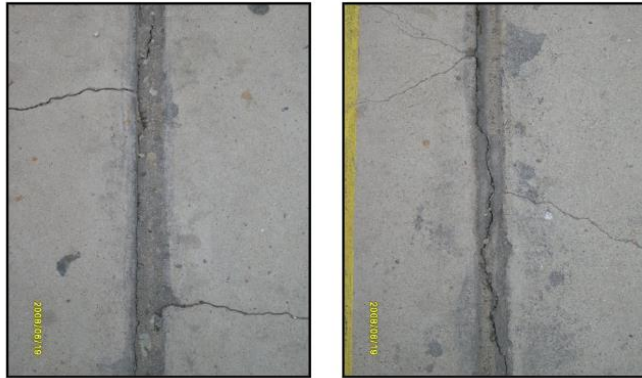
Figura 20. Sellado de Juntas Fuente: Documento DOCPLAYER- Juntas y Masillas Sellantes - SIKA PERU - 2015
