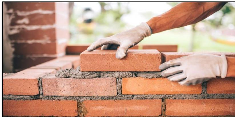
**Figura 04.** Unidad de albañilería la cual está siendo asentada con mortero.
