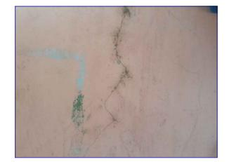
Se debe de picar la fisura en forma de "V" a una distancia de 1.50 cm de los bordes de la fisura.
