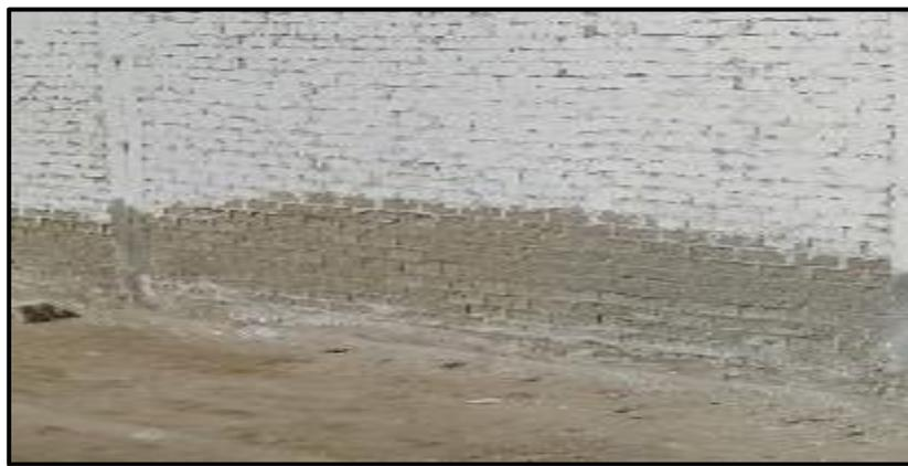
**Figura 18.** Disgregación en muros de albañilería.
