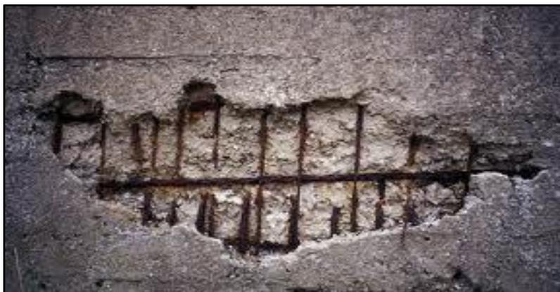
**Figura 21:** Corrosión.
