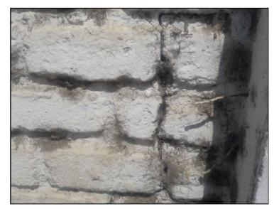
Se debe de picar la fisura en forma de "V" a una distancia de 1.50 cm de los bordes de la fisura.
