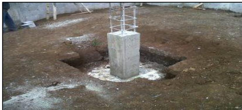
**Figura 07.** Columna de concreto armado.
