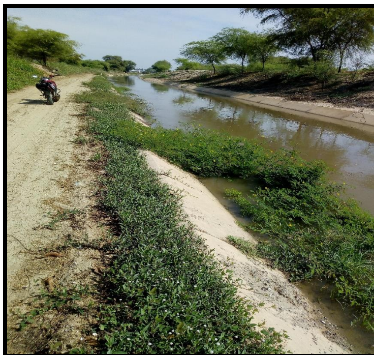
Imagen 31: Vegetación – Losa de Fondo Progresiva: 01+036 – 01+103 Fuente. Elaboración Propia, noviembre 2018
