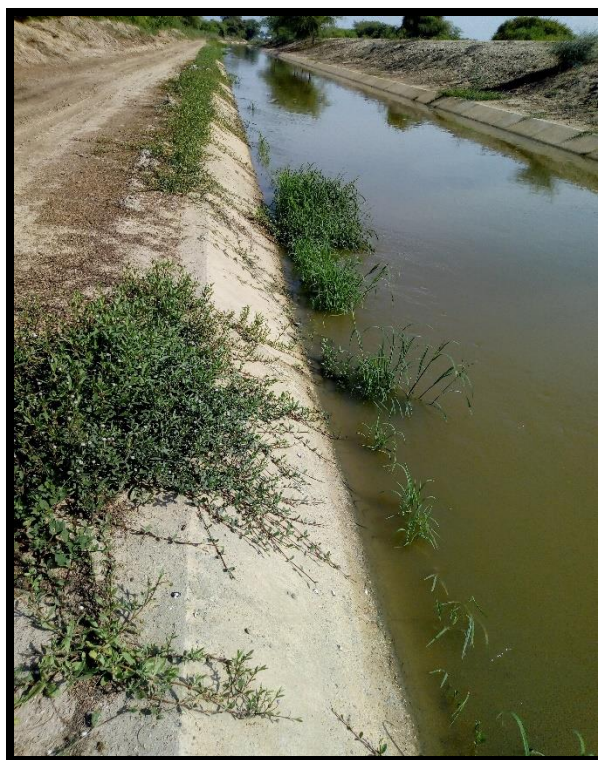
Imagen 32: Vegetación Progresiva: 01+103 – 01+170 Fuente. Elaboración Propia, noviembre 2018
