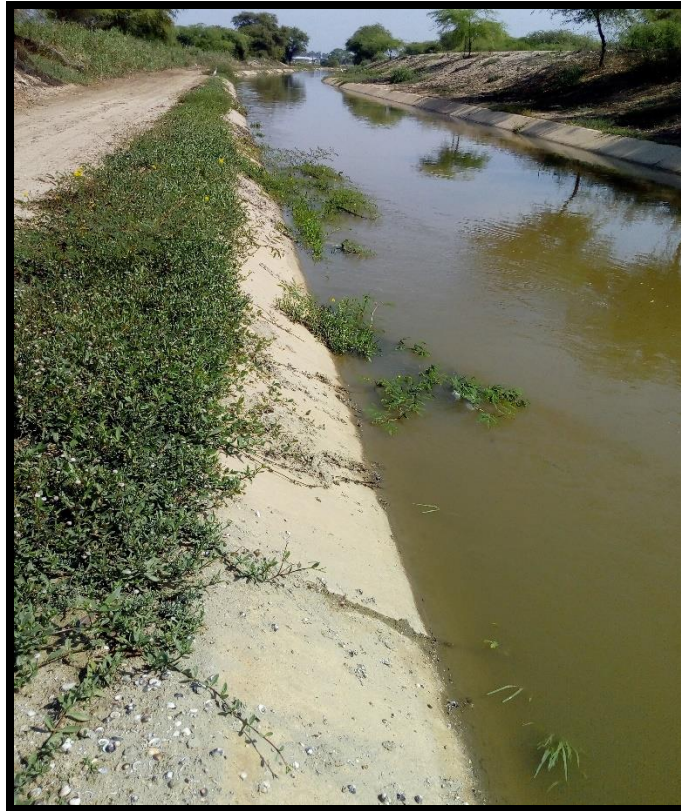
Imagen 37: Vegetación Progresiva: 01+438 – 01+505 Fuente. Elaboración Propia, noviembre 2018
