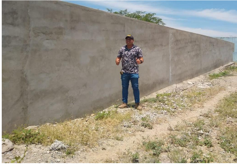
FOTOGRAFÍA N° 14: Verificando zona VI.
