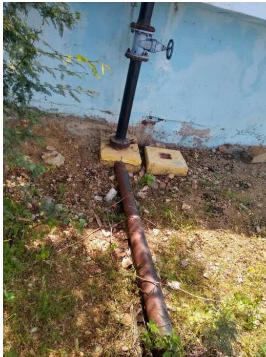
FOTOGRAFÍA N° 13: Verificando zona V.
