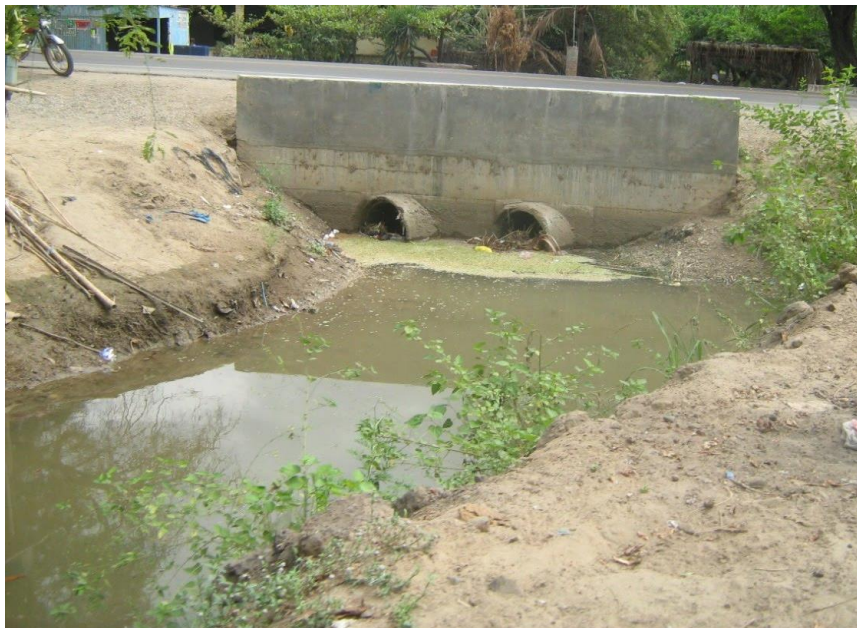
FOTOGRAFÍA N° 9: Verificando zona II.
