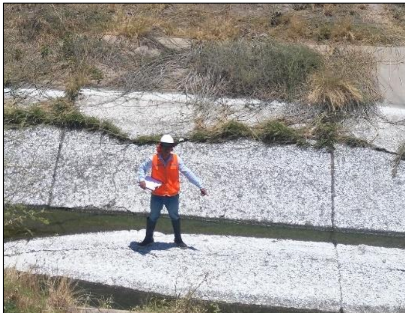
Grafico N° 99: Apreciación de la patología: Levantamiento, de grado de severidad medio. Fuente: Propia.
