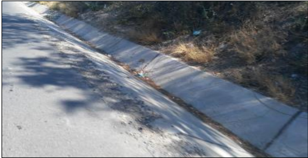
Grafico N° 05: Cuneta carretera al distrito de “Las Lomas”. Fuente: Elaboración propia, 2018.
