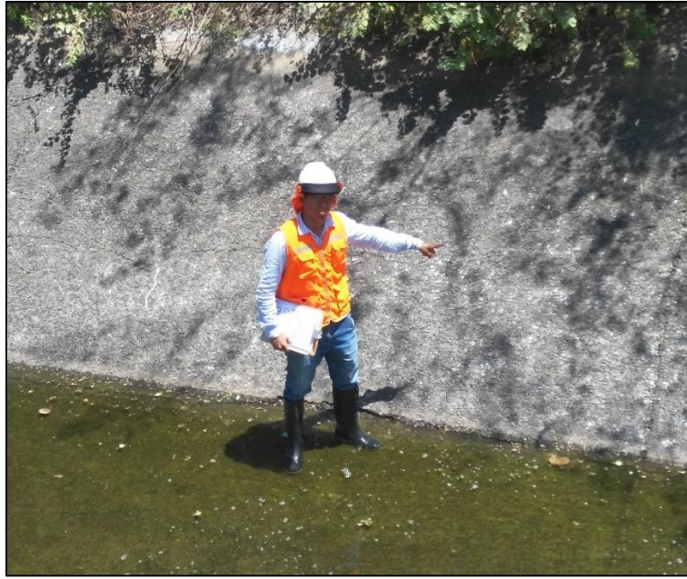
Grafico N° 94: Apreciación de la patología: Descascaramiento, de grado de severidad alto. Fuente: Propia.
