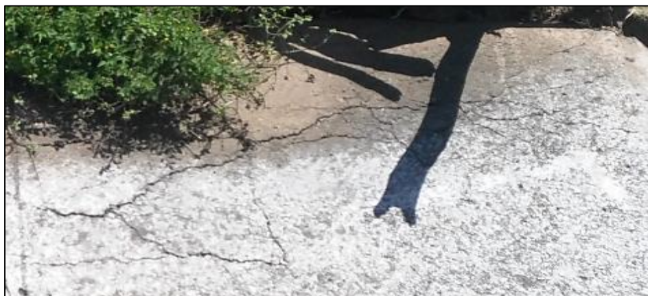
Grafico N° 11: Grietas de durabilidad. Fuente: Elaboración propia, 2018.
