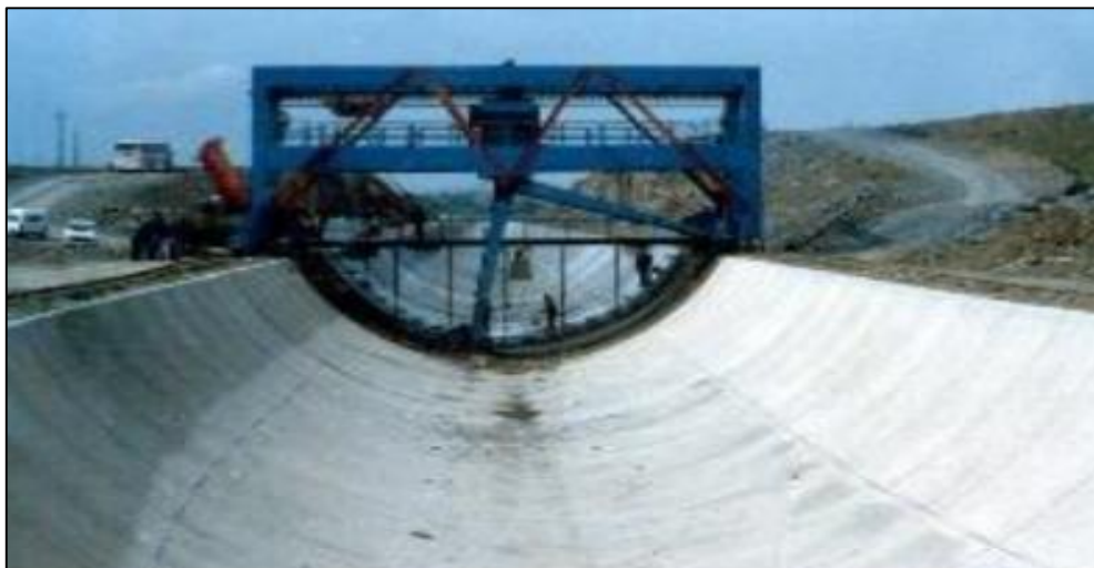
Grafico N° 06: Sección parabólica. Fuente: Cátedra curso Irrigación y Drenaje de la Facultad de Ingeniería Civil – UNP
