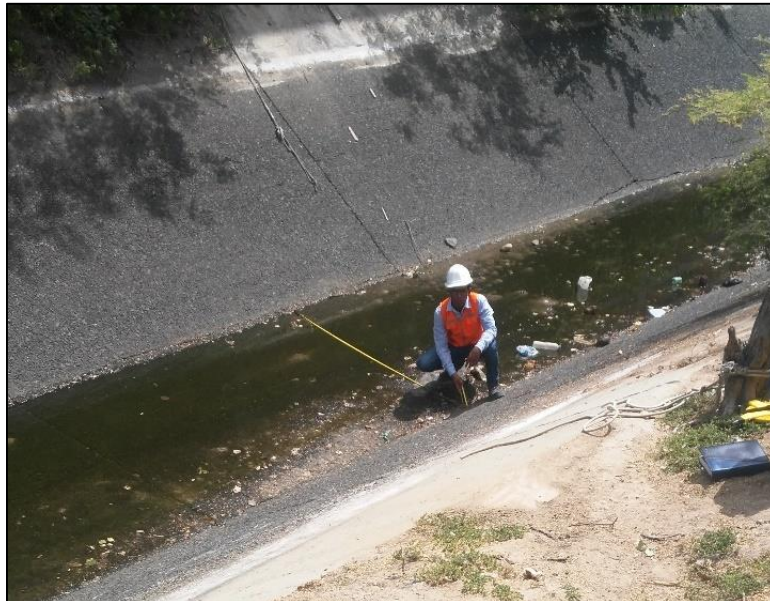
Grafico N° 97: Medición del fondo del canal, (solera). Fuente: Propia.
