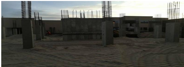
Gráfico 6: Estructuras de concreto armado.
