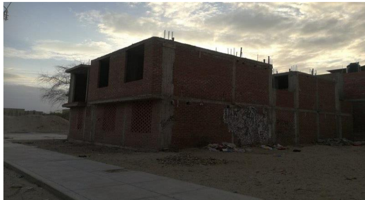
Gráfico 3: Albañilería confinada.
