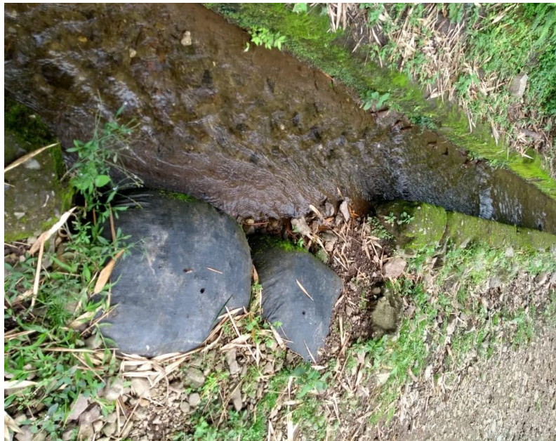
Gráfico 8: Desprendimiento en concreto.
