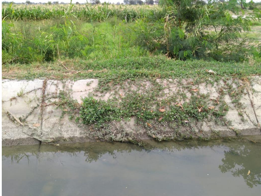
Gráfico 96: Presencia de vegetación en losa lateral del canal
