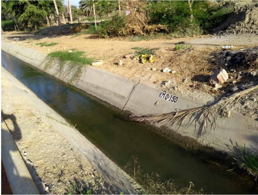
Gráfico 3: Canal de concreto.
