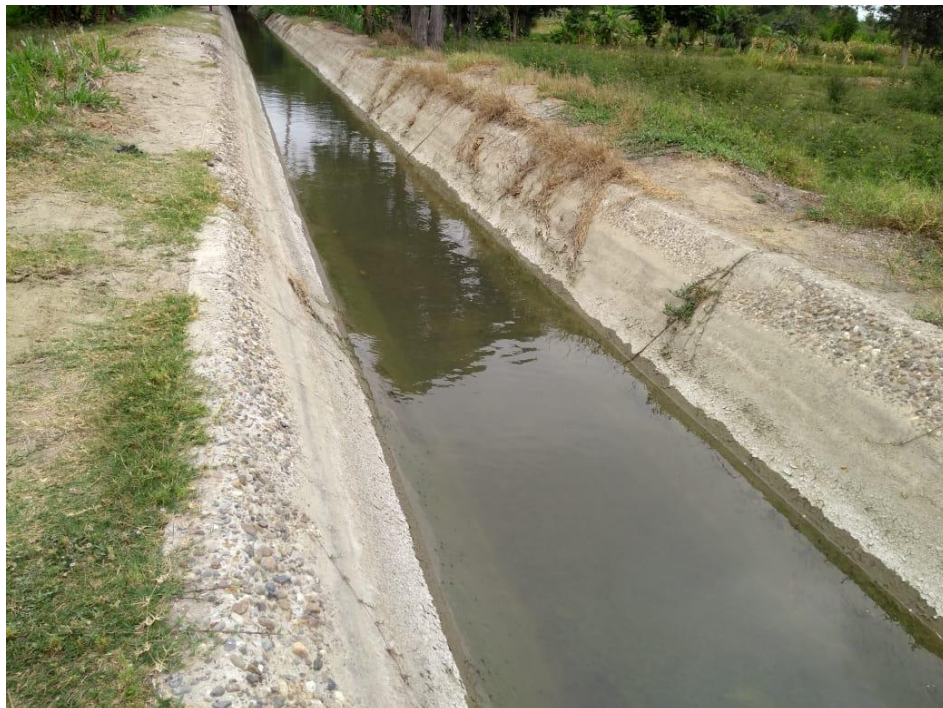
Gráfico 95: Determinando la sedimentación de sólidos en la estructura del canal
