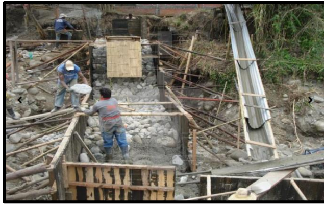
Figura 18. Construcción de muro de concreto ciclópeo sobre lecho del río – Cali - Colombia. Fuente: Tikal (2014).
