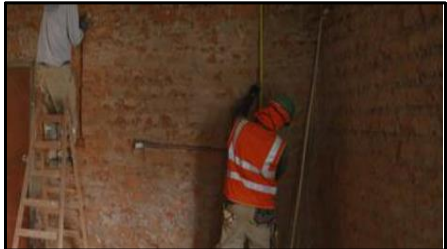
Figura 7. Albañilería en una vivienda – Piura - Perú. Fuente: Ministerio de vivienda (2015).
