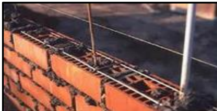
Figura 10. Ensayo de muro de albañilería armada – Chile. Fuente: Astrosa (2014).
