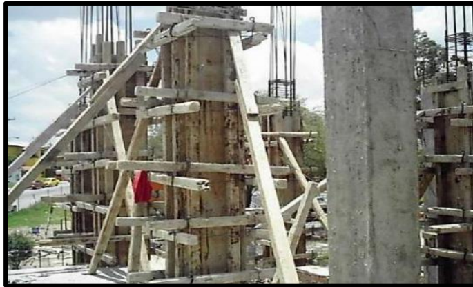
Figura 14. Procedimientos constructivos, columnas – Argentina. Fuente: Ramirez (2014).
