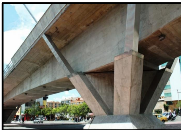
Figura 20. Durabilidad del tubo de concreto – Islas Canarias-España. Fuente: Exposito (2018).
