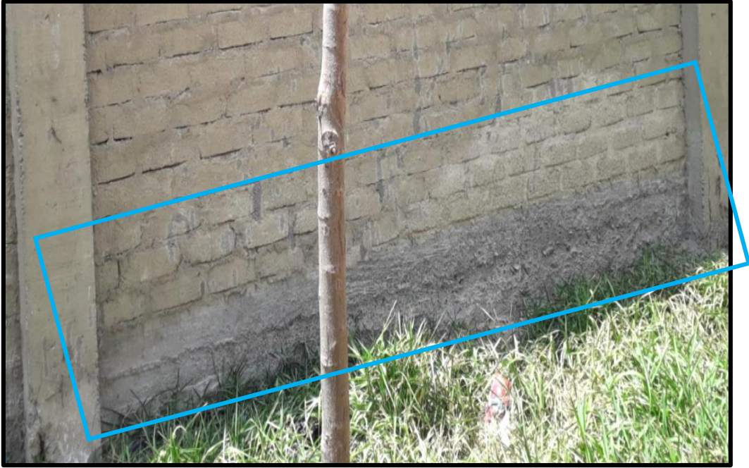
Imagen 6: Eflorescencia en la unidad de muestra 14.
