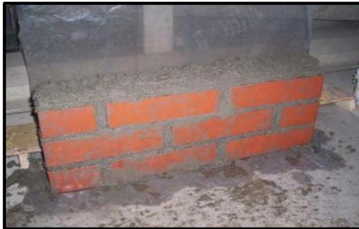
Figura 8. Reparación de muros de albañilería – Valdivia - Chile. Fuente: Peña (2016).
