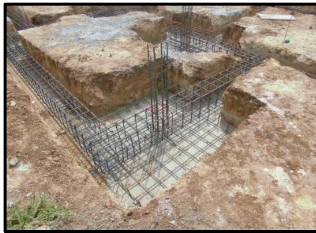
Figura 11. Construcción de cimientos – España. Fuente: Valderas (2013).
