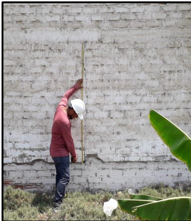
Imagen 9: Determinación de la longitud de la grieta en la unidad de muestra 1.
