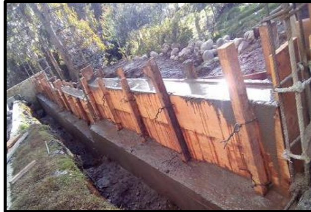
Figura 12. Rehabilitación de cerco perimétrico de puesto de salud – Huancavelica - Perú. Fuente: Sub región Acobamba (2017).
