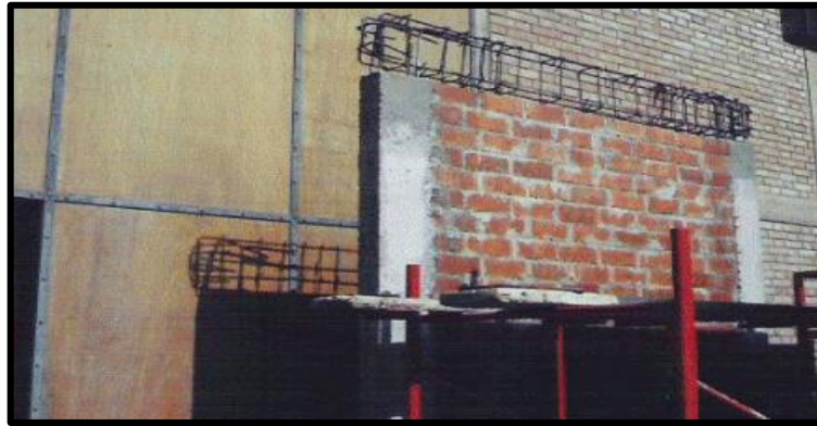
Figura 9. Reparación de un muro de albañilería confinada– Perú. Fuente: Loaysa (2014).
