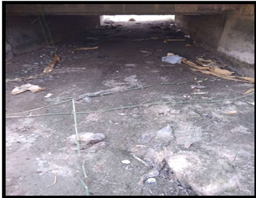
Figura 13: Sedimentación en canal de concreto.
