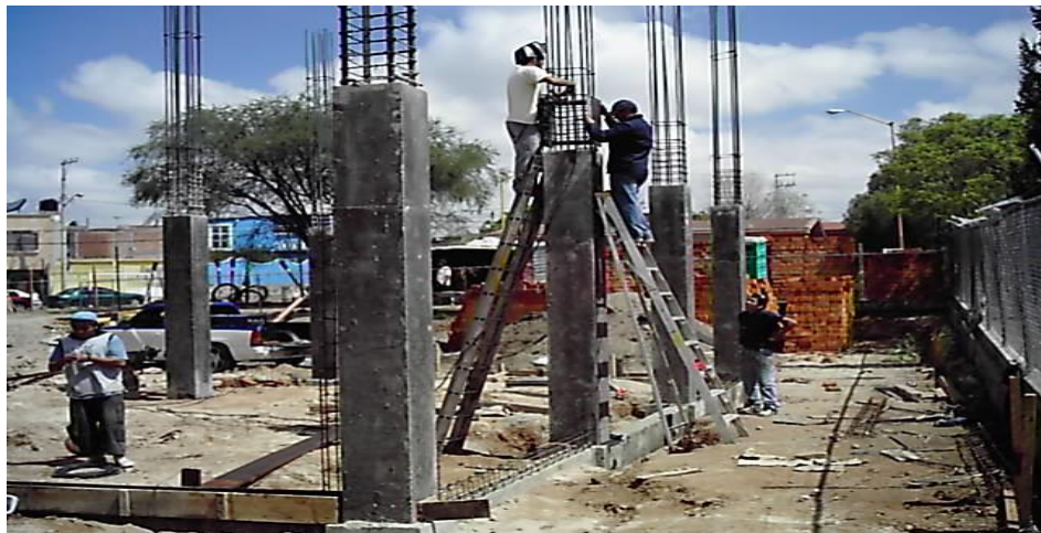
Figura 08: Columnas de un cerco perimétrico
