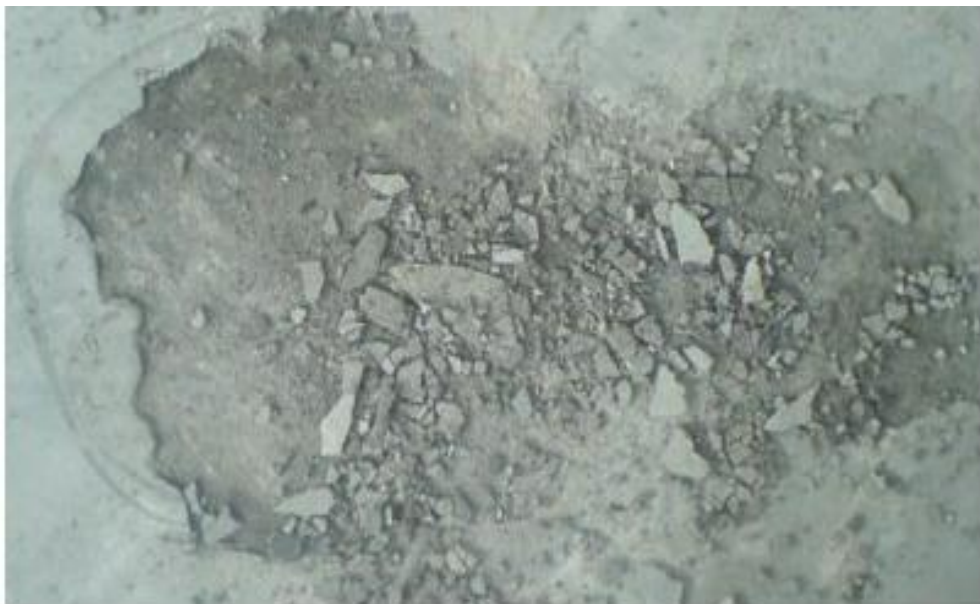
Figura 12: Delaminación
