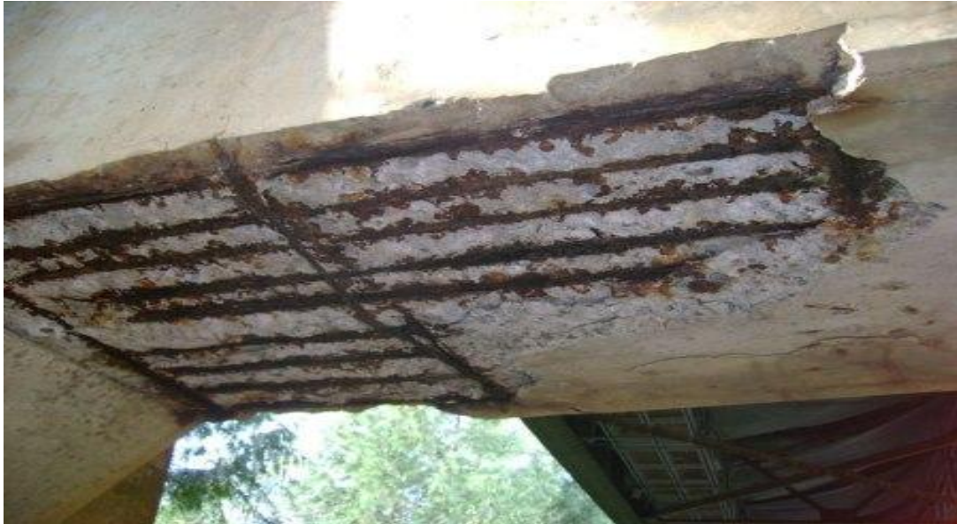
Figura 14: Corrosión
