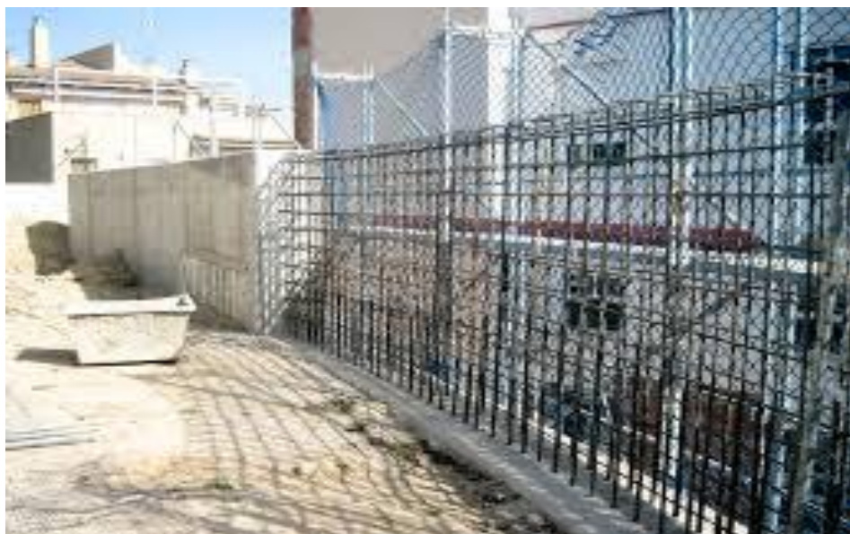
Figura 03: Elementos de acero reforzando el muro.
