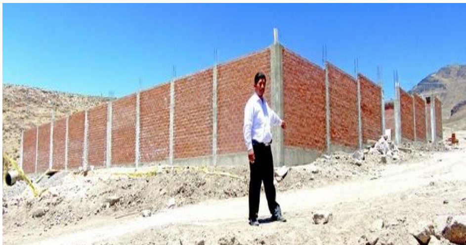
Figura 07: Muro de tipo bloque de concreto de un cerco perimétrico.
