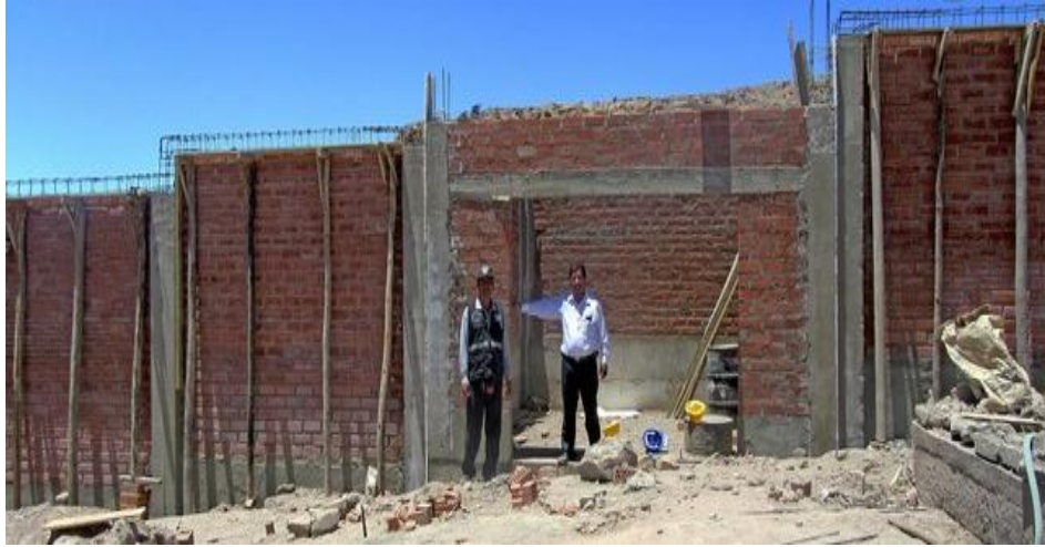
Figura 06: Vigas de concreto armado de un cerco perimétrico.
