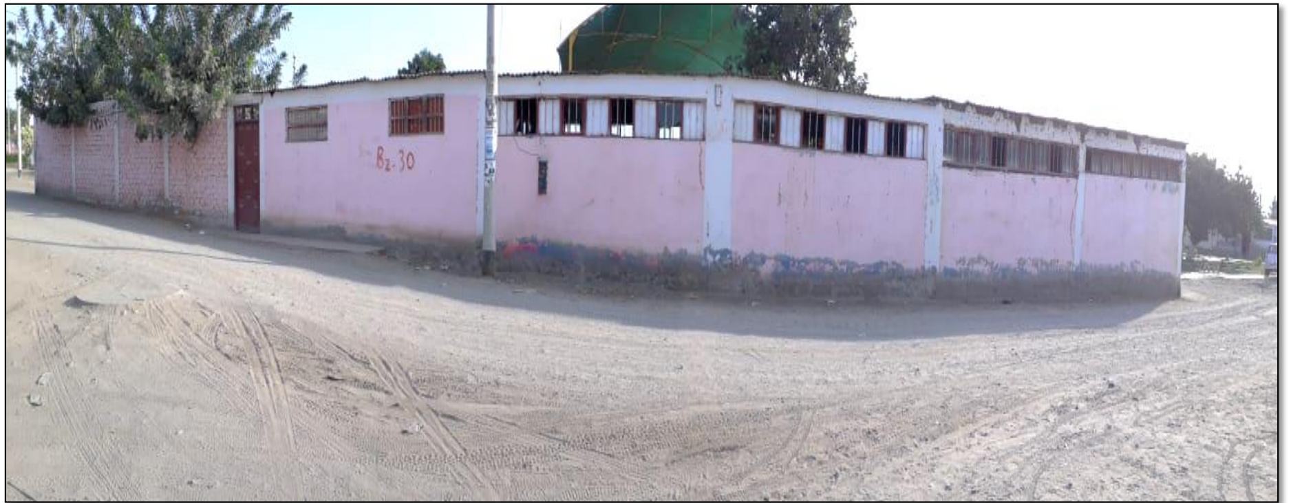
Fotografía 2: Eje exterior 1-2 del cerco perimétrico de la Institución Educativa N° 88333 El Castillo.
