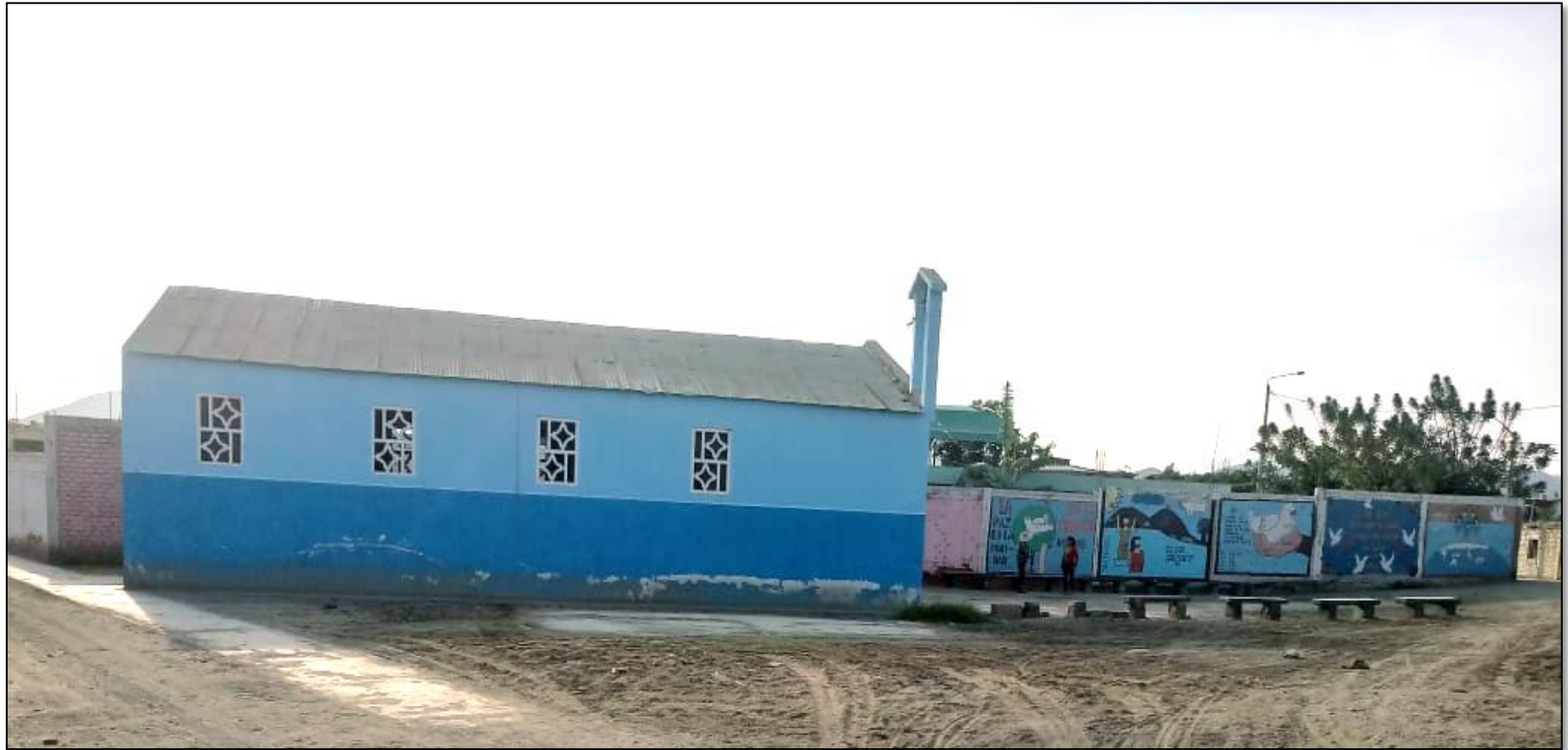
Fotografía 5: Eje exterior 9-10 del cerco perimétrico de la Institución Educativa N° 88333 El Castillo.
