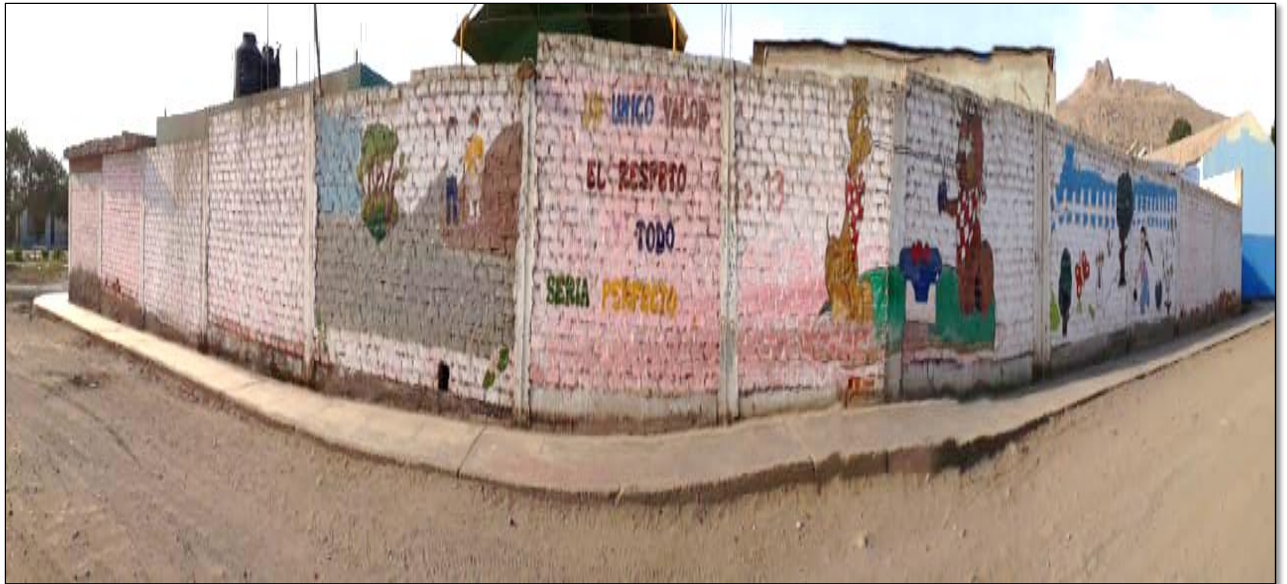
Fotografía 4: Eje exterior 5-8 del cerco perimétrico de la Institución Educativa N° 88333 El Castillo.
