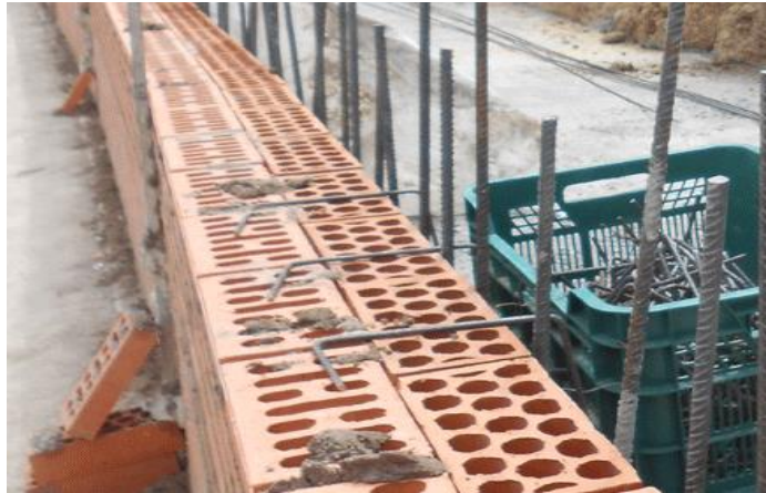
Figura 2. Albañilería reforzada. Nota. Fuente: Pérez A. (2015).
