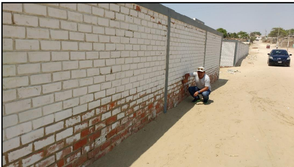
Grafico N° 88. Patología de Delaminación. Fuente Propia.
