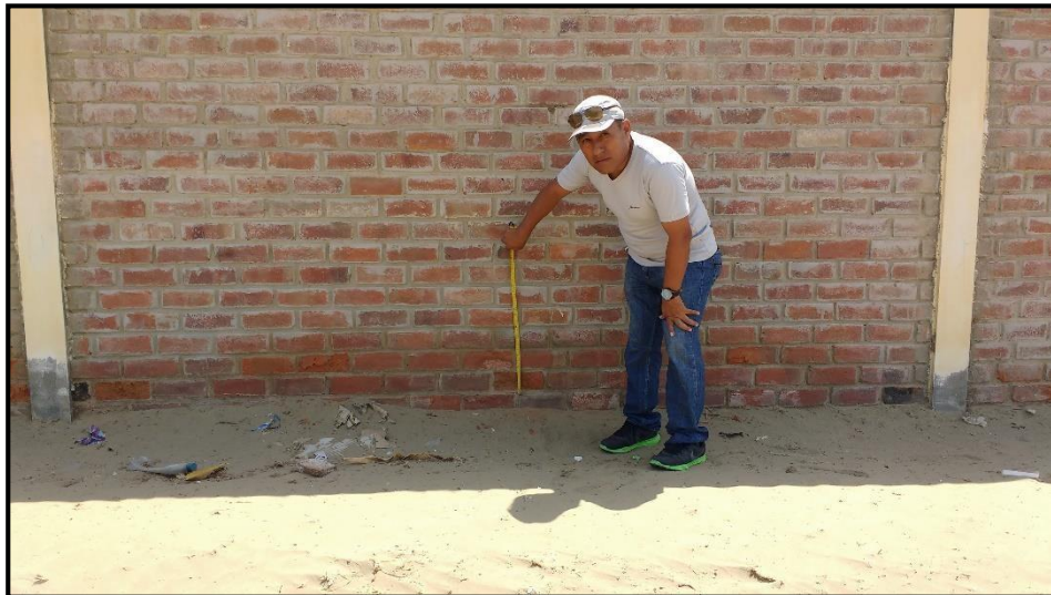
Grafico N° 92. Patología de Exudación. Fuente Propia.
