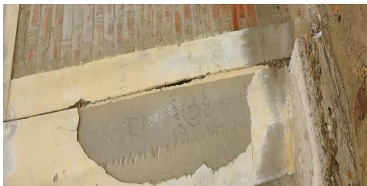
Grafico N° 11. Delaminación. Fuente Propia
