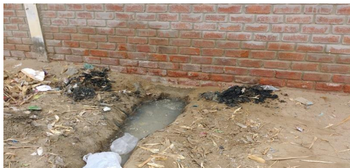
Grafico N° 20. Filtración. Fuente Propia. Fuente Google
