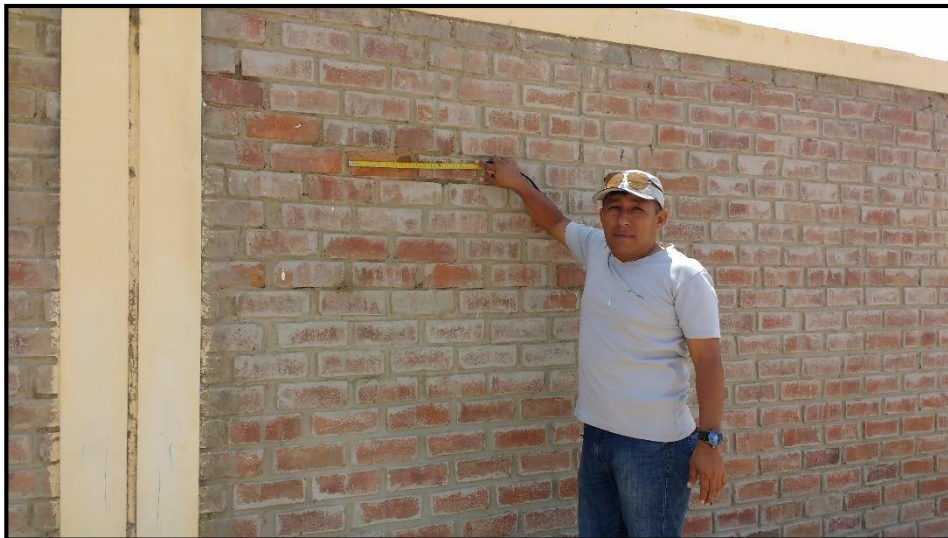
Grafico N° 93. Patología de Delaminación. Fuente Propia.
