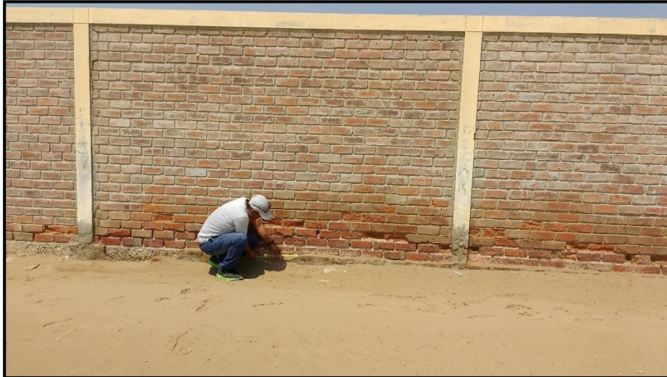
Grafico N°95: Patología de Delaminación. Fuente Propia.
