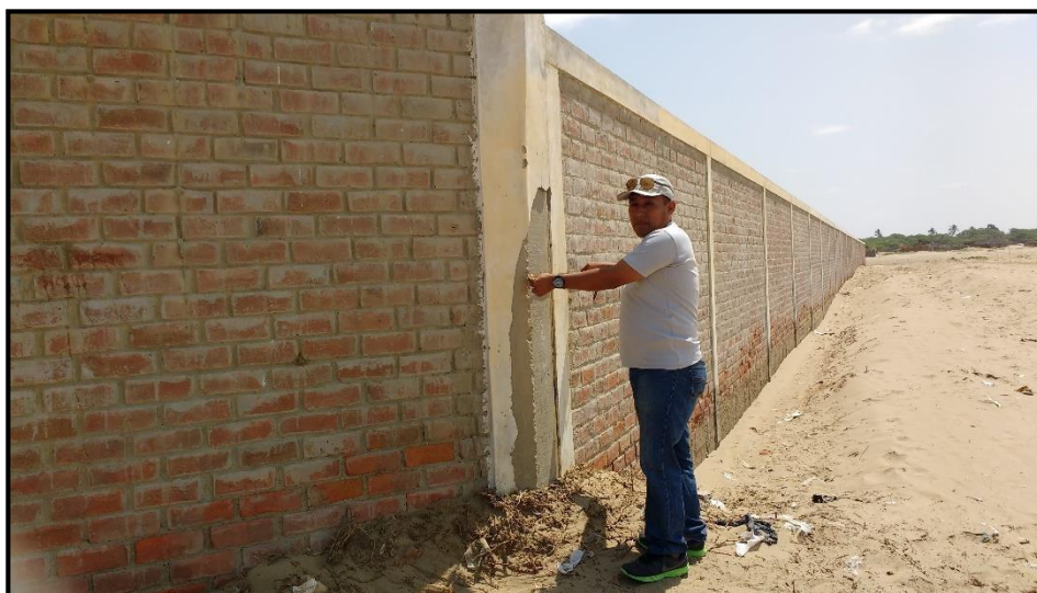
Grafico N° 97. Patología de Delaminación moderada en una columna. Fuente Propia.
