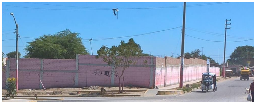
Figura 5: Muro no portante.
