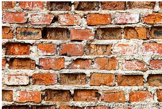
Figura 21: Erosión química.
