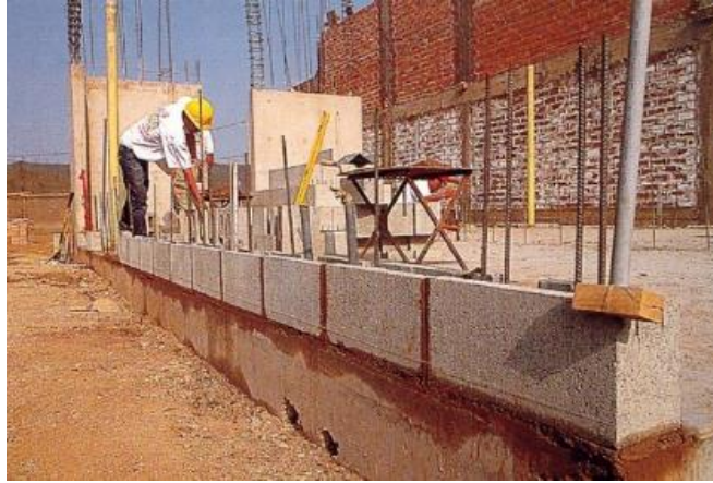
Figura 4: Albañilería armada.
