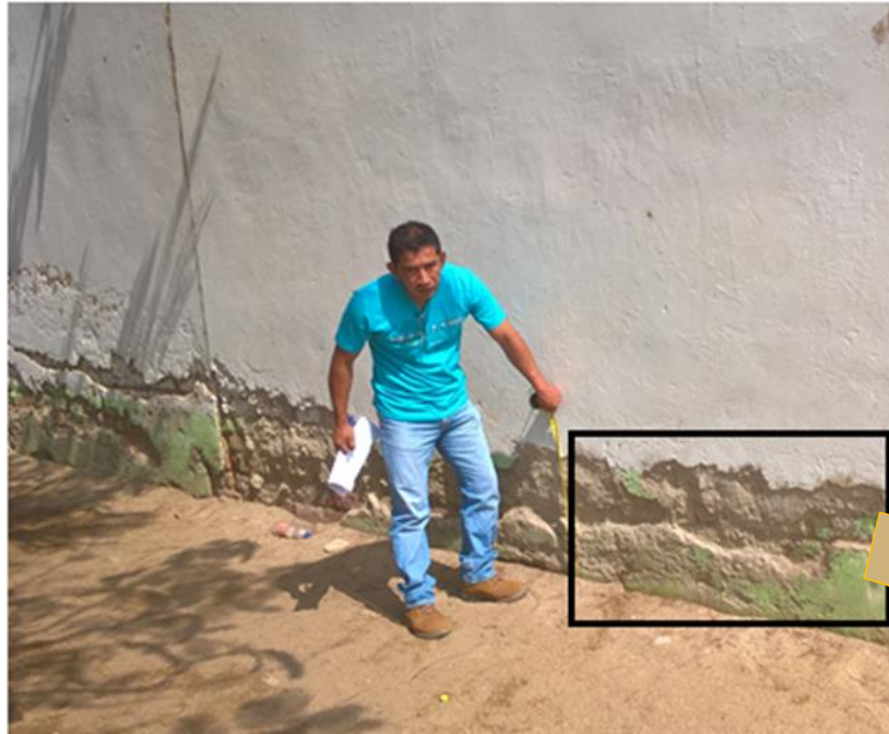
Imagen 02. Muestra 02, desprendimiento.
