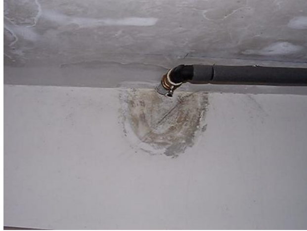
Figura 16: Humedad accidental.
