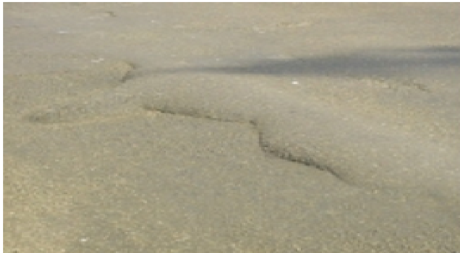
Foto N° 12 Hundimientos (tipo asentamiento diferencial).
