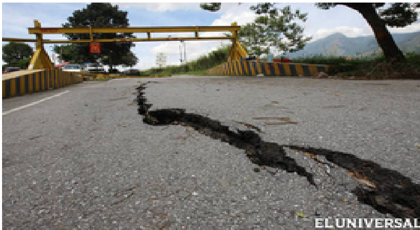
Foto N° 12 Hundimientos (tipo asentamiento diferencial).
