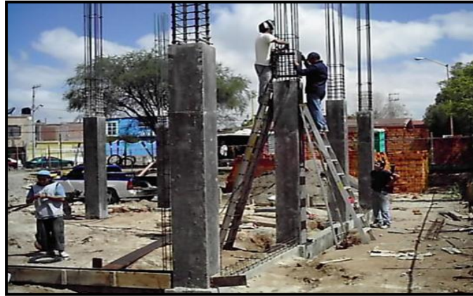
Imagen N° 12: Columna de concreto armado.
