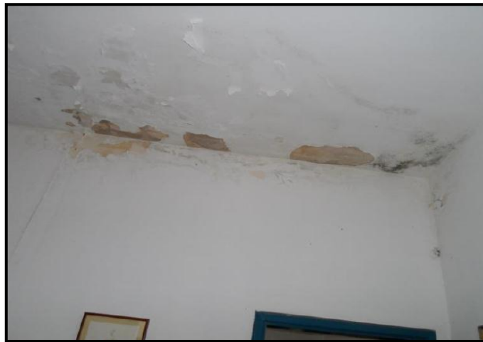
Imagen N° 03: Filtración en habitación 1, deterioro y desprendimiento de la pintura.
