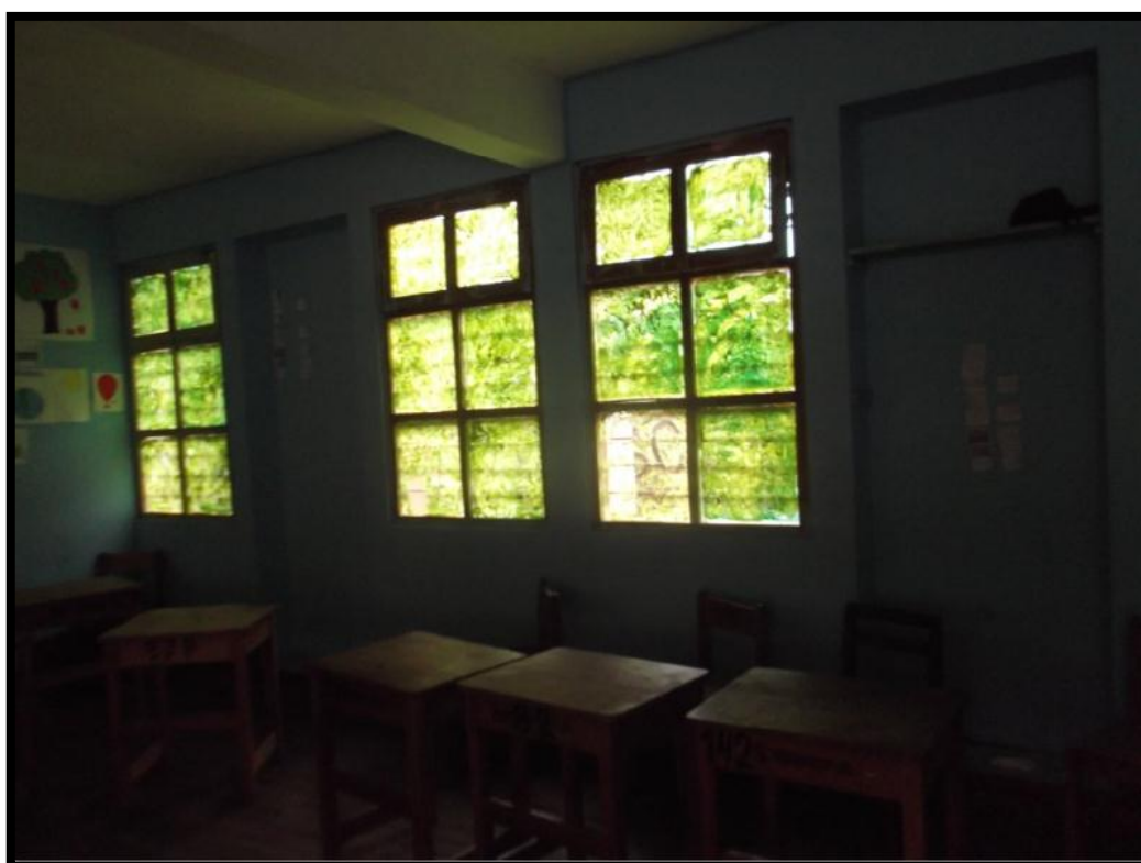
Foto N° 4 Vista panorámica interna del aula de la I.E.P. “General Córdova”
