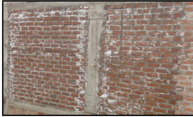
Imagen N° 35: Las patologías presentes en este muro se ven la eflorescencia.
