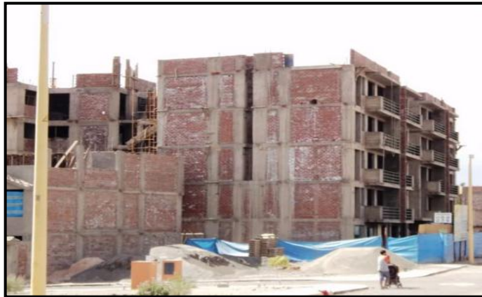
Imagen N° 11: Elemento de concreto armado
