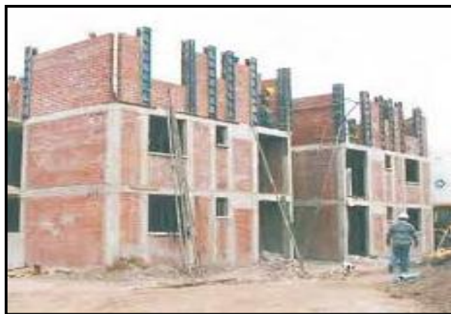
Imagen N° 06: edificación construida mediante sistema confinada.
