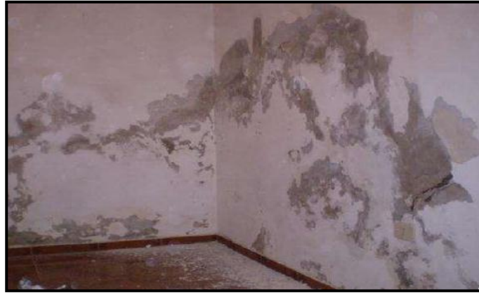
Imagen N° 22: efectos de la humedad
