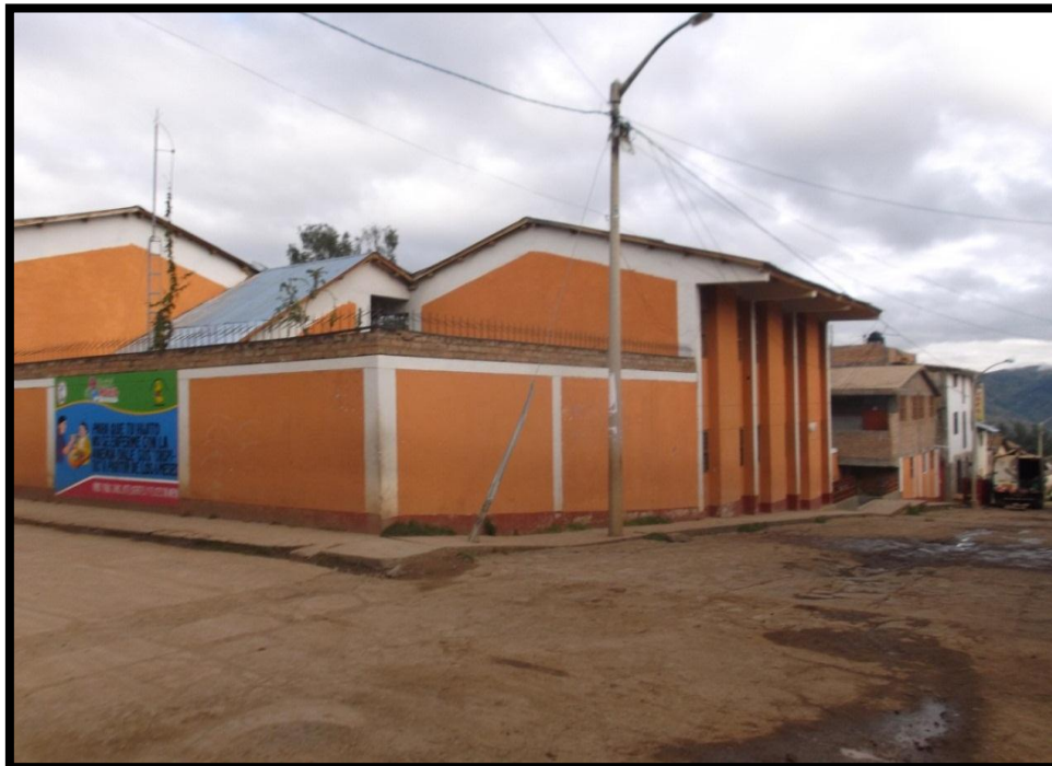
Foto N° 2 Vista Lateral de la I.E.P. "General Córdova"
