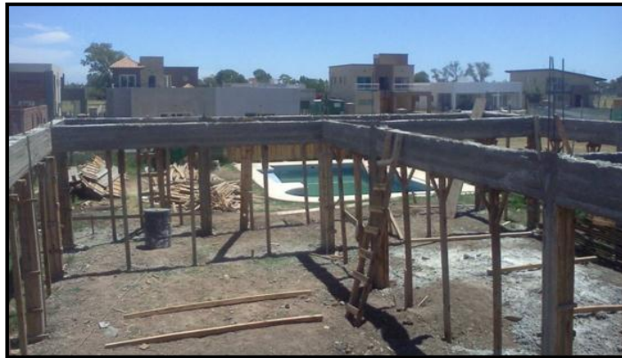
Imagen N° 16: Vigas de concreto armado
