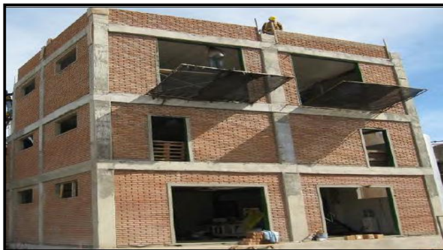
Imagen N° 15: Edificación construida mediante sistema confinado.
