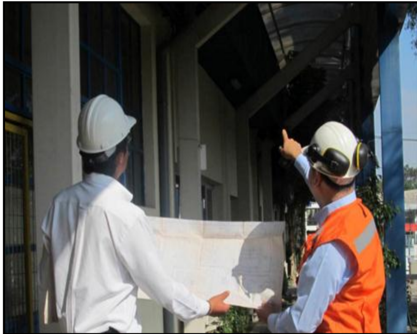
Imagen N° 37: Control de calidad
