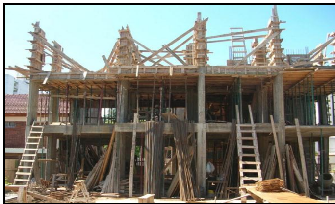
Imagen N° 13: Columnas a porticadas.
