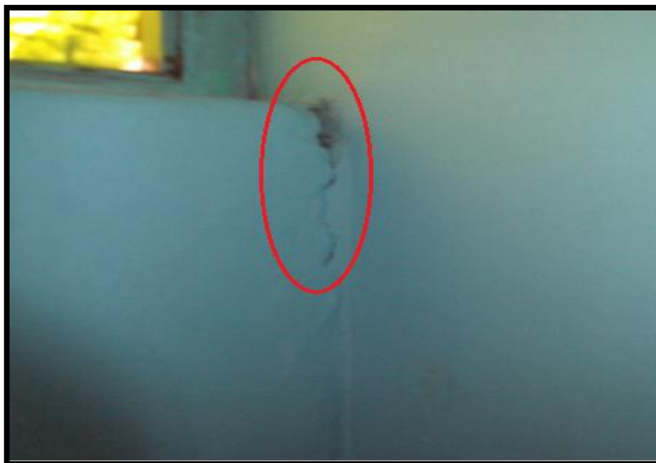
Foto N° 5 S e observa una grieta de la separación entre el muro vertical y la columna.
