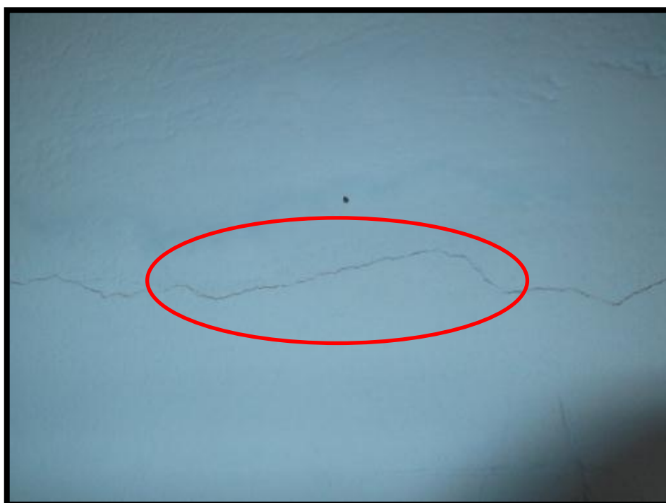
Foto N° 6 S e observa fisura vertical en el muro de la primera planta.
