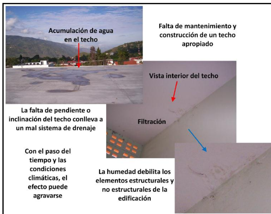
Imagen N° 21: Filtraciones que causan humedad en techo
