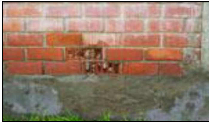
Imagen N° 23: Humedad capilar
