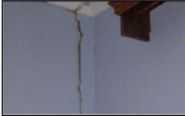
Imagen N° 01: Grieta vertical superior en un muro interior.
