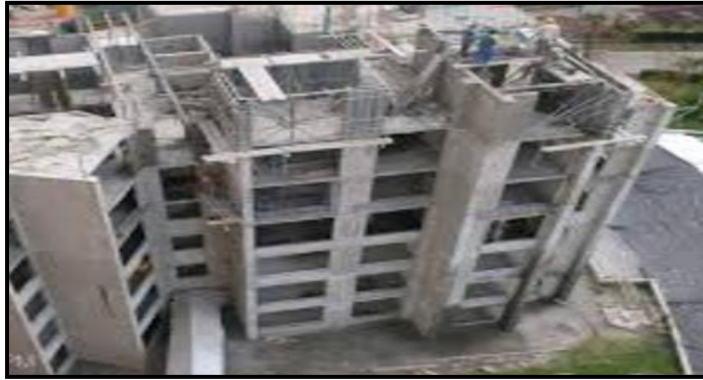
Imagen N° 14: Columnas a porticadas.
