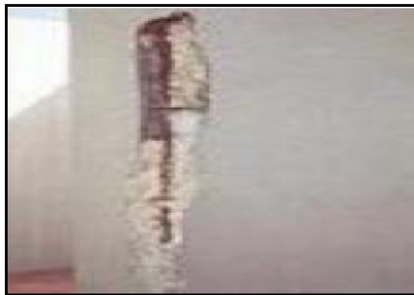
Imagen N° 31: Fisuración debida a corrosión de las armaduras
