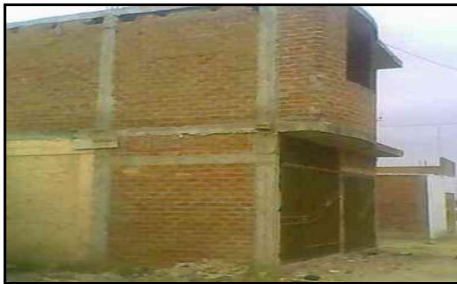
Imagen N° 09: Muros portante, construcciones en la ciudad de Ayacucho
