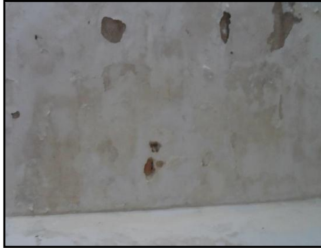
Imagen N° 02: Filtración en habitación 1, desprendimiento de la pintura.
