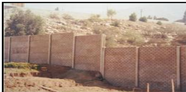
Imagen N° 08: Muros no portantes
