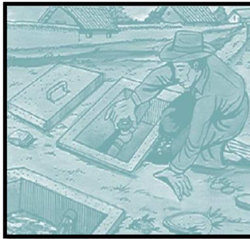
Imagen 4: Válvula de purga
