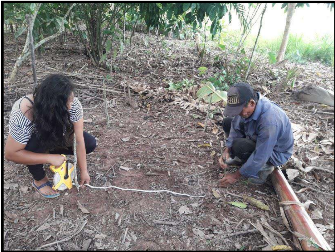
Figura 27: Trazo para la elaboración de calicatas.. Fuente: Elaboración propia
