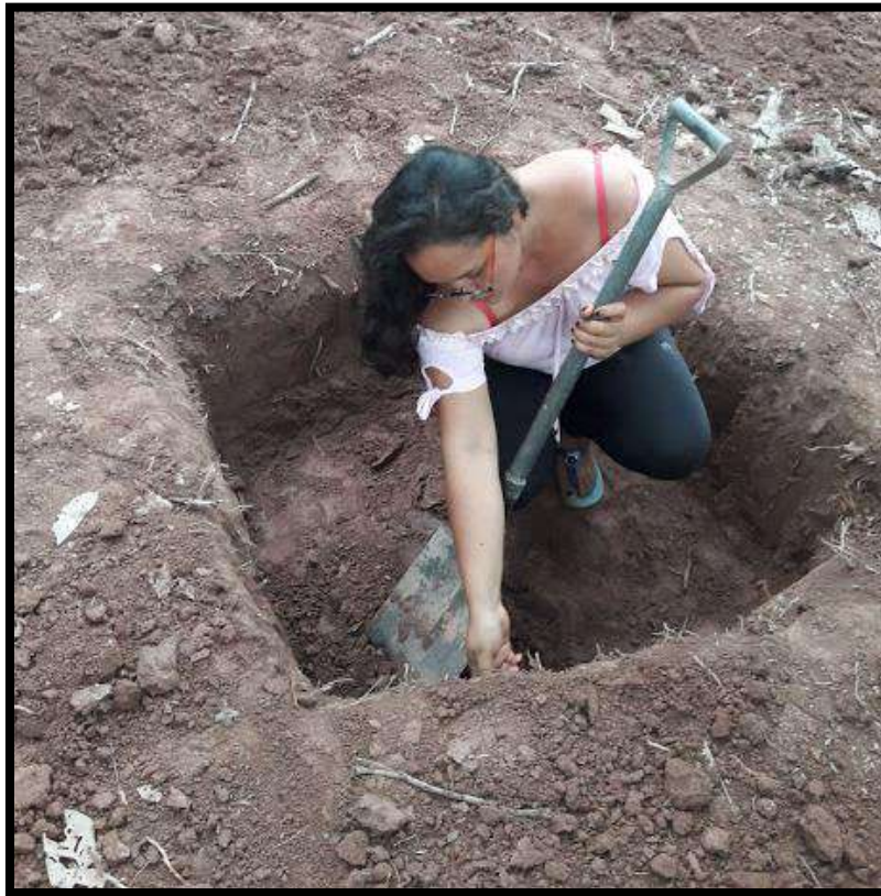
Figura 27: Elaboración de la calicata a 30 cm de profundidad Fuente: Elaboración propia
