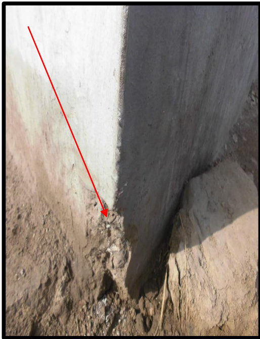
Imagen N° 18 y 19: unidades muestrales 1 y 2 en el tramo A-B, se muestra Desintegración (patología 5) localizada en sobrecimiento y columna.
