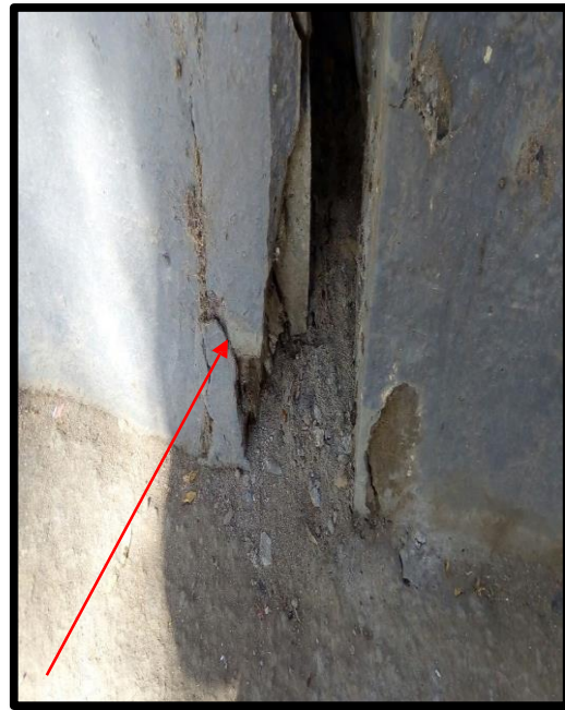
Imagen N° 16 y 17: unidades muestrales 13,14 en el tramo E-F, se muestra Desprendimiento (patología 4) localizada en sobrecimiento y columna.
