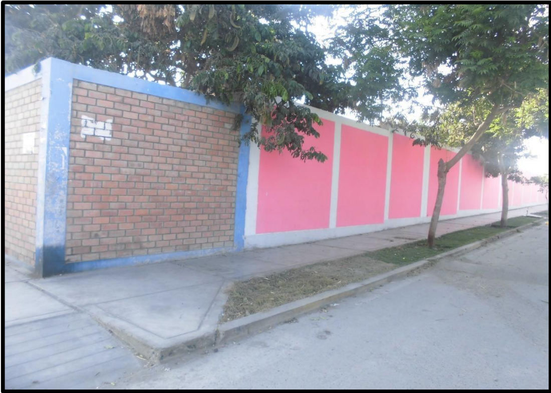
Imagen 03: Vista del tramo 3-4 del cerco perimétrico.
