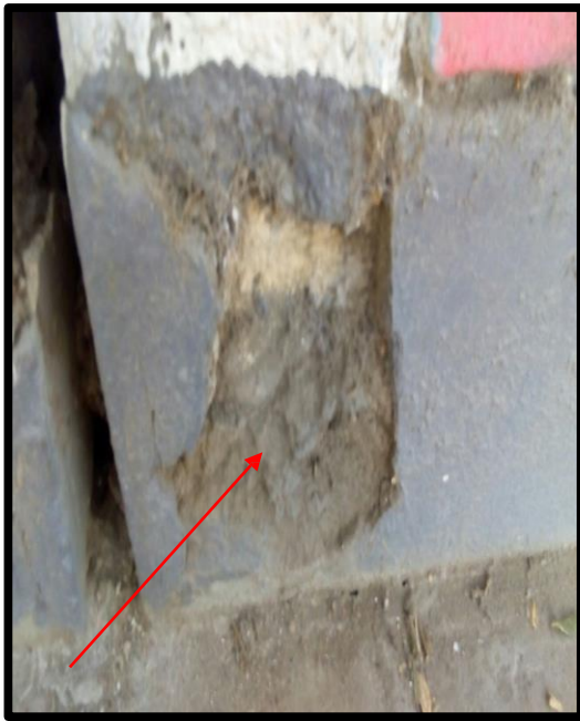
Imagen N° 16 y 17: unidades muestrales 13,14 en el tramo E-F, se muestra Desprendimiento (patología 4) localizada en sobrecimiento y columna.
