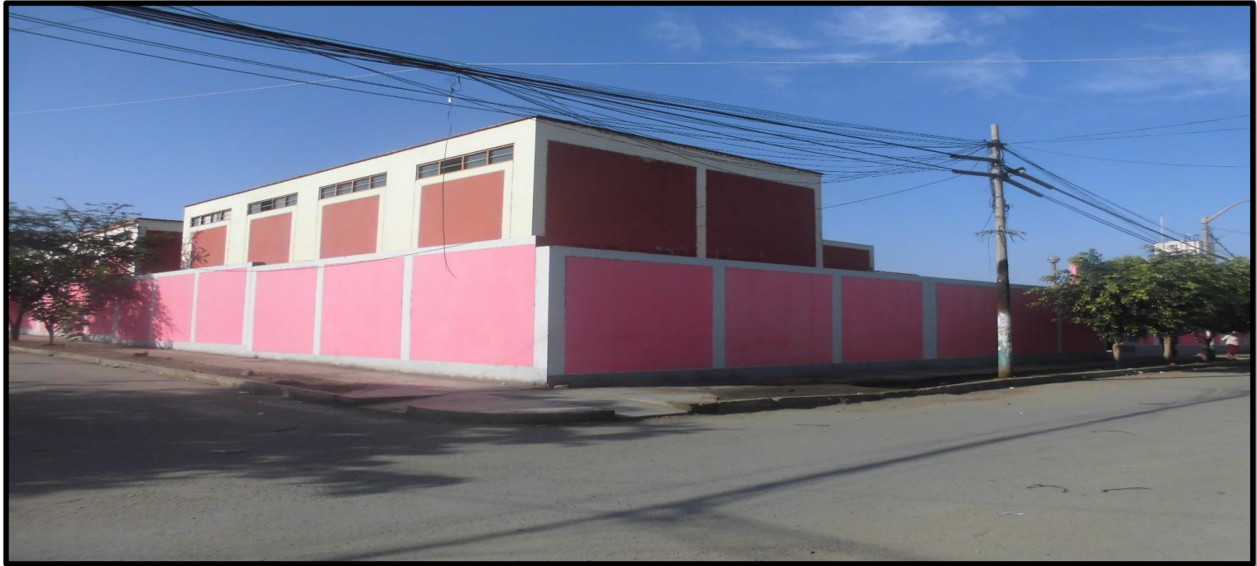
Imagen N° 01: Vista exterior de las estructuras de albañilería confinada del cerco perimétrico de la institución educativa Carlos Aramburu Elejalde, jirón Enrique Palacios, sector San Carlos, distrito de Santa, provincia del Santa, región Ancas
