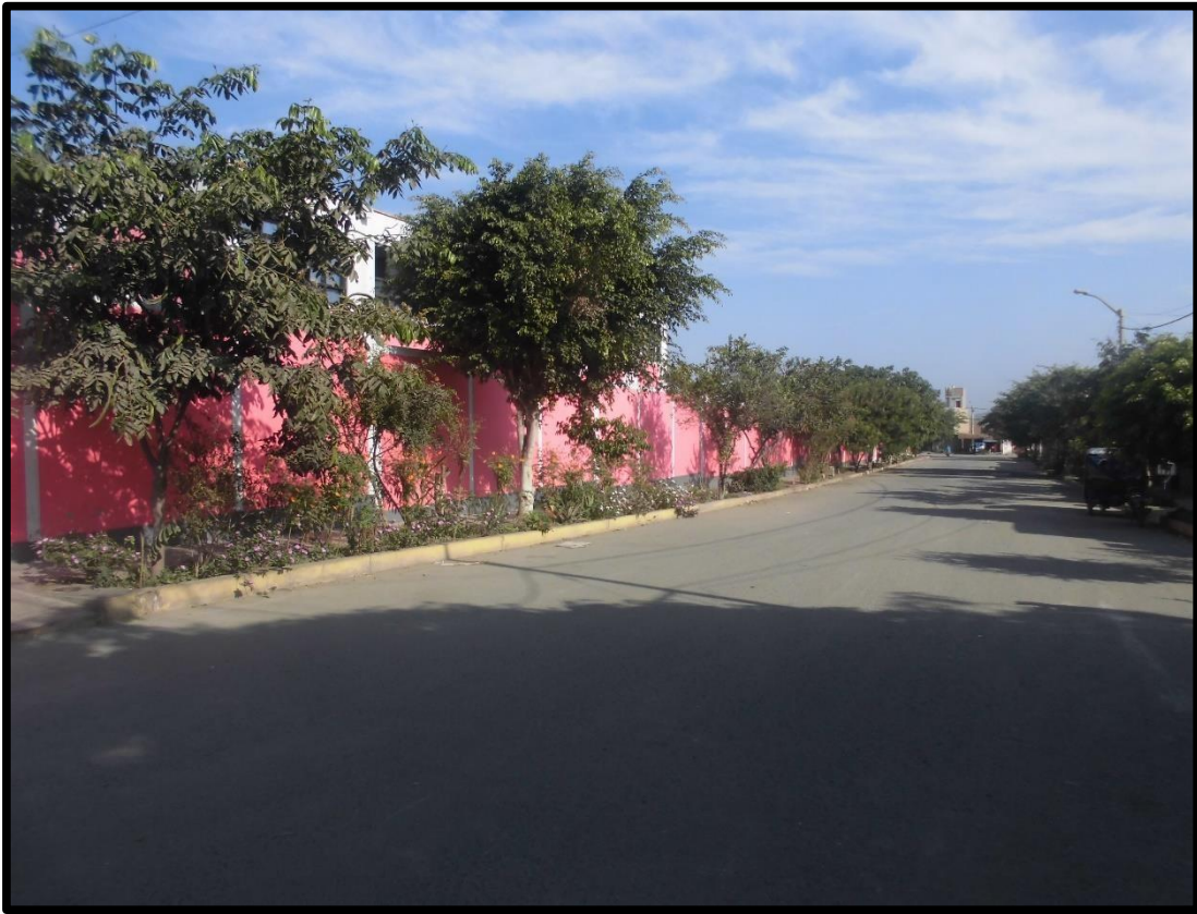
Imagen 05: Vista panorámica del tramo 5-6 del cerco perimétrico.
