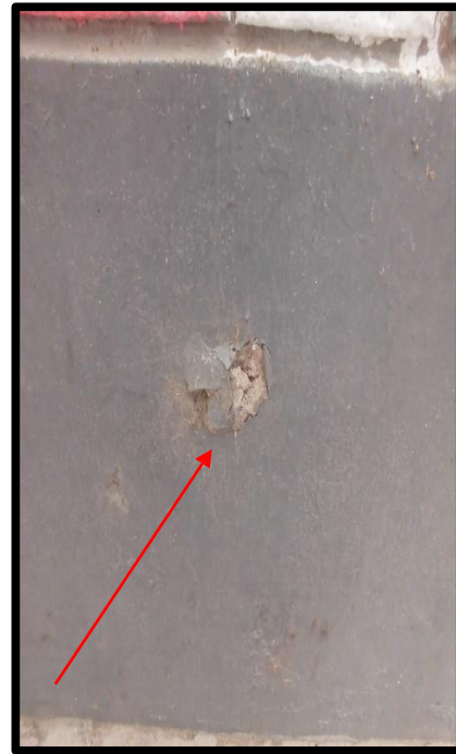
Imagen N° 14 y 15: unidad muestral 13 en el tramo E-F, se muestra descascaramiento (patología 3) localizada en sobrecimiento.
