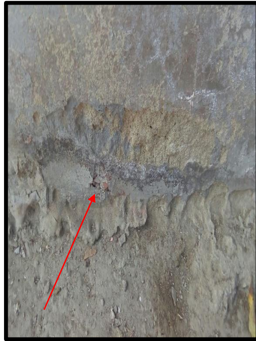
Imagen N° 18 y 19: unidades muestrales 1 y 2 en el tramo A-B, se muestra Desintegración (patología 5) localizada en sobrecimiento y columna.
