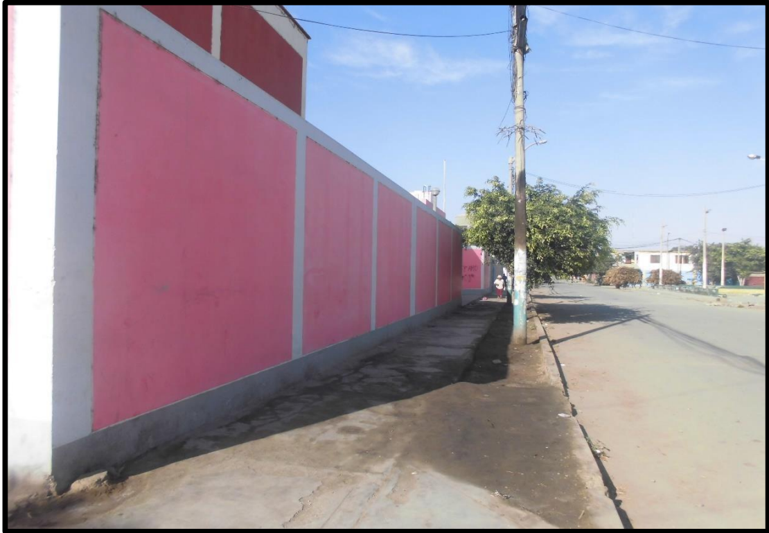
Imagen 04: Vista del tramo 1-2 del cerco perimétrico.
