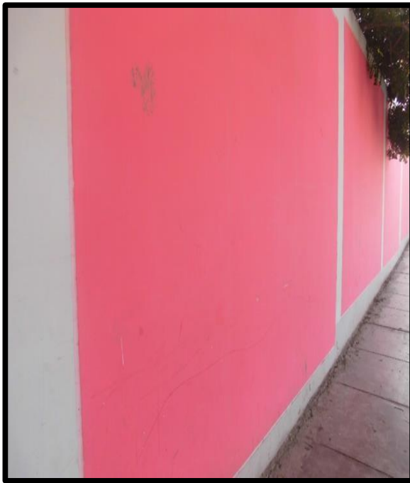
Imagen N° 12 y 13: Unidad muestral 9 en el tramo C – D, se muestra Fisura (patología 2) localizada en muro.
