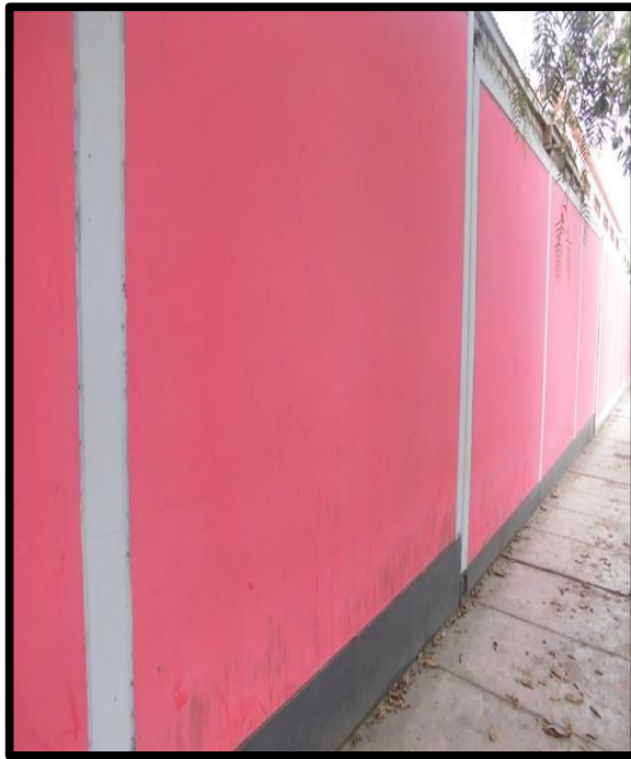
Imagen N° 14 y 15: unidad muestral 13 en el tramo E-F, se muestra descascaramiento (patología 3) localizada en sobrecimiento.
