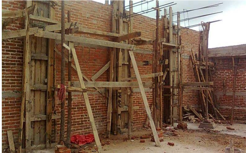
Gráfico 8: Columnas confinadas en proceso constructivo. Fuente: Elaboración Propia (2015).
