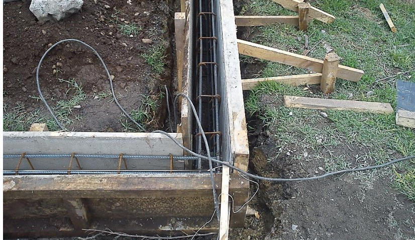
Gráfico 7: Sobrecimiento en proceso constructivo. Fuente: Elaboración Propia (2016).
