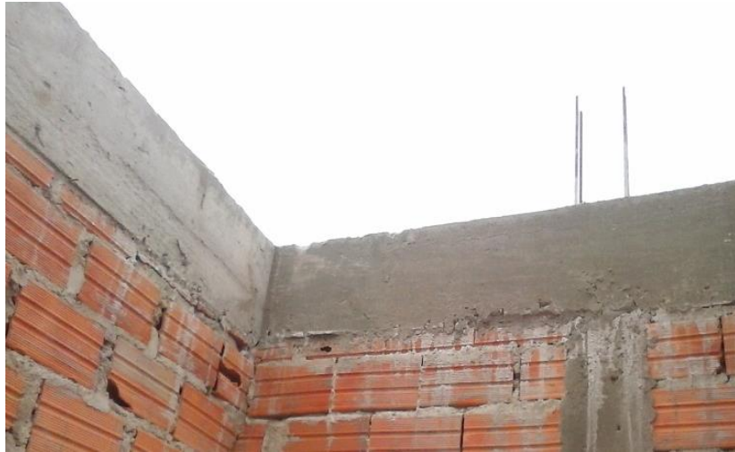
Gráfico 9: Vigas confinadas en proceso constructivo. Fuente: Elaboración Propia (2015).
