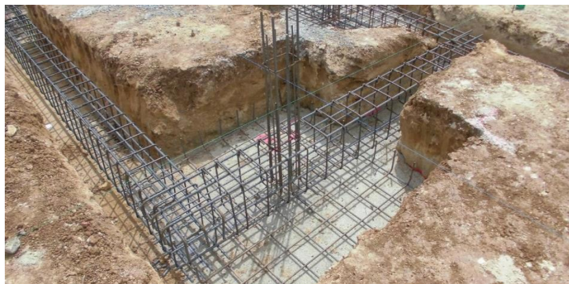
Gráfico 6: Cimentación en proceso constructivo. Fuente: Elaboración Propia (2016).
