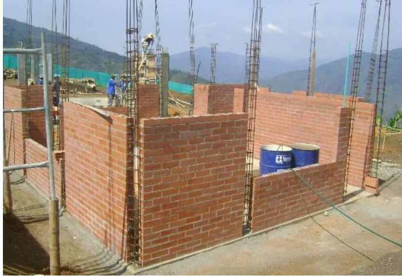
Gráfico 10: Muros de mampostería en proceso constructivo. Fuente: Elaboración Propia (2015).
