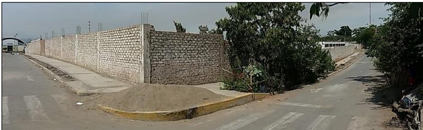
Fotografía 2: Vista panorámica – Tramo B y C de la Inst. Educativa 88217.
