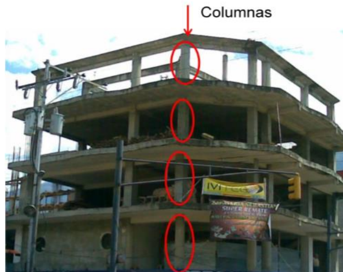
Figura 5. Columnas de Concreto Armado
