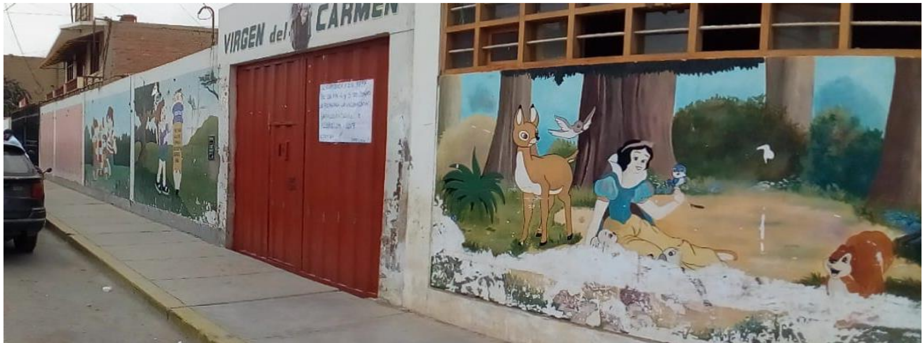
Fachada del cerco perimétrico del Jardín de Niños 1950 – Virgen del Carmen del Distrito de Huarney, Provincia de Huarney, Región de Ancash
